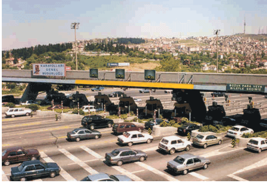
Şekil 3.7 : Boğaziçi Köprüsü'nde OGS gişeleri [33].
