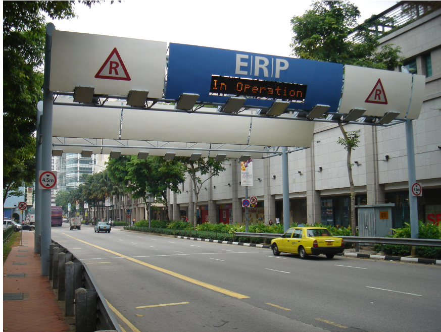
Şekil 3.8 : Singapur'daki elektronik tahsilât uygulamasında yol üstü antenleri [34].
