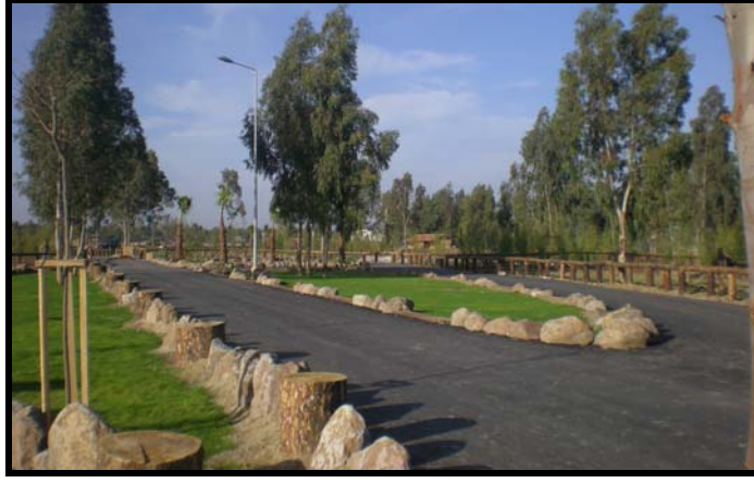
Şekil 4.45. Yeşil alan ile asfalt yol arasında yapılan uygulama (Oriş., 2011).
