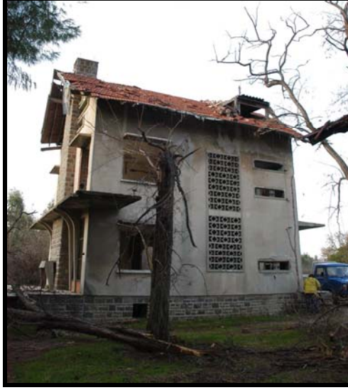
Şekil 3.2. Proje öncesi konut binası (Orjinal, 2005).
