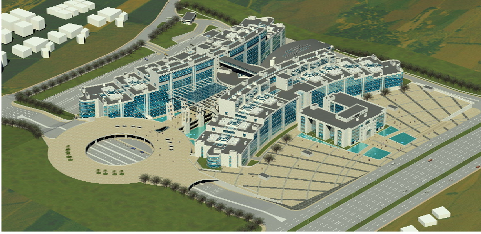
Şekil 3.1 : İstanbul Anadolu Yakası Adliye Binası
