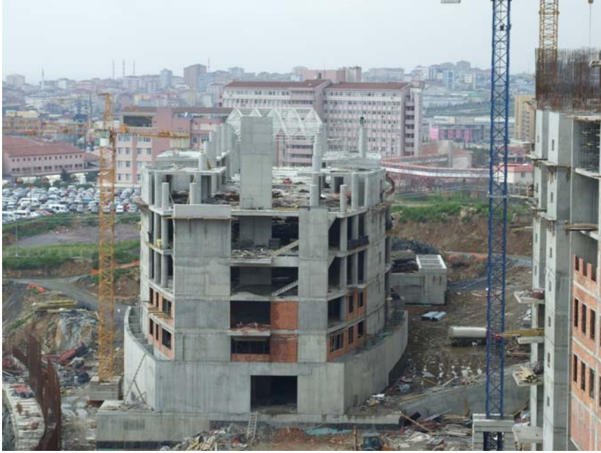
Şekil 3.8 : D Blok 07.04.2009 İnşaat Görüntüsü
