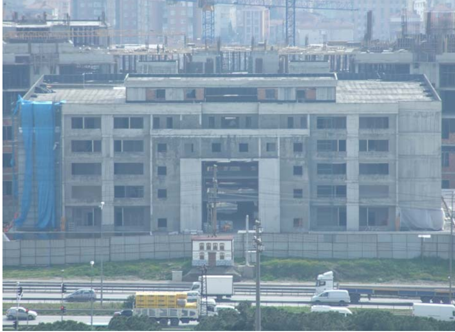
Şekil 3.6 : E Blok 07.04.2009 İnşaat Görüntüsü
