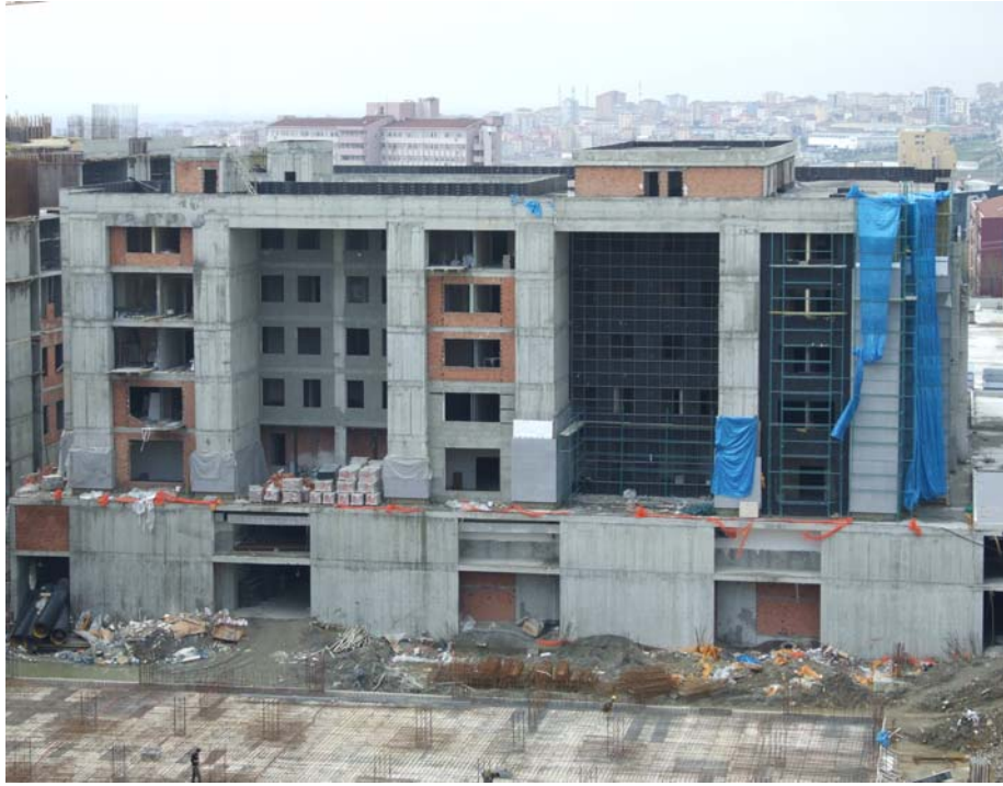
Şekil 3.7 : E Blok 07.04.2009 Dış Cephe İmalat Görüntüsü
