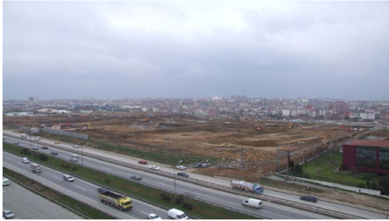
Şekil 3.3 : Aralık 2006'ya ait Kazı Görüntüsü
