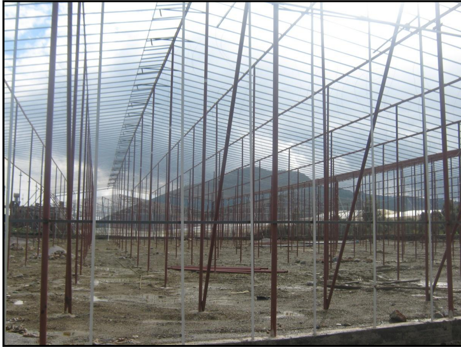
Fotoğraf 45: Mersin (Anamur)’de İstenilen Boyutlara Göre Sipariş Edilen Cam Sera İskeletinin Kurulumundan Bir Görünüm
