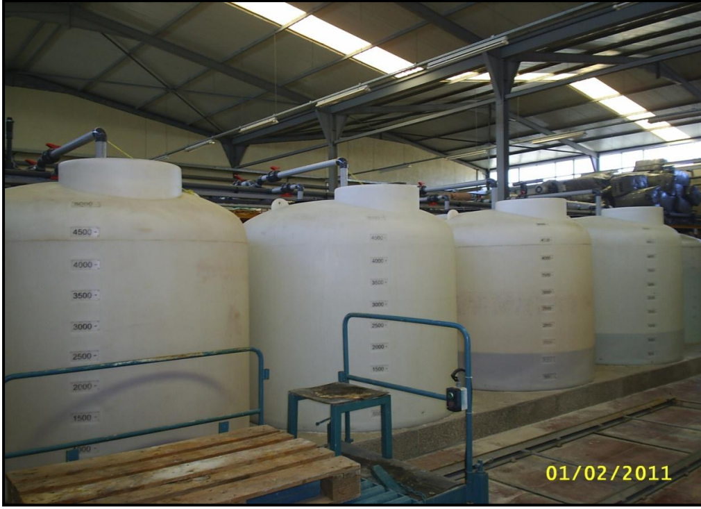
Fotoğraf 63: Antalya (Alanya)'daki Modern Bir Örtüaltı Yetiştiricilik Tesisindeki Likit Gübre Tankları
