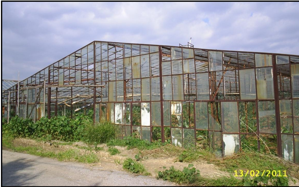
Fotoğraf 39: İzmir (İnciraltı)’de Yaşanan Bir Dolu Olayının Ardından Kullanılamaz Hale Gelmiş Bir Cam Sera
