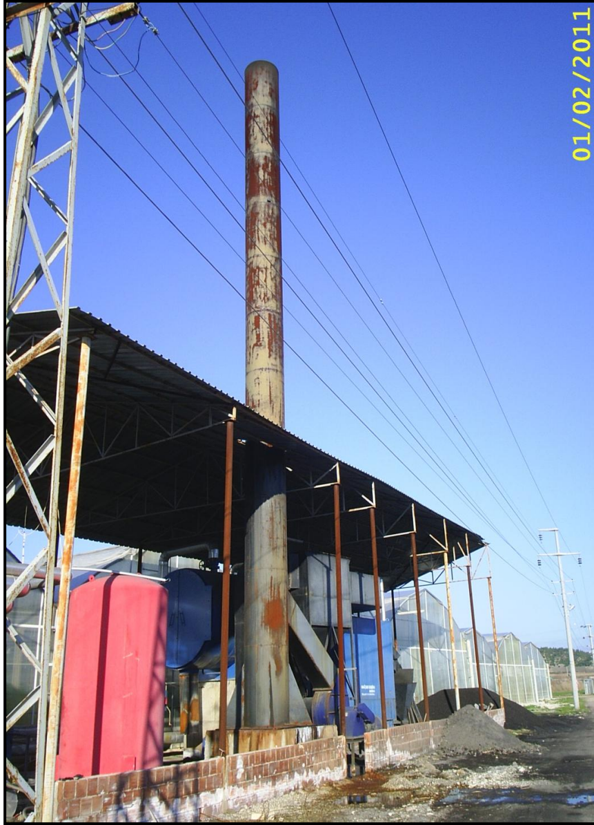
Fotoğraf 47: Denizli (Gölemezli)'deki Plastik Seraların Isıtılmasında Linyit Kullanılan Kalorifer Sistemi
