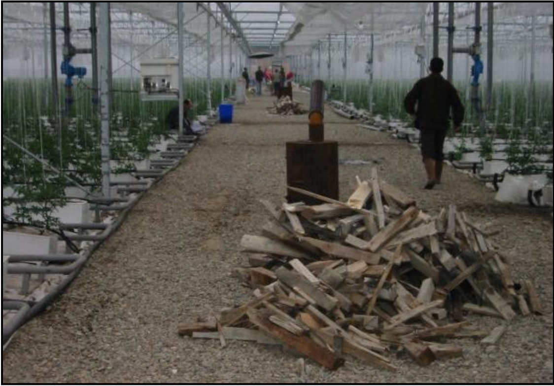
Fotoğraf 46: Antalya (Kumluca)'da Sobalarla Yapılan En Basit Isıtma Yönteminden Bir Görünüm (Yakıt olarak odun kullanılmaktadır).
