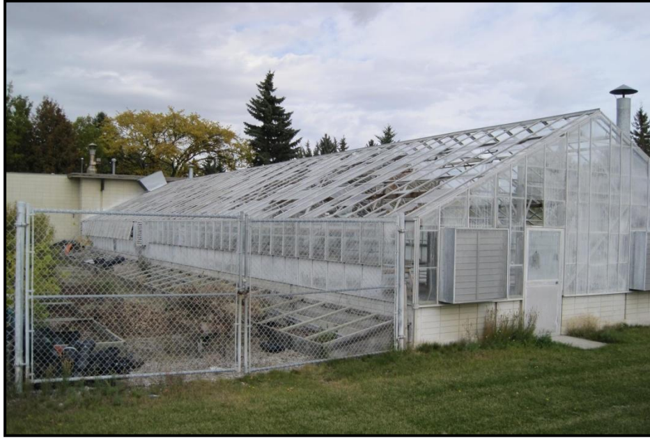
Fotoğraf 27: Yaşanan Dolu Olayından Sonra Ciddi Ölçüde Tahrip Olmuş Cam Seradan Bir Görünüm 28
