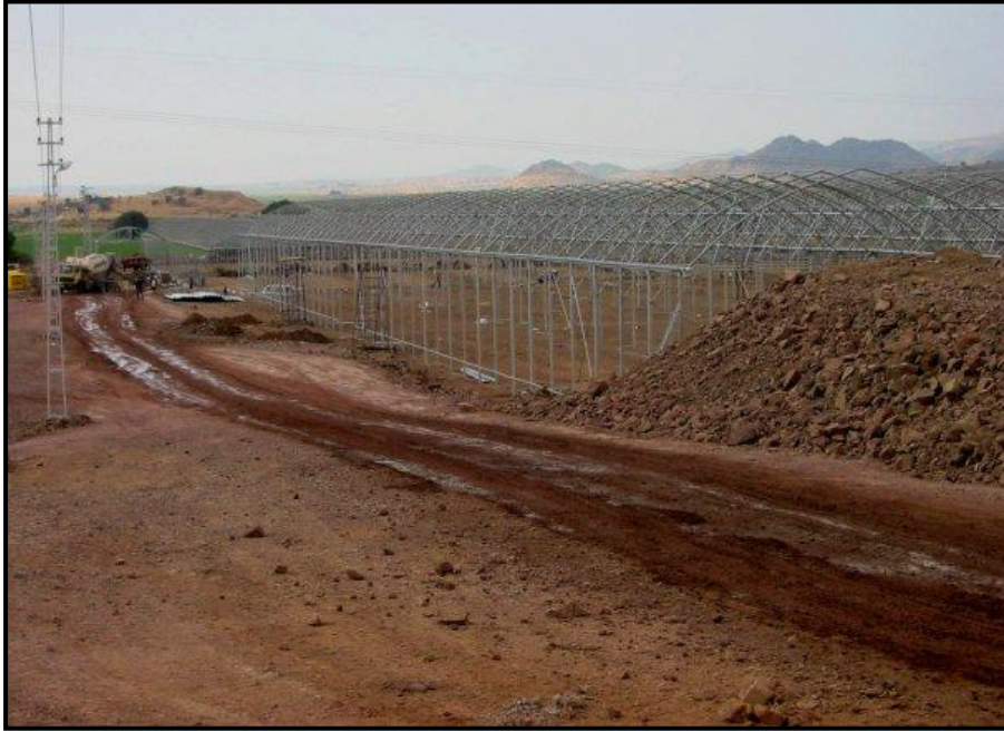
Fotoęraf 59: Özel Bir Firma Tarafından Kurulumu Yapılan Yay Çatılı Sera Tesisinden Bir Görünüm (Aydın)
