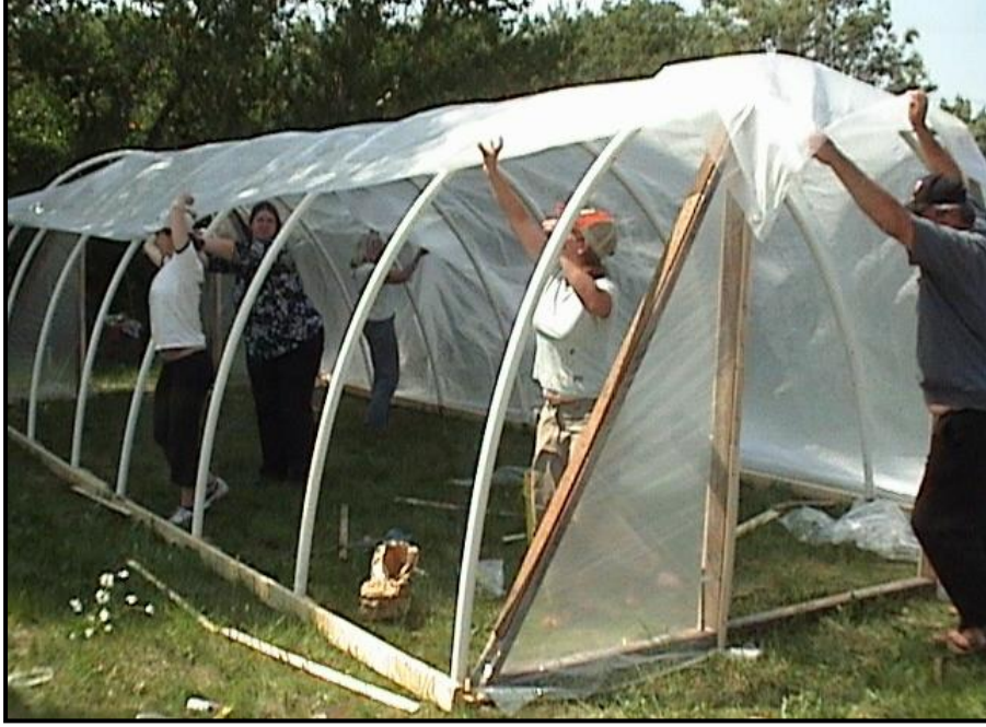
Fotoęraf 58: Üretici Tarafından Tesis Edilmekte Olan Bir Yüksek Plastik Tünel
