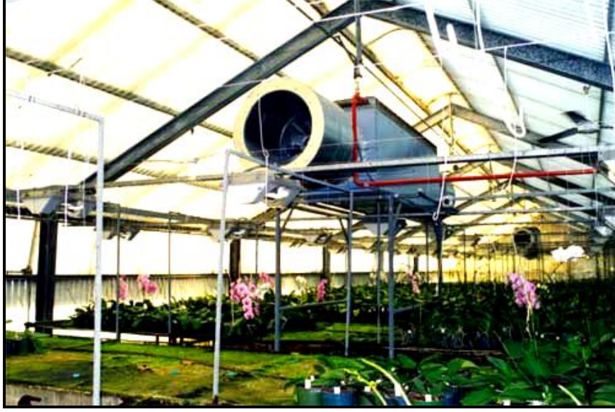
Fotoğraf 20: Örtüaltı Yetiştiricilik Sisteminde Fanlarla Yapılan Soğutma Sisteminden Bir Görünüş (Tayland)
