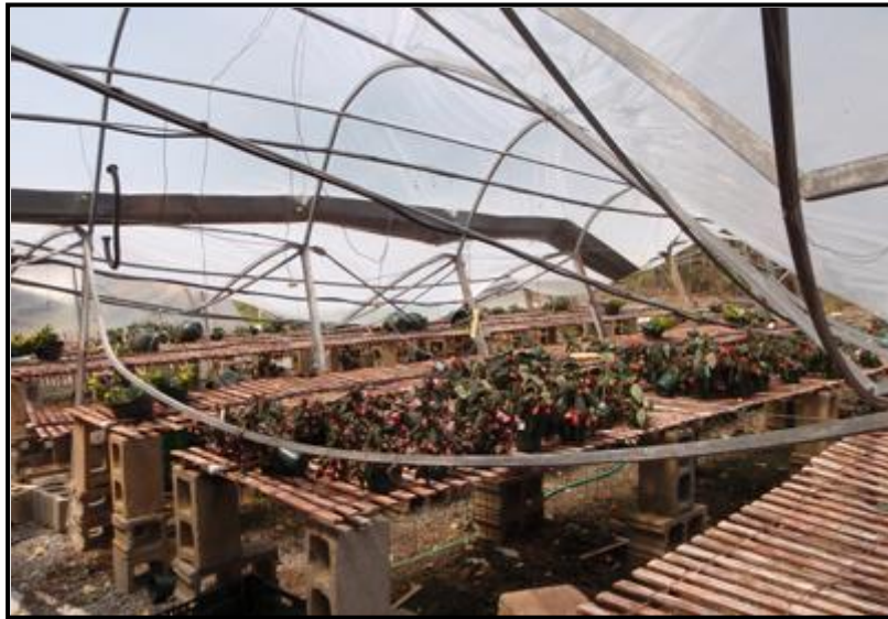
Fotoğraf 28: Şiddetli Rüzgarların Kullanılamaz Hale Getirdiği Bir Örtüaltı Üretim Yapısı (A.B.D.) 29
