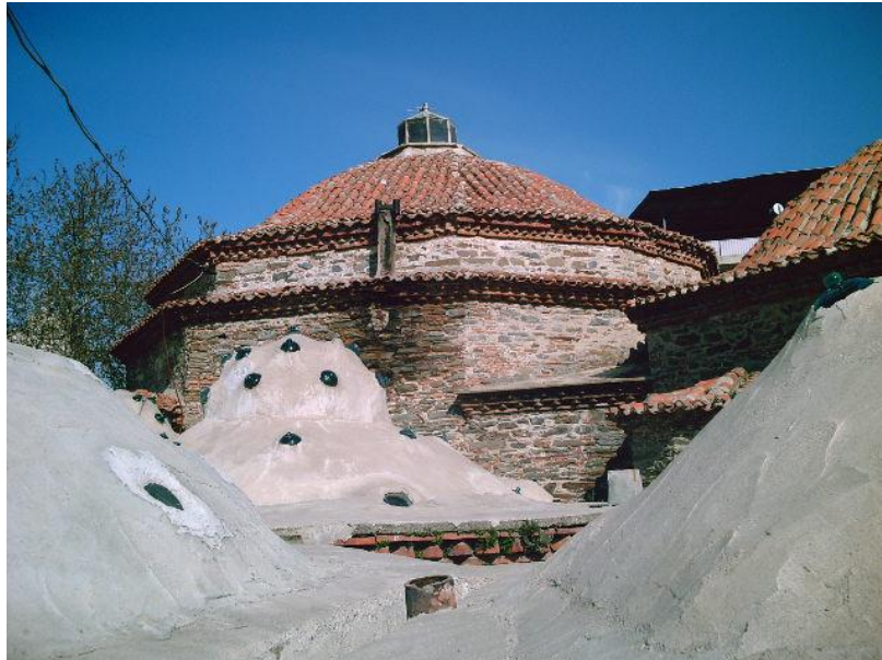
Figure 3.55. In Tire Eski-Yeni Hamamı soyunmalık dome, the use of lighting lantern.
