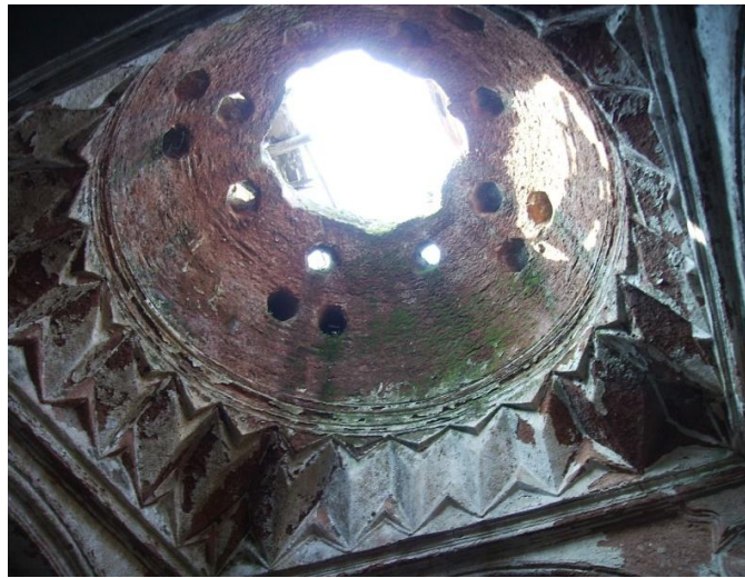
Figure 2.8. Tire Tahtakale Hamamı men's section sıcaklık main space dome in semi-circular profile.
