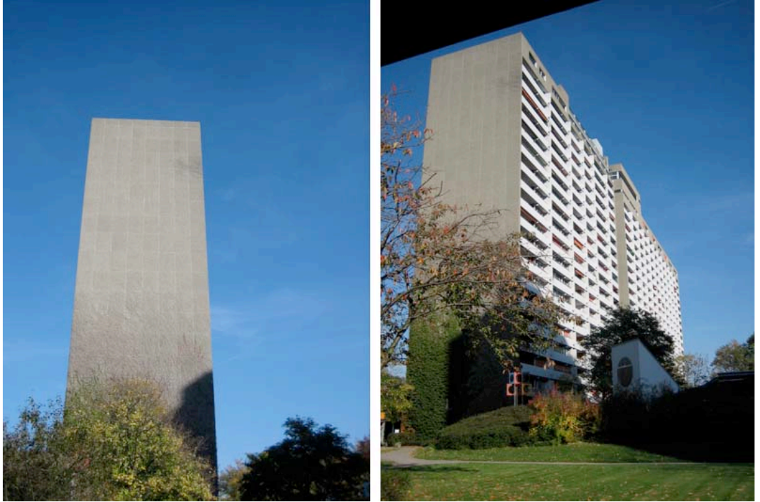
Şekil 4.11 : Yüksek katlı banliyöleşme yapısına bir örnek olarak Asemwald (Cem AYIK Arşivi 2008).
