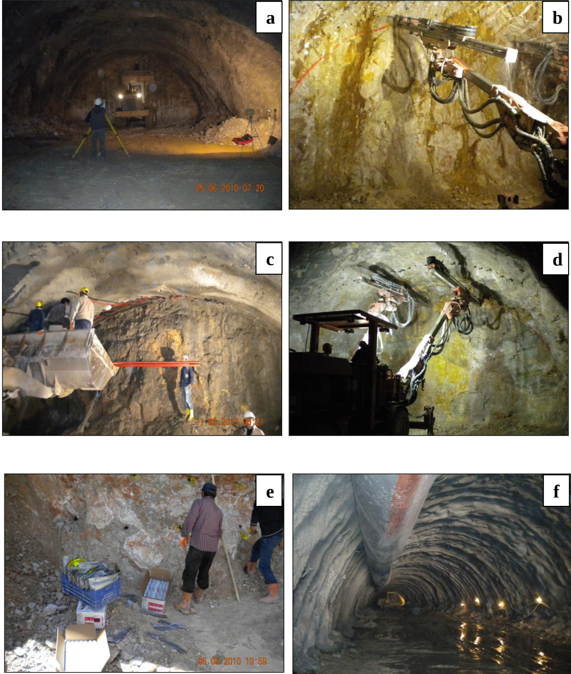
Fotoğraf 1.1 (a) Topografin delgi yüzeyini çizmesi (b) Jumbo ile süren delgisi (c) Süren montajı (d) Ayna patlayıcı delgisi (e) Patlayıcı doldurulması (f) Patlatma sonrası havalandırma işlemi
