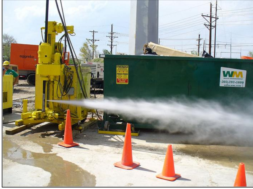
Fotoğraf 2.10 Püskürtme aşaması
