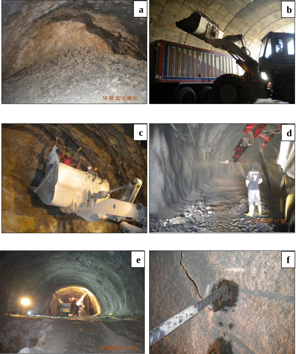
Fotoğraf 1.2 (a) Patlatma sonucu oluşan pasa (b)Pasa malzemesinin tünelden çıkarılması (c) Zemin sınıfına göre destekleme yapılması iksa- hasır montajı (d) Yaş shotcrete atılması (e) Jumbo ile kaya bulonu delgisi yapılması (f) Sn tipi bulon montaj ve enjeksiyonu
