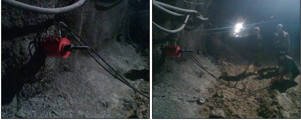
Fotoğraf 1.3 (a)Bulona çekme makinesinin yerleştirilmesi (b)Deneyin yapılması
