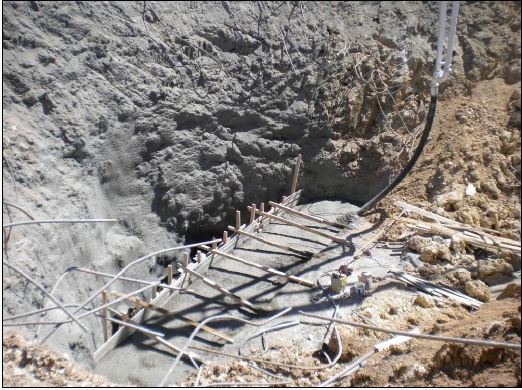
Fotoğraf 2.9 Göçük üstten iksaları betonla kapatarak geçilmesi
