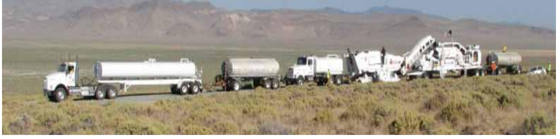
Şekil 5.6 Yerinde soğuk geri dönüşüm uygulaması [24]
