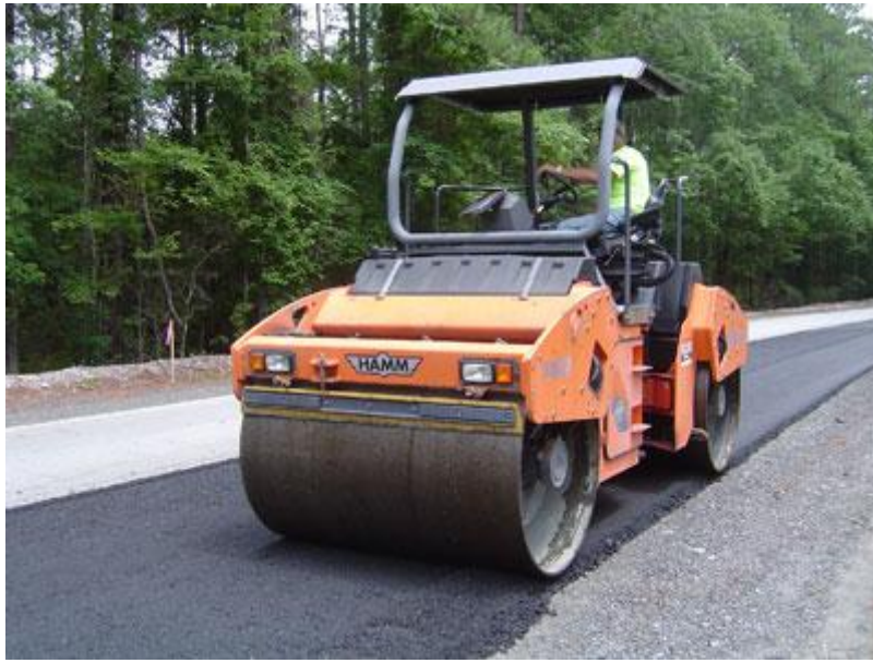
Şekil 5.8 Soğuk yerinde geri dönüşüm uygulamasında silindiraj
