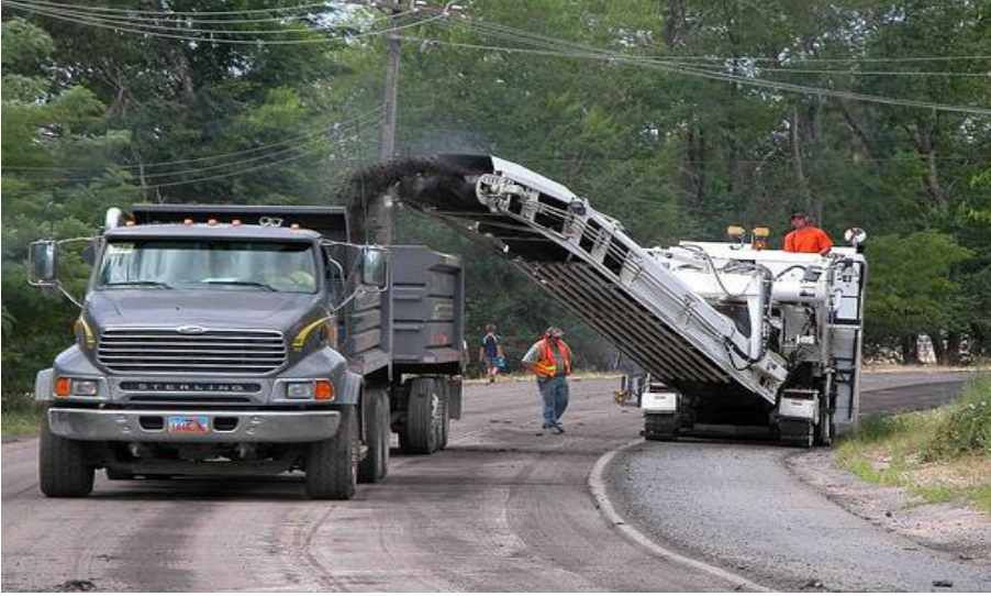
Şekil 5.3 Soğuk düzeltme ve kazınan malzemenin nakliyesi [17]
