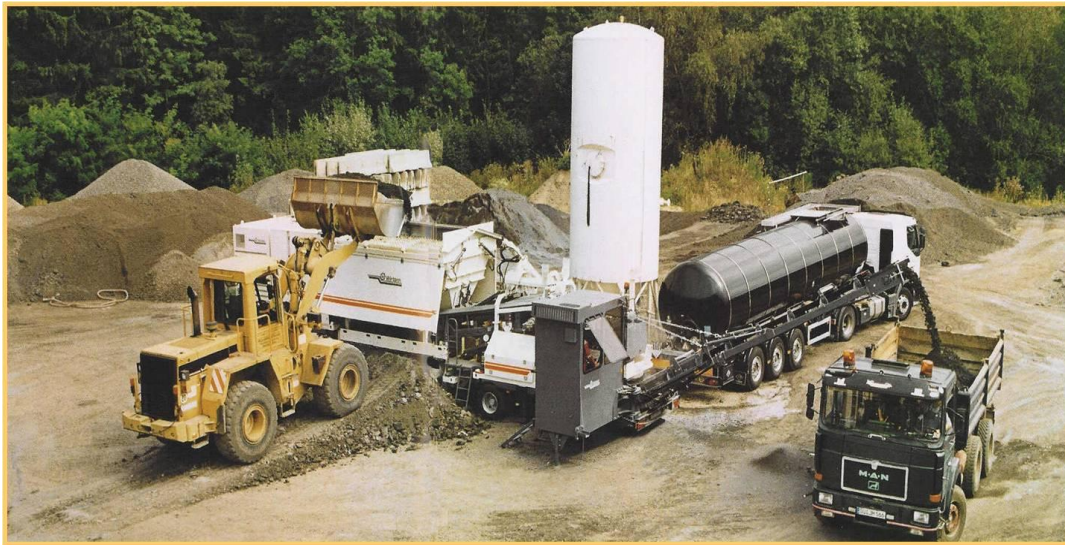
Şekil 5.10 Plentte soğuk karışım geri dönüşümü uygulaması [27]
