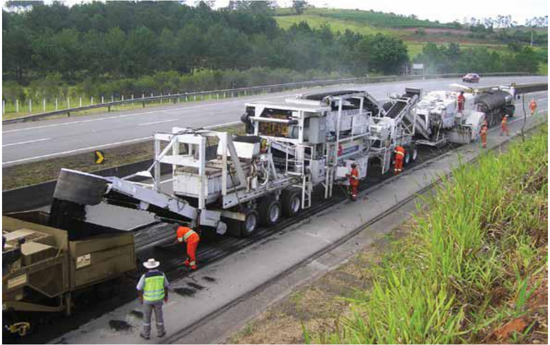
Şekil 5.7 Plentte soğuk geri dönüşüm uygulaması [24]
