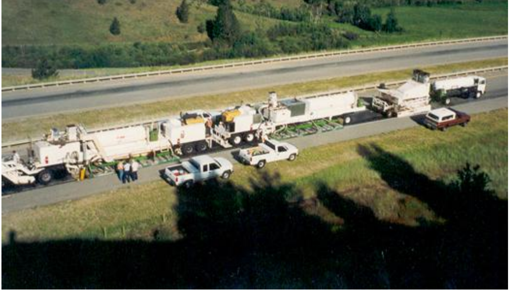
Şekil 5.4 Yerinde Sıcak Geri Dönüşüm işlemi
