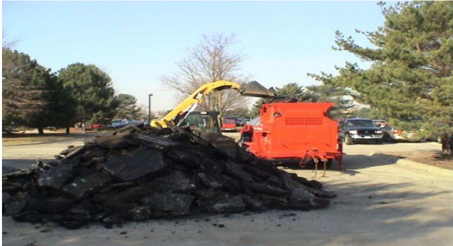
Şekil 4.1 Asfalt betonu kazıma ve sisteme yükleme [15]
