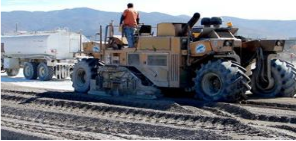
Şekil 5.13 Tam derinlikli geri dönüşüm uygulaması [27]
