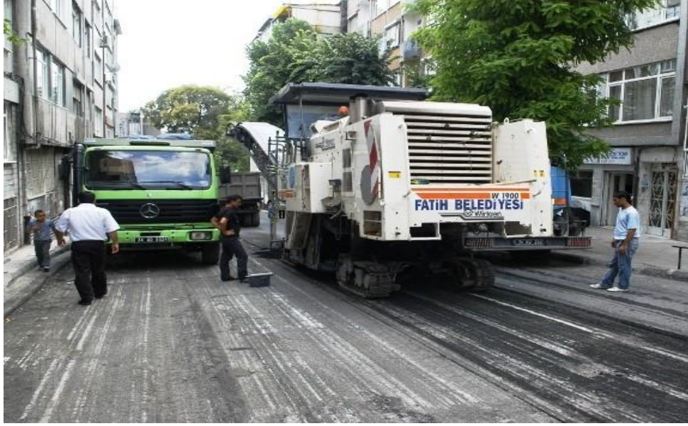
Şekil 5.2 Soğuk düzeltme işleminden geçmiş yol yüzeyi örnekleri [17]
