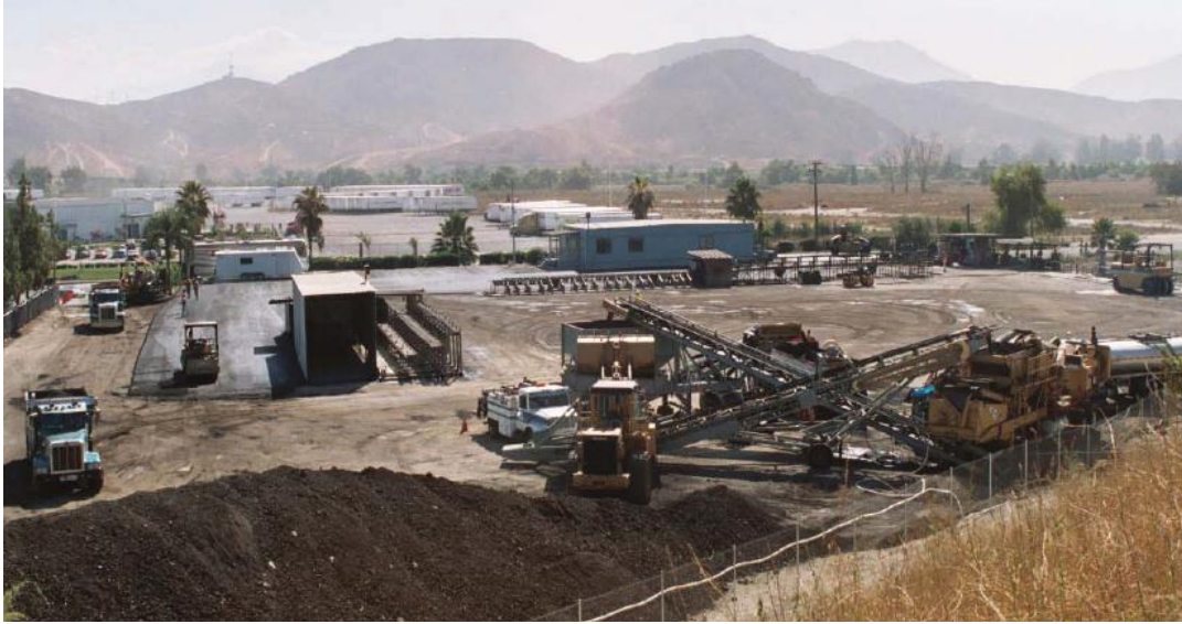
Şekil 5.9 Plentte soğuk karışım geri dönüşümü uygulaması [24]
