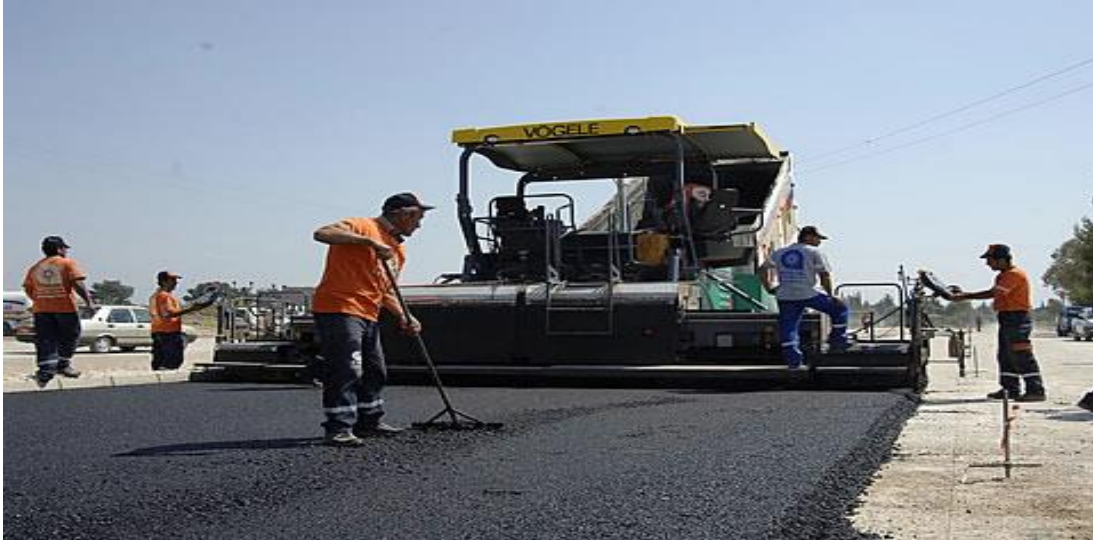
Şekil 3.2 Asfalt betonu uygulaması [9]
