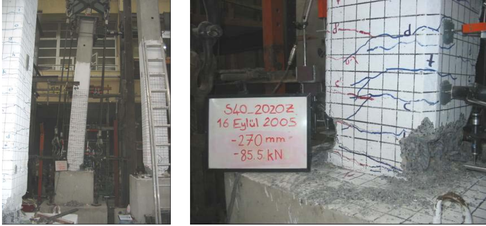
Şekil 4.64 : S40_2020Z numunesine ait hasar fotoğrafları.
