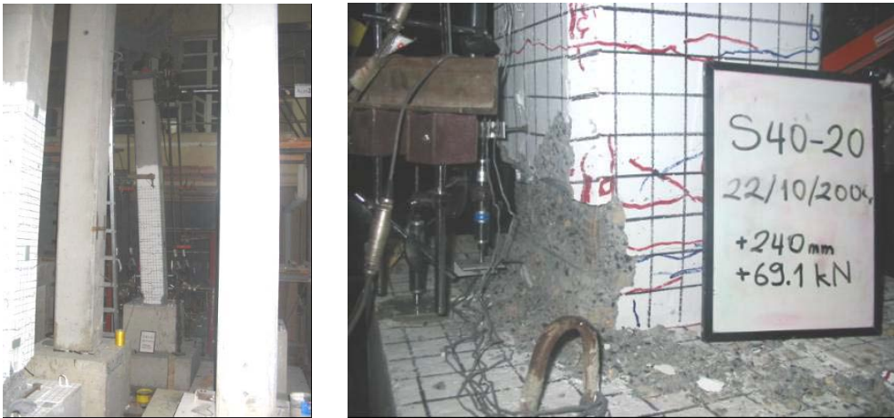
Şekil 4.54 : S40_20 numunesine ait hasar fotoğrafları.
