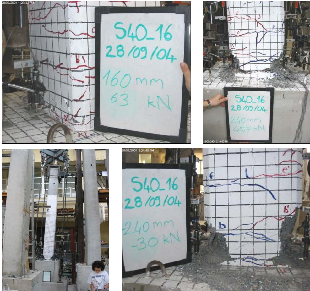
Şekil 4.50 : S40_16 numunesine ait hasar fotoğrafları.
