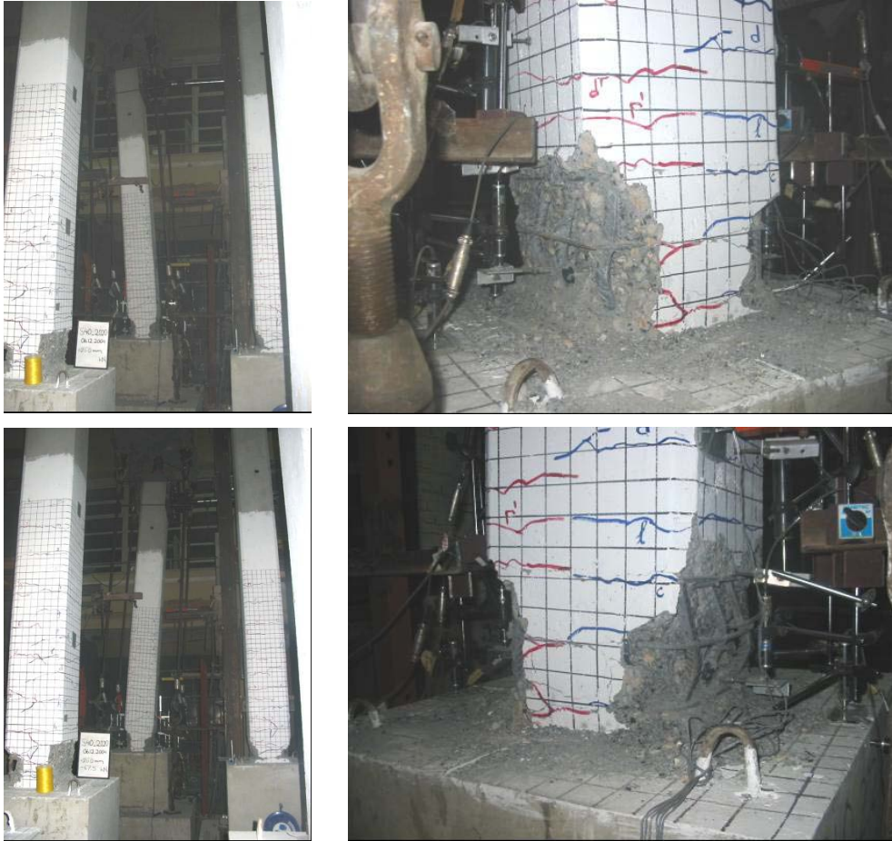
Şekil 4.59 : S40_2020 numunesine ait hasar fotoğrafları.
