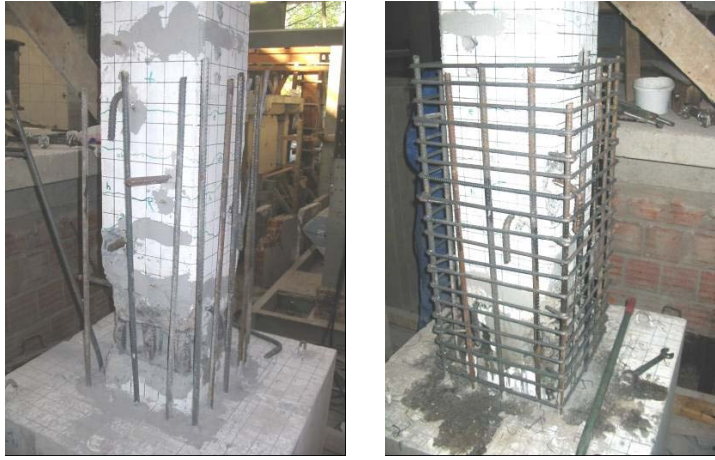
Şekil 4.72 : Kayma kamaları, boyuna ve enine donatıların yerleştirilmesi.
