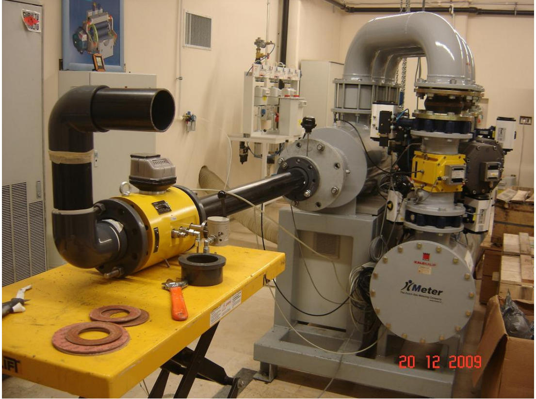
Şekil 7.23 : Sayaç girişine 1xD uzaklıkta 1 adet, sonrasında 24 cm uzaklıkta 1 adet 90° açılı dirsekli uygulaması
