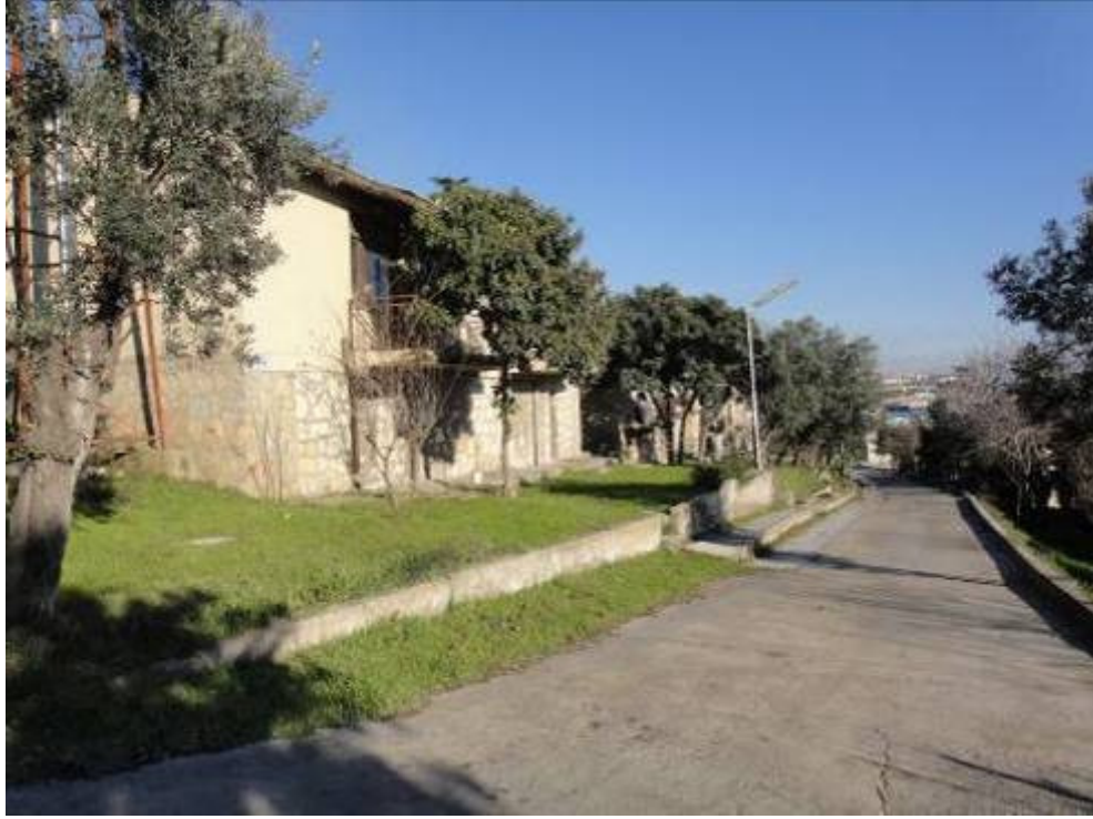
Resim 6.6 : Aslan Çimento Fabrikasına ait kullanılmayan lojman binaları ve çevresi (2010).
