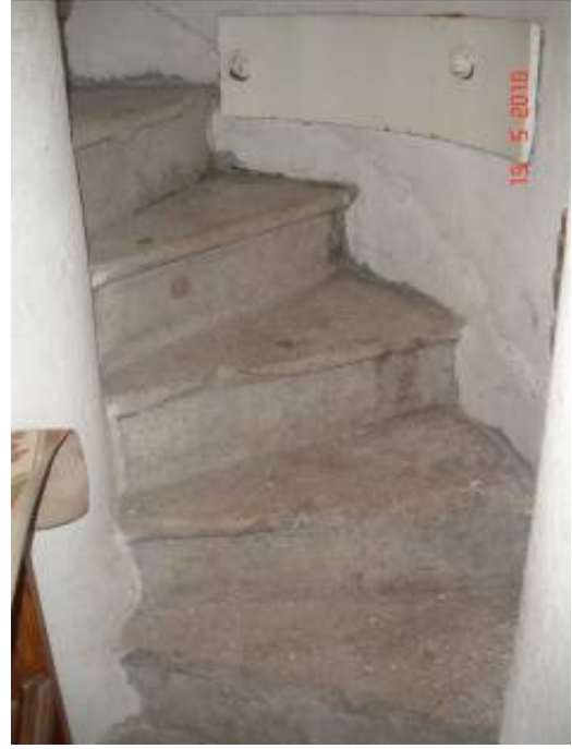
Resim 4.28 : Fener kulesinin merdiven basamakları (2010).
