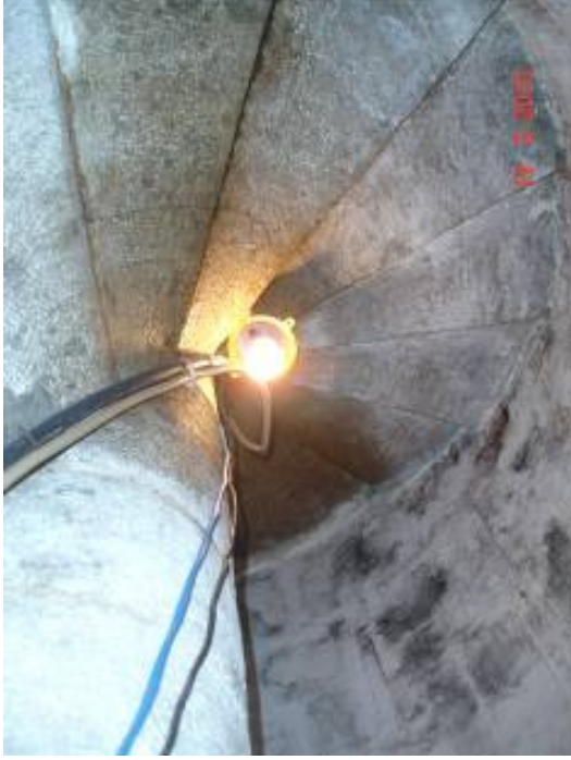
Resim 4.27 : Fener kulesinin merdivenlerinin zemin kotundan görünüşü (2010).
