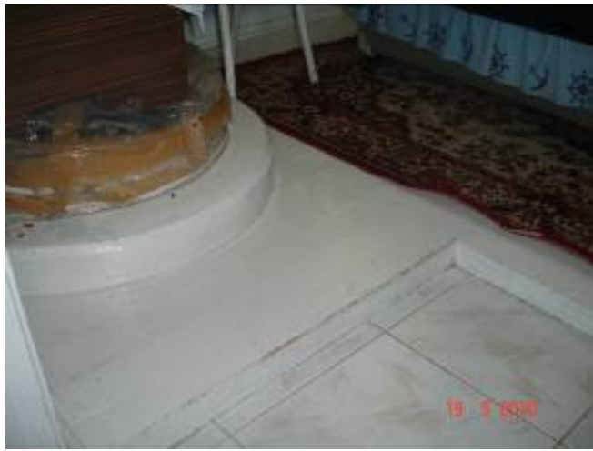
Resim 4.17 : Z06 no'lu mekanında yer alan üzeri kapatılmış su kuyusu (2010).
