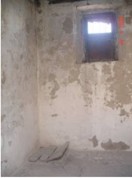
Resim 4.50 : Dilburnu'nun D02 no'lu yakıt deposu (2010).
