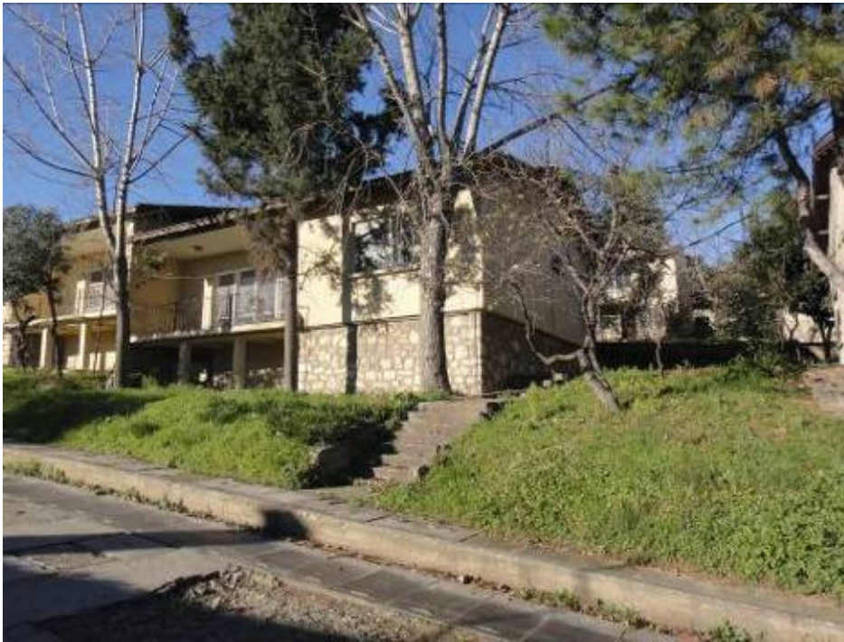
Resim 6.5 : Aslan Çimento Fabrikasına ait kullanılmayan lojman binaları (2010).
