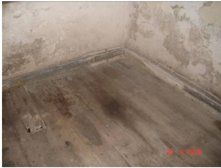
Resim 4.65 : D05 no'lu mekanın zemin döşemesi (2010).
