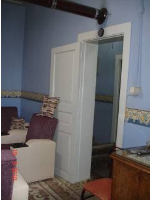
Resim 4.14 : Z05 mekanının kapısı (2010).
