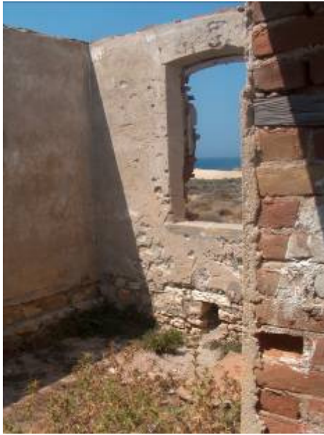
Resim 3.14 : Polente Feneri'nin tuğla duvarları (KEGM Arşivi).
