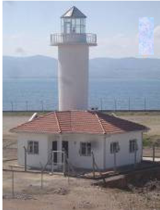
Resim 4.37 : 2008 yılında yeniden inşa edilen fener ve bakıcı evi (2010).
