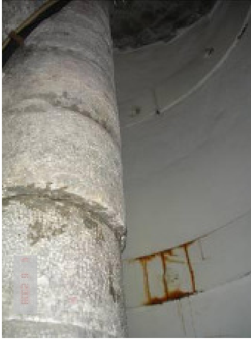
Resim 4.21: Fener kulesinin orta aksındaki taşıyıcı (2010).
