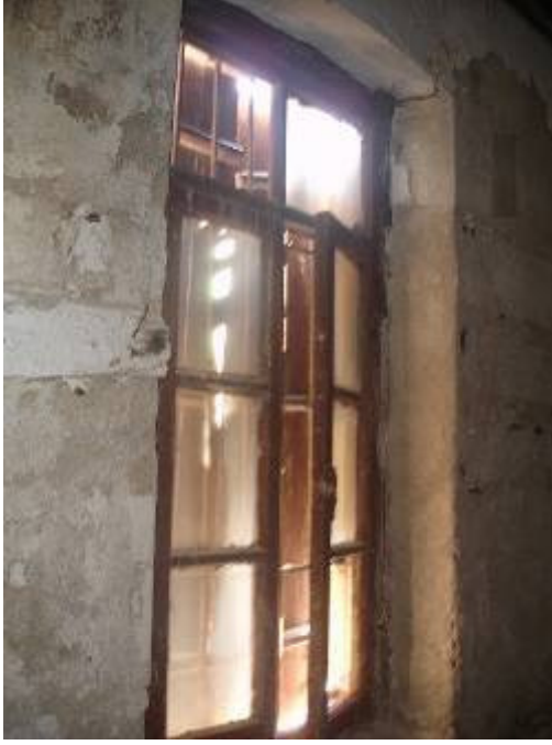
Resim 4.54 : D05 no'lu mekanın kuzeye açılan penceresi (2010).
