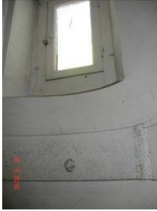
Resim 4.29 : Fener kulesinin iç bölümündeki güçlendirme elemanları (2010).
