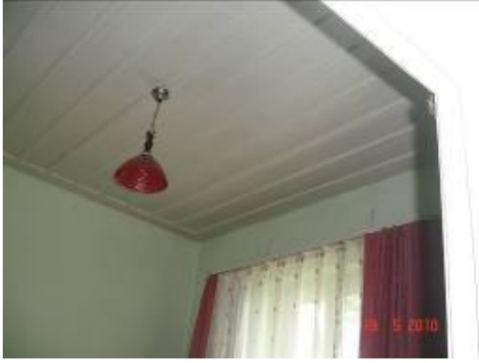
Resim 4.18 : Z07 no'lu mekanın tavan kaplaması (2010).
