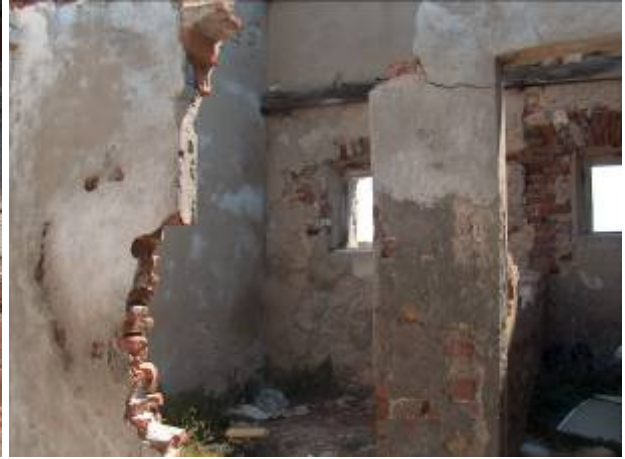
Resim 3.15 : Polente Feneri'nin tuğla duvarları ve ahşap lentoları (KEGM Arşivi).
