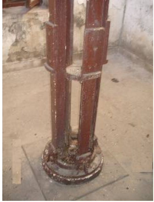
Resim 4.59 : D08 no'lu odada bulunan eski metal direk fener kulesi (2010).
