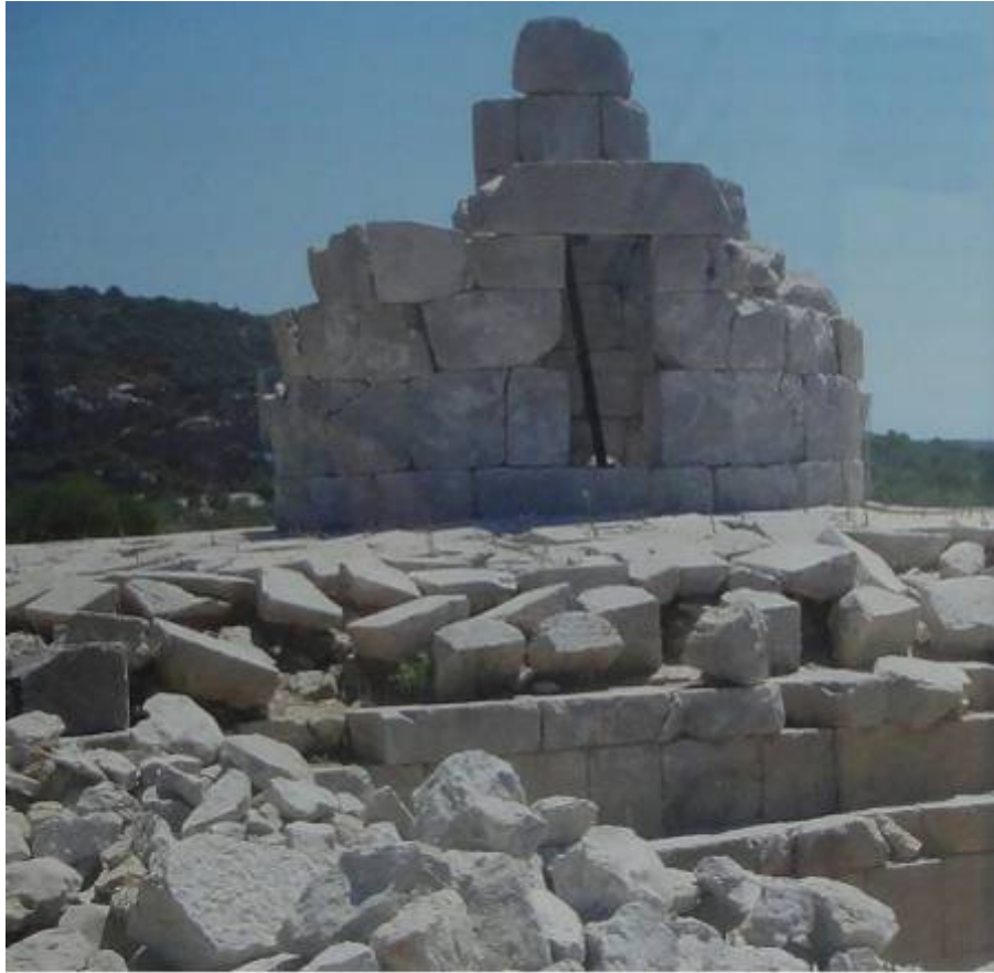
Resim 3.3 : Antalya'daki Patara feneri kalıntıları (Sönmez, 2010).
