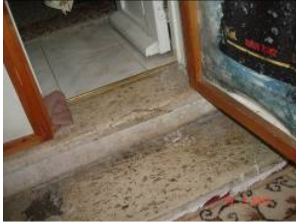
Resim 4.10 : Z01 no'lu mekandan Z04 no'lu mekana çıkan taş basamaklar (2010).
