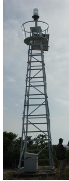
Resim 3.22 : Bayrakadası'nın çatma metal sehpa fener kulesi ( http://www.kiyiemniyeti.gov.tr/default.asp?id=7&sid=28&srt=&recNo=75&lng , Ocak 2011)
