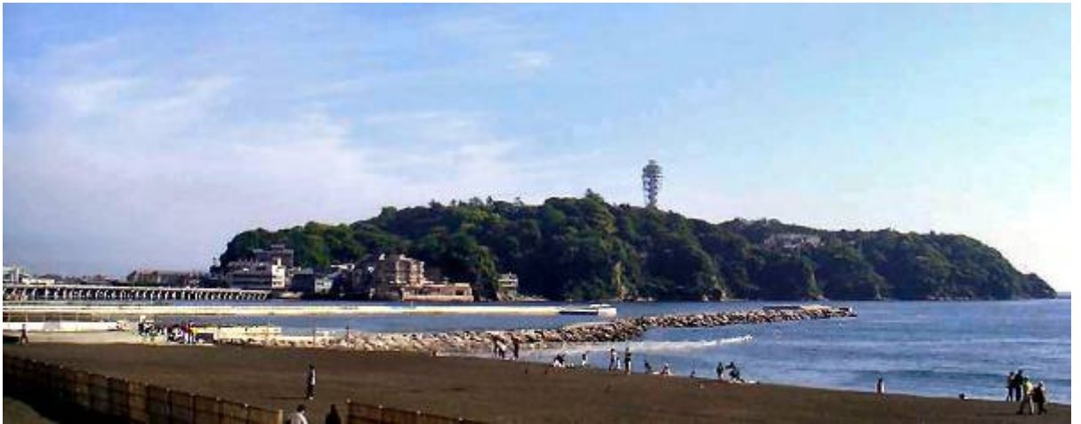
Resim 5.39 : Enoshima Lighthouse' un adadaki görünümü ( http://en.wikipedia.org/wiki/Enoshima , Ocak 2011)
