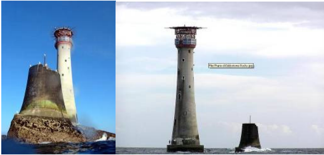
Resim 2.13 : 1759'da Smeaton'ın Eddystone fenerinin kalıntısı ve Douglas'ın 1882'de inşa edilen beşinci tasarımı ( http://gigrower.co.uk/wp-content/uploads/EddystoneStump.jpg , Ocak 2011).
