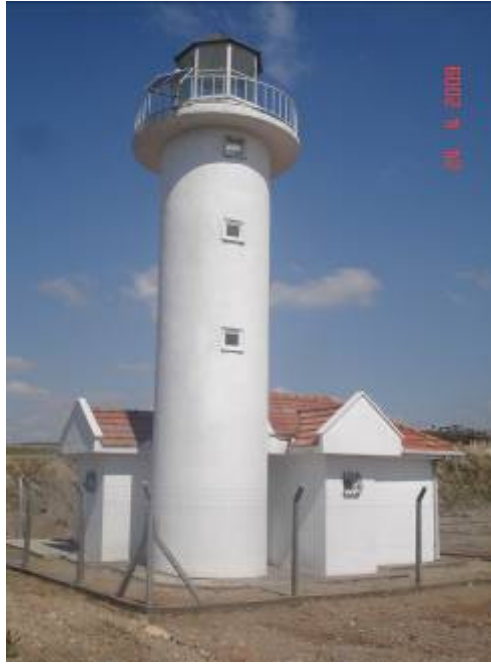
Resim 3.25 : Betonarme yapım tekniğinde inşa edilen Kavaburnu Feneri, (2010).
