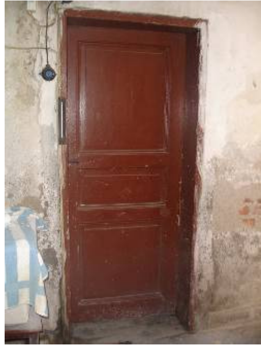
Resim 4.55 : D07 no'lu mekanın kapısı (2010).
