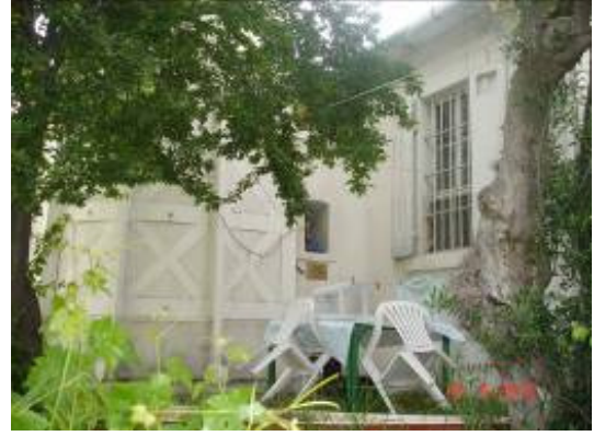
Resim 4.19 : Z07 no'lu mekanın güneydoğu cephesinden görünümü (2010).
