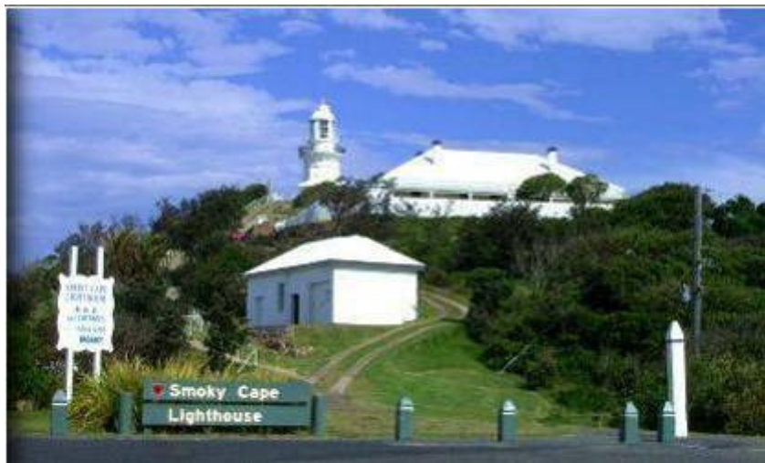
Resim 5.30 : Smoky Cape Lighthouse' un girişi ( http://www.smokycapelighthouse.com/ , Ocak 2011)
