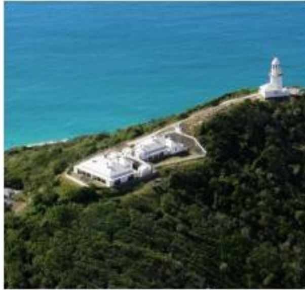
Resim 5.29 : Smoky Cape Lighthouse' un kuşbakışı görünümü ( http://www.smokycapelighthouse.com/ , Ocak 2011)
