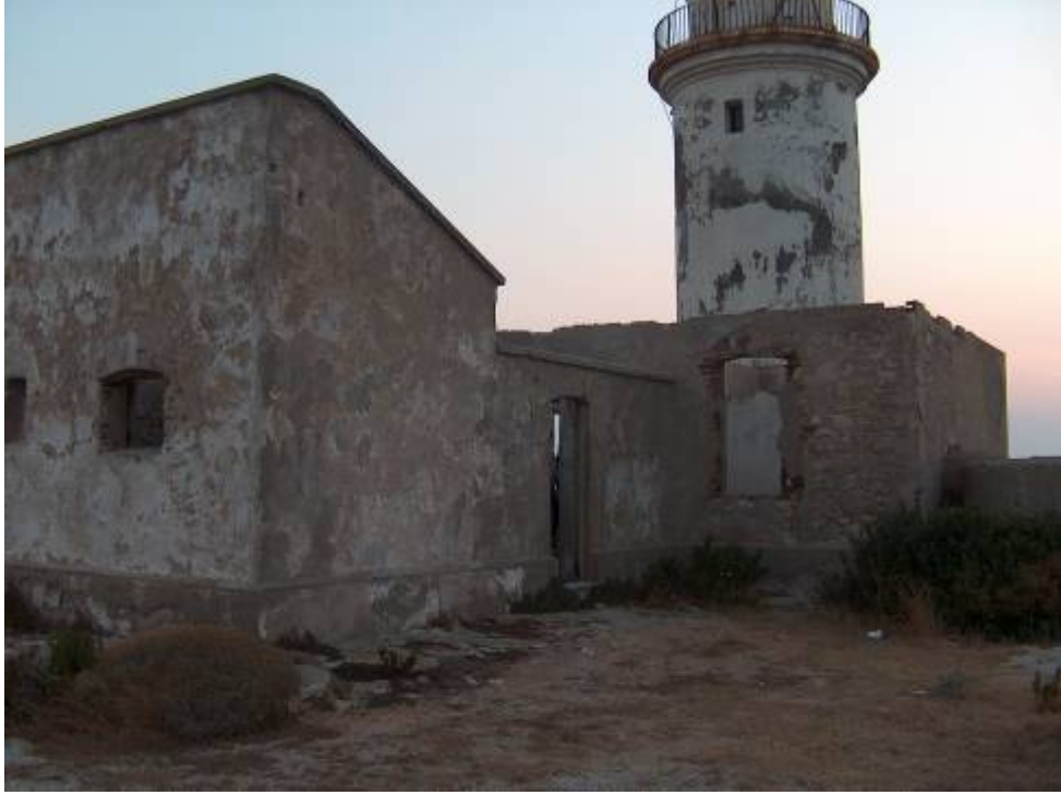
Resim 3.16 : Polente Feneri’nde taş malzemenin subasmanda uygulandığı (KEGM Arşivi).
