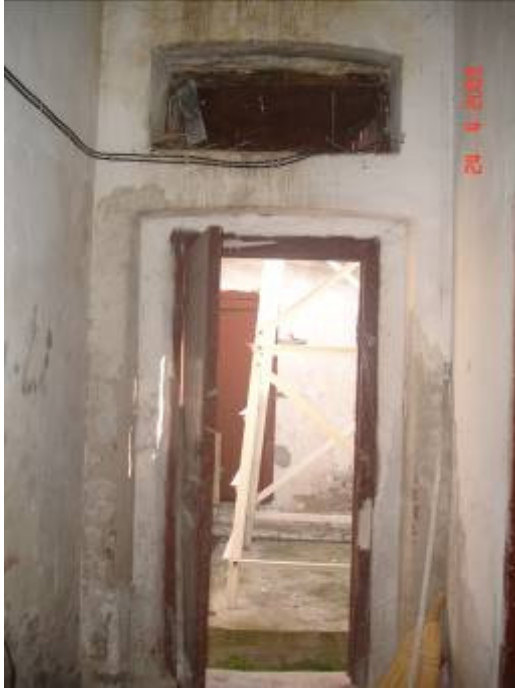
Resim 4.52 : D04 no'lu koridordan güney yönündeki giriş avlusuna açılan kapı (2010).
