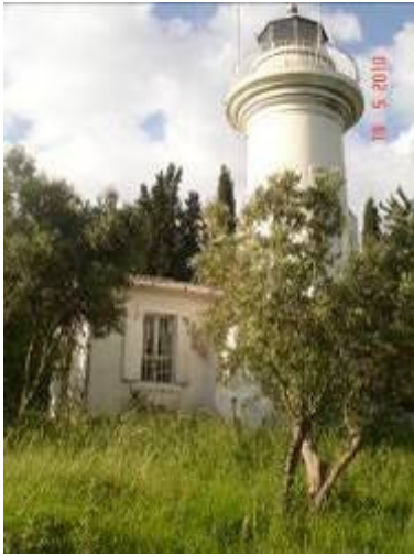
Resim 4.16 : Z05 no'lu mekanın güneybatı cephesinden görünümü (2010).
