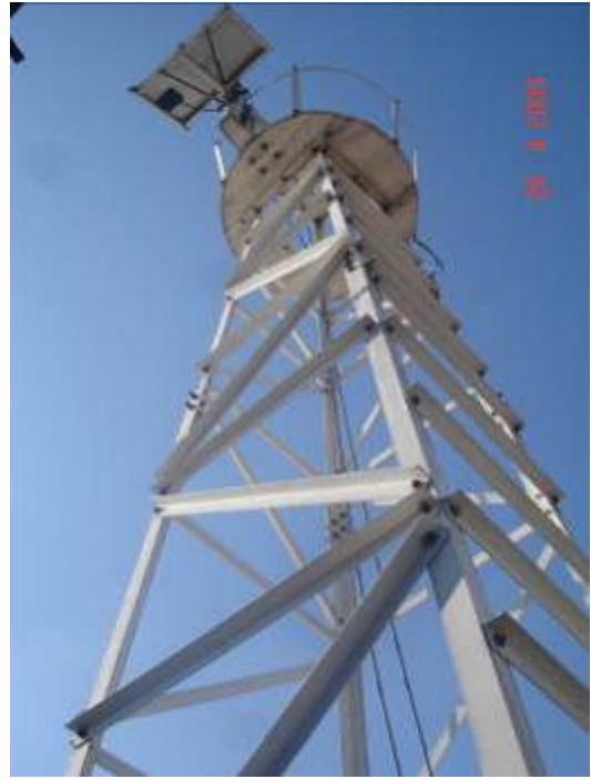
Resim 4.64 : Dilburnu Feneri'ne ait yeni çatma sehpa metal fener kulesi (2010).
