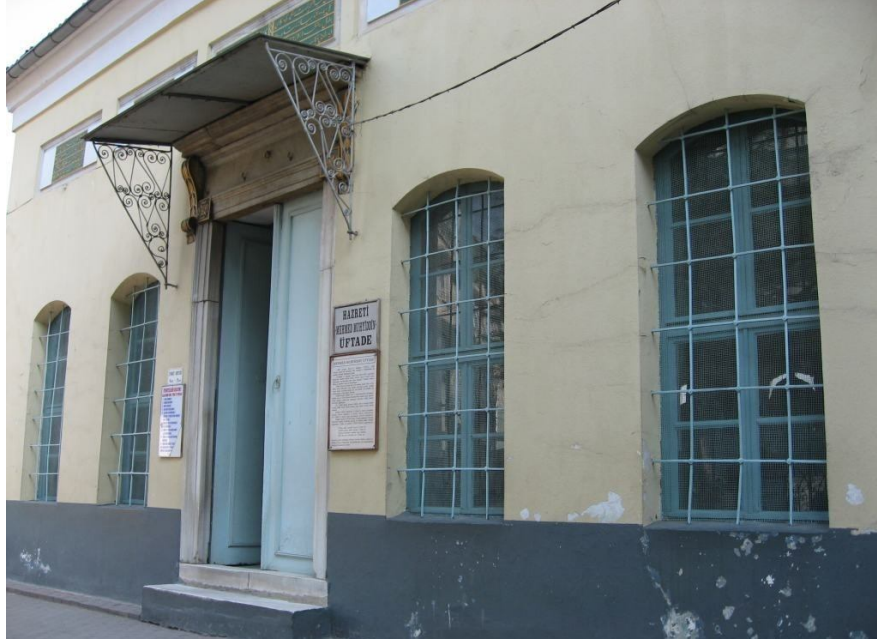
Resim 74: Restorasyon Öncesi Giriş Cephesi ( http://wowturkey.com/forum/viewtopic.php?t=28223&start=5&sid=c49da9305f0e0ac5b7c715319657a9d0 )
