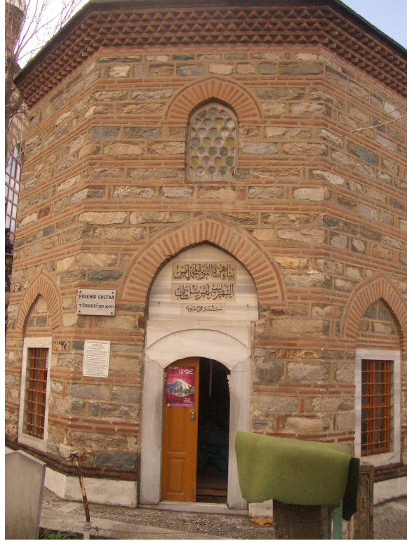
Resim 65: Pir Emir Türbesi Genel Görünüm
