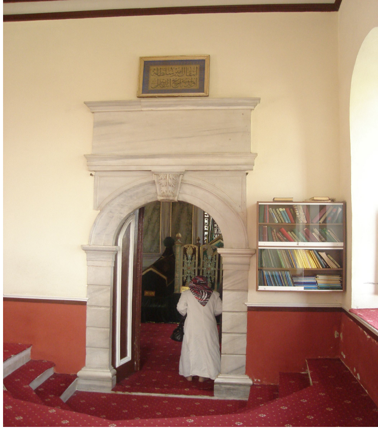
Resim 143: Doğu Cephedeki Giriş
