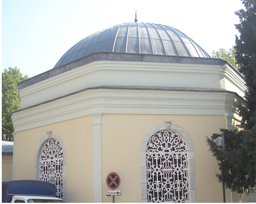
Resim 119: Silmeler, Plastırlar ve Kubbe
