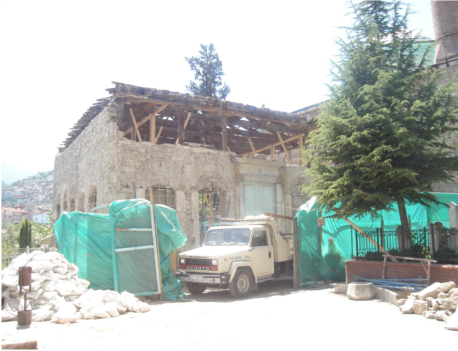
Resim 71: Üftade Türbesi Restorasyon
