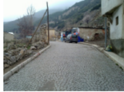
Resim 4.252. Değirmen sok. 77 nolu vista
