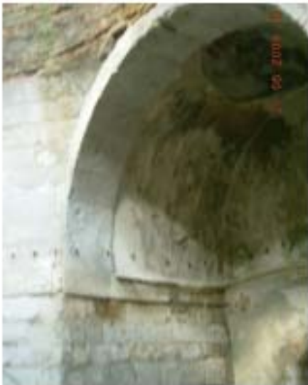
Resim 3.58. Erkekler bölümü sıcaklığı açıktan giden elektrik tesisat izi- 2009 E.İ.İ
