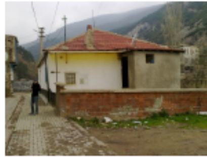
Resim 4.389. Boğaz sok. 214 nolu vista
