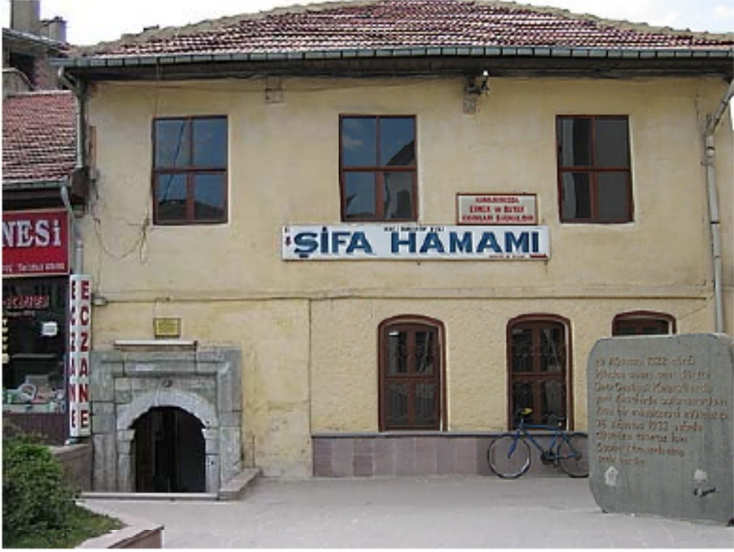
Resim 6.1. Meydan (Şifa) Hamamı güney cephesi
