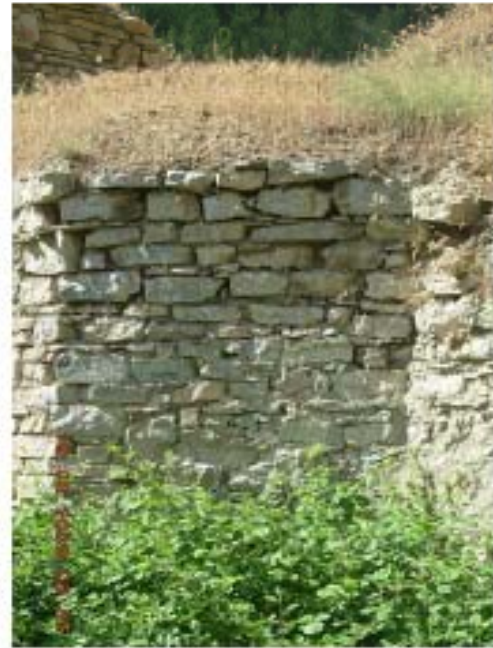
Resim 4.2. Yapıda kullanılan moloz taş 2009 - E.İ.İ
