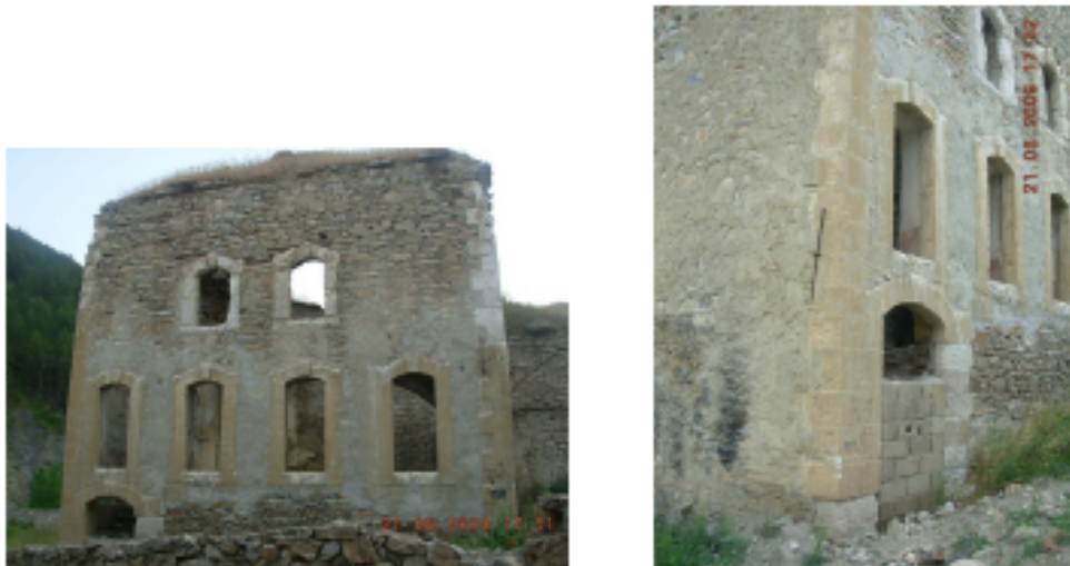
Resim 4.23. Yukarı Hamam doğu cephesi Resim 4.24. Yukarı Hamam doğu cephesi
