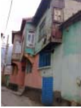
Resim 4.377. Boğaz sok. 202 nolu vista
