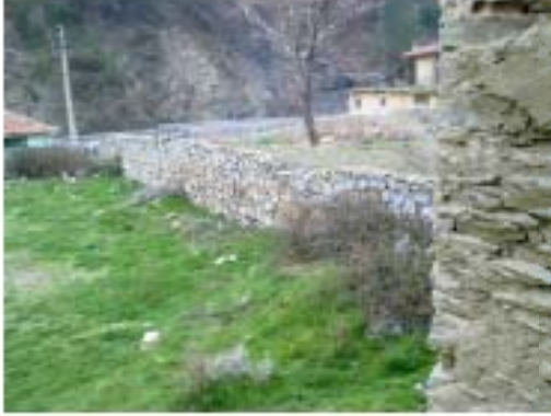
Resim 4.25. Yukarı Hamam güney cephe istinat duvarı
