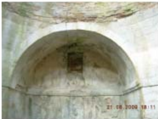
Resim 4.79. Erkek sıcaklık 53 nolu vista
