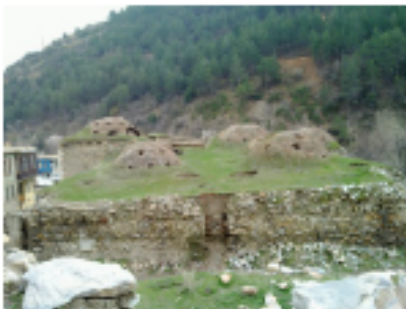
Resim 4.257. Değirmen sok. 82 nolu vista
