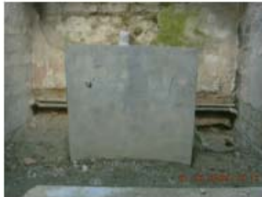
Resim 7.8. Beton bölme duvar-2009 E.İ.İ
