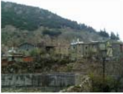
Resim 4.386. Boğaz sok. 211 nolu vista
