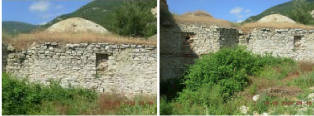
Resim 4.19. Yukarı Hamam doğu cephesi Resim 4.20. Yukarı Hamam doğu cephesi
