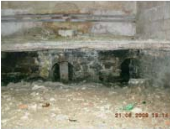
Resim 3.89. Kadmlar bölümü sıcaklığı cehennemlik kanalları - 2009 E.İ.İ
