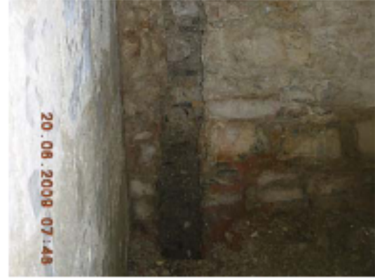
Resim 7.11. Halvet içi buhar kanalı
