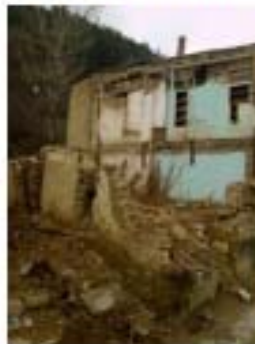
Resim 4.393. Boğaz sok. 218 nolu vista
