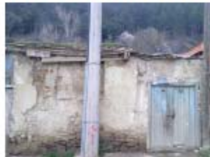
Resim 4.368. Boğaz sok. 193 nolu vista
