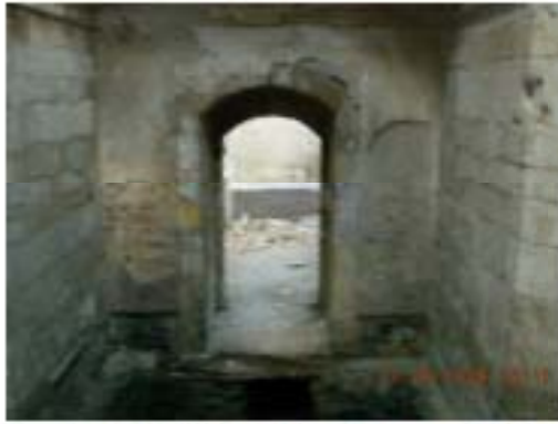
Resim 3.51. Erkekler bölümü sıcaklık KP7 kapısı - 2009 E.İ.İ
