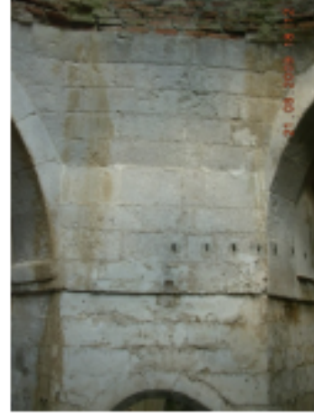
Resim 4.82. Erkek sıcaklık 56 nolu vista
