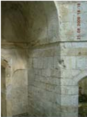
Resim 4.71. Erkek sıcaklık 45 nolu vista
