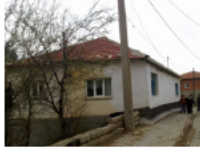
Resim 4.395. Boğaz sok. 220 nolu vista
