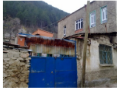
Resim 4.372. Boğaz sok. 197 nolu vista
