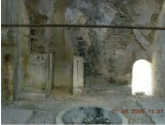
Resim 3.70. Kadınlar bölümü soyunmalığı D6 duvarı - 2009 E.İ.İ
