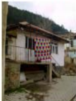
Resim 4.392. Boğaz sok. 217 nolu vista
