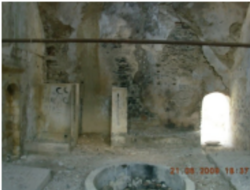
Resim 7.12. Kaldırılan bölme duvarlar
