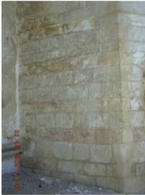
Resim 4.1. Yapıda kullanılan kesme taş 2009 - E.İ.İ
