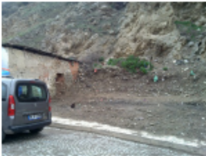
Resim 4.255. Değirmen sok. 80 nolu vista
