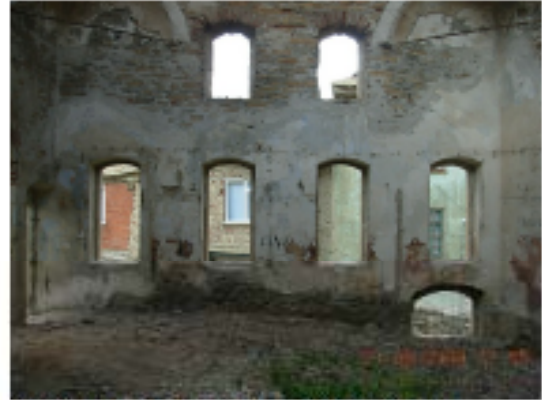
Resim 3.31. Erkekler bölümü soy. D4 duvarı -2009 E.İ.İ
