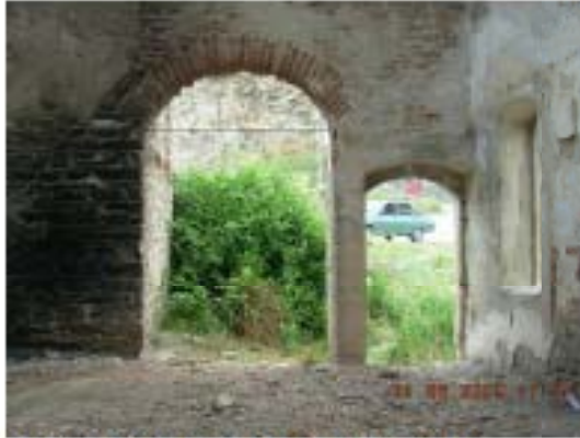
Resim 3.30. Erkekler bölümü soy. KP1 ve KP2 kapısı - 2009 E.İ.İ
