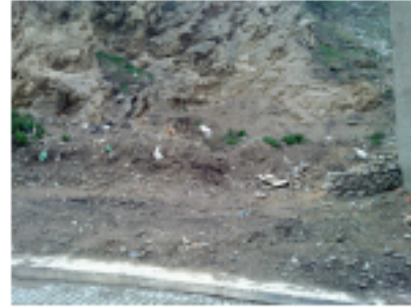
Resim 4.254. Değirmen sok. 79 nolu vista
