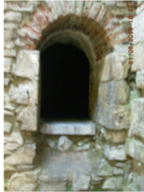
Resim 3.60. Su deposuna açılan pencere buhar çıkışı - 2009 E.İ.İ
