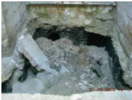
Resim 3.53. Erkekler bölümü sıcaklık eyvan-3 döşemesi - 2009 E.İ.İ
