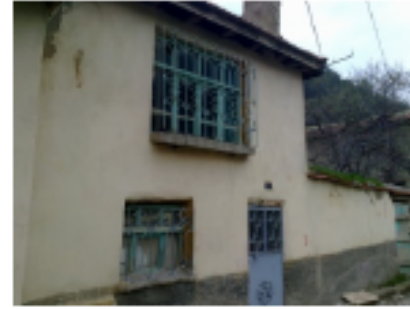
Resim 4.383. Boğaz sok. 208 nolu vista
