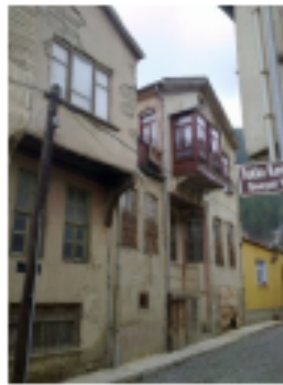
Resim 4.344. Köprü sok. 169 nolu vista
