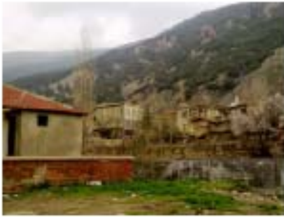
Resim 4.388. Boğaz sok. 213 nolu vista
