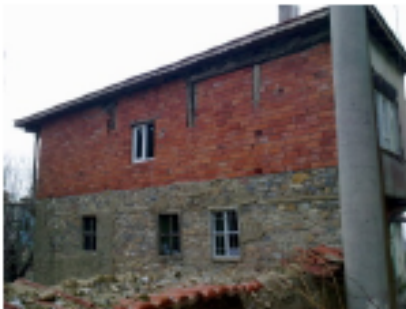
Resim 4.384. Boğaz sok. 209 nolu vista
