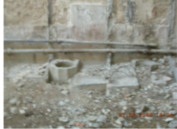
Resim 3.44. Erkekler bölümü ılıklik kurna ve su boruları - 2009 E.İ.İ
