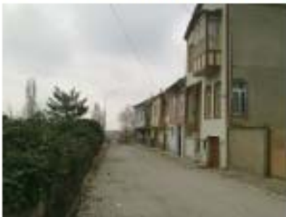
Resim 4.367. Boğaz sok. 192 nolu vista
