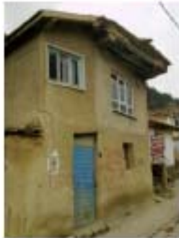
Resim 4.390. Boğaz sok. 215 nolu vista
