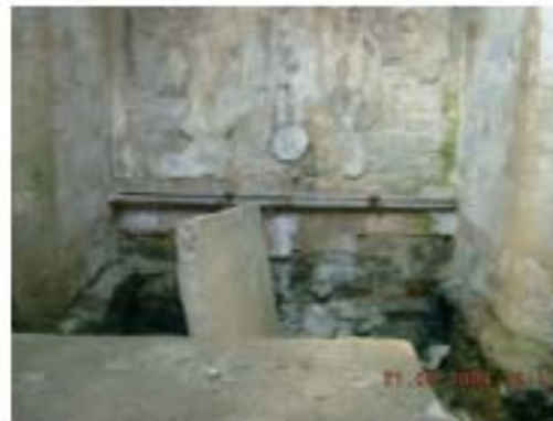
Resim 4.80. Erkek sıcaklık 54 nolu vista
