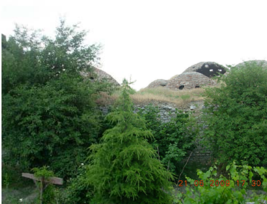
Resim 3.4. Yukan (Gavur) Hamamı batı cephesi görünüşü - 2009 E.İ.İ
