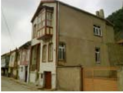
Resim 4.369. Boğaz sok. 194 nolu vista
