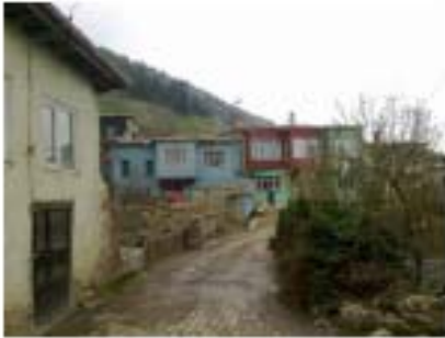
Resim 4.371. Boğaz sok. 196 nolu vista
