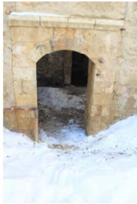
Resim 3.37. Erkekler bölümü soy. KP6 kapısı - 2011 E.İ.İ
