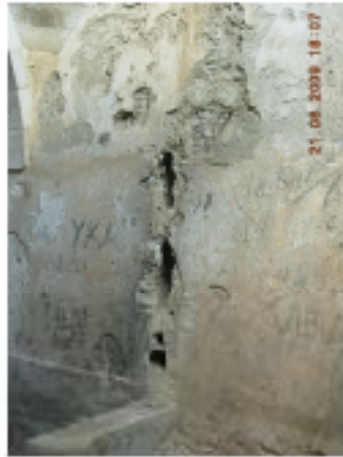
Resim 3.41. Erkekler bölümü ılıklik duman kanalı - 2009 E.İ.
