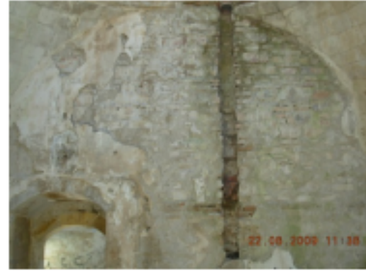
Resim 3.77. Kadımlar bölümü ılıkhğı duman kanalı - 2009 E.İ.İ
