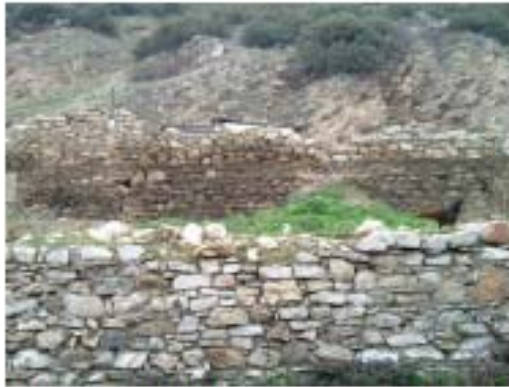
Resim 7.26. Külhan duvar izi- 2011 E.İ.İ
