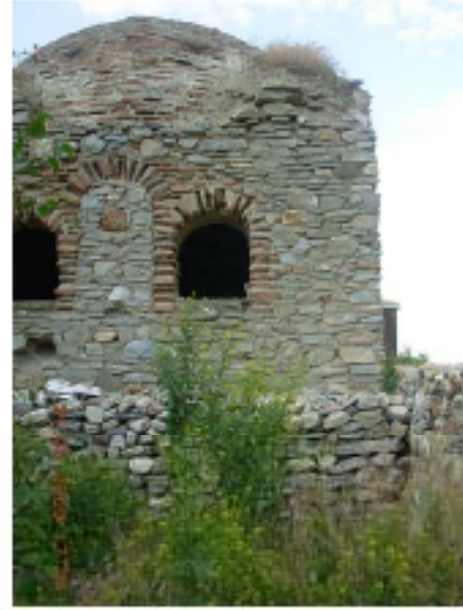
Resim 3.26. Batı cephesi tonoz başlangıcı 2009 - E.İ.İ
