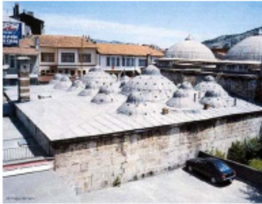
Resim 6.20. Hamam kubbe görünüşü
