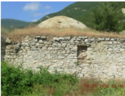
Resim 3.17. Kuzey cephesi P3 penceresi -2009 E.İ.İ
