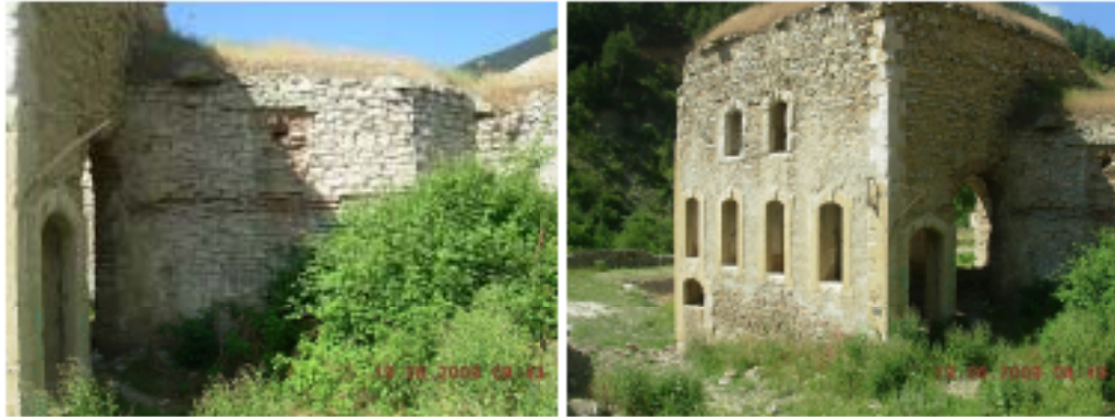
Resim 4.21. Yukarı Hamam doğu cephesi Resim 4.22. Yukarı Hamam doğu cephesi
