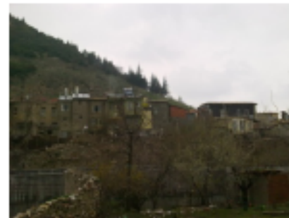
Resim 4.385. Boğaz sok. 210 nolu vista
