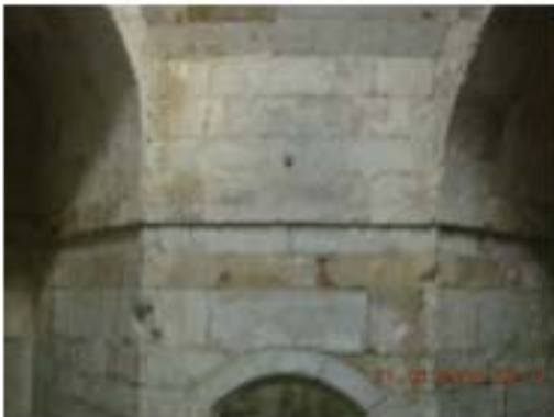
Resim 4.73. Erkek sıcaklık 47 nolu vista
