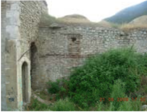
Resim 3.15. Doğu cephesi P2 penceresi -2009 E.İ.İ
