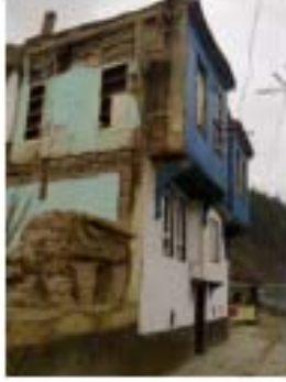
Resim 4.394. Boğaz sok. 219 nolu vista
