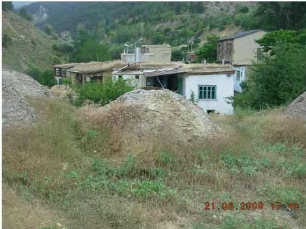
Resim 3.5. Yukan (Gavur) Hamamı su deposu üst çatı örtüsü görünüşü - 2009 E.İ.İ
