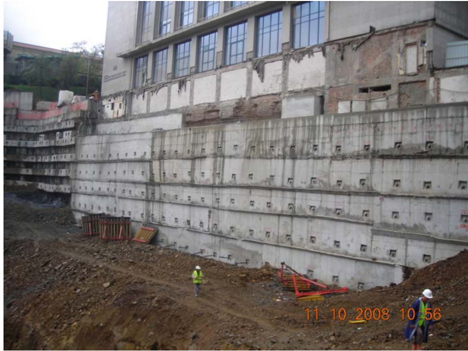
Şekil 6.8 : Lütfi Kırdar binası altındaki iksa sistemi
