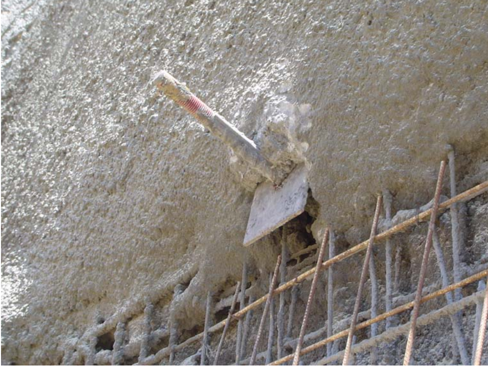
Şekil 5.33 : Hatalı bir zemin çivisi imalatı
