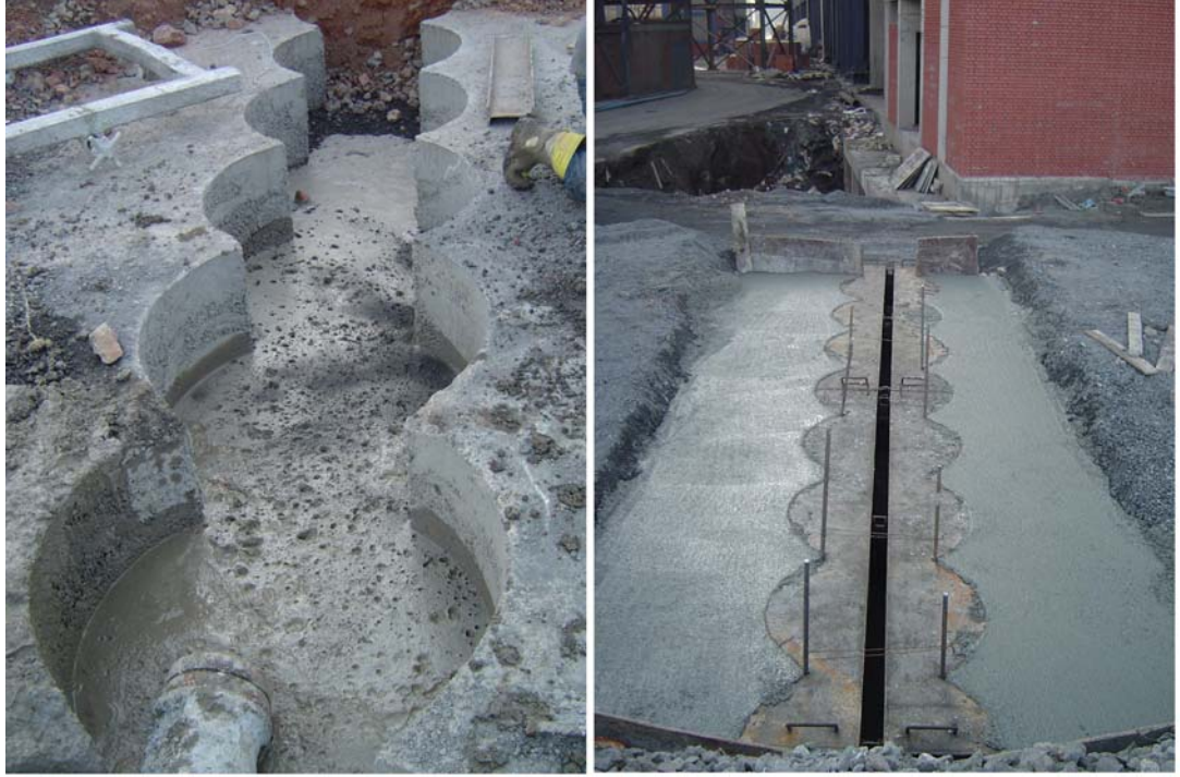
Şekil 5.10 : Kesişen fore kazık imalatı için kılavuz kalıp
