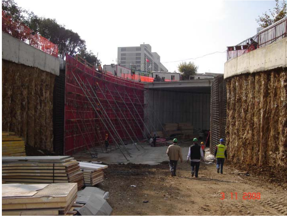
Şekil 6.25 : Tünel perdeleri ve özel kalıplar
