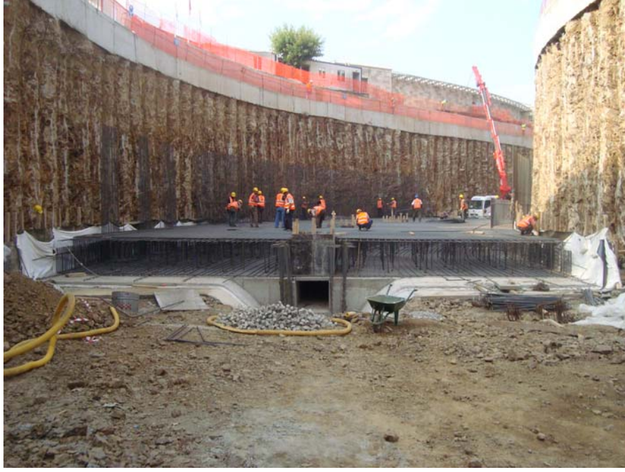
Şekil 6.24 : Tünel temeli inşası
