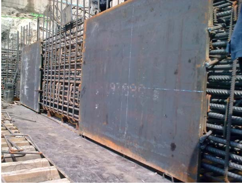
Şekil 5.41 : Kuşak kirişi içerisine yerleştirilen çelik plakalar
