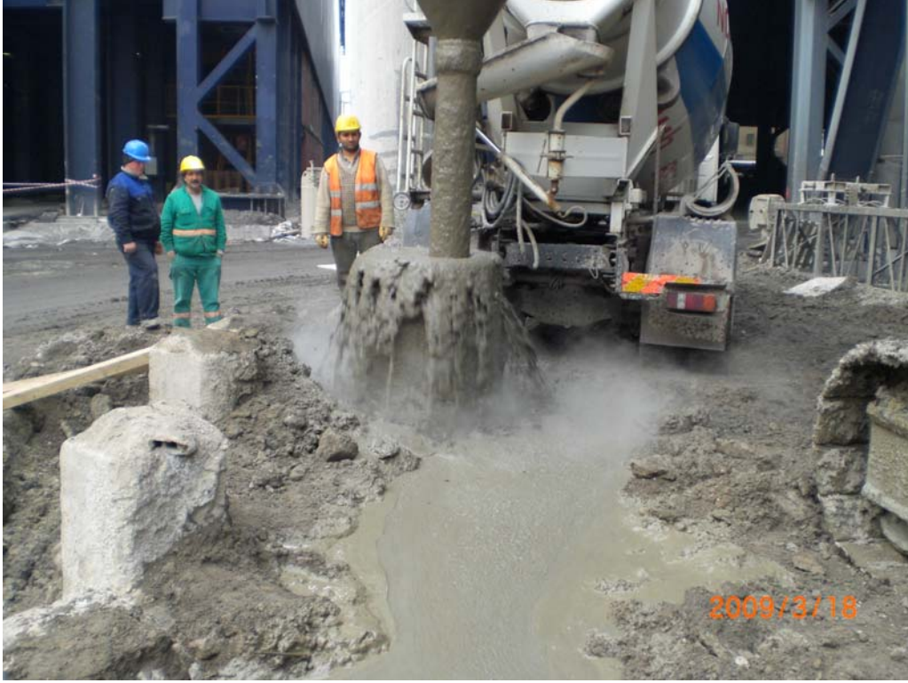
Şekil 5.9 : Tremi ile beton dökümü ve taze betonun ağızdan kusturulması
