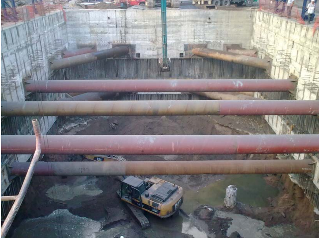
Şekil 5.47 : Boru desteklerin altında kazı yapılması
