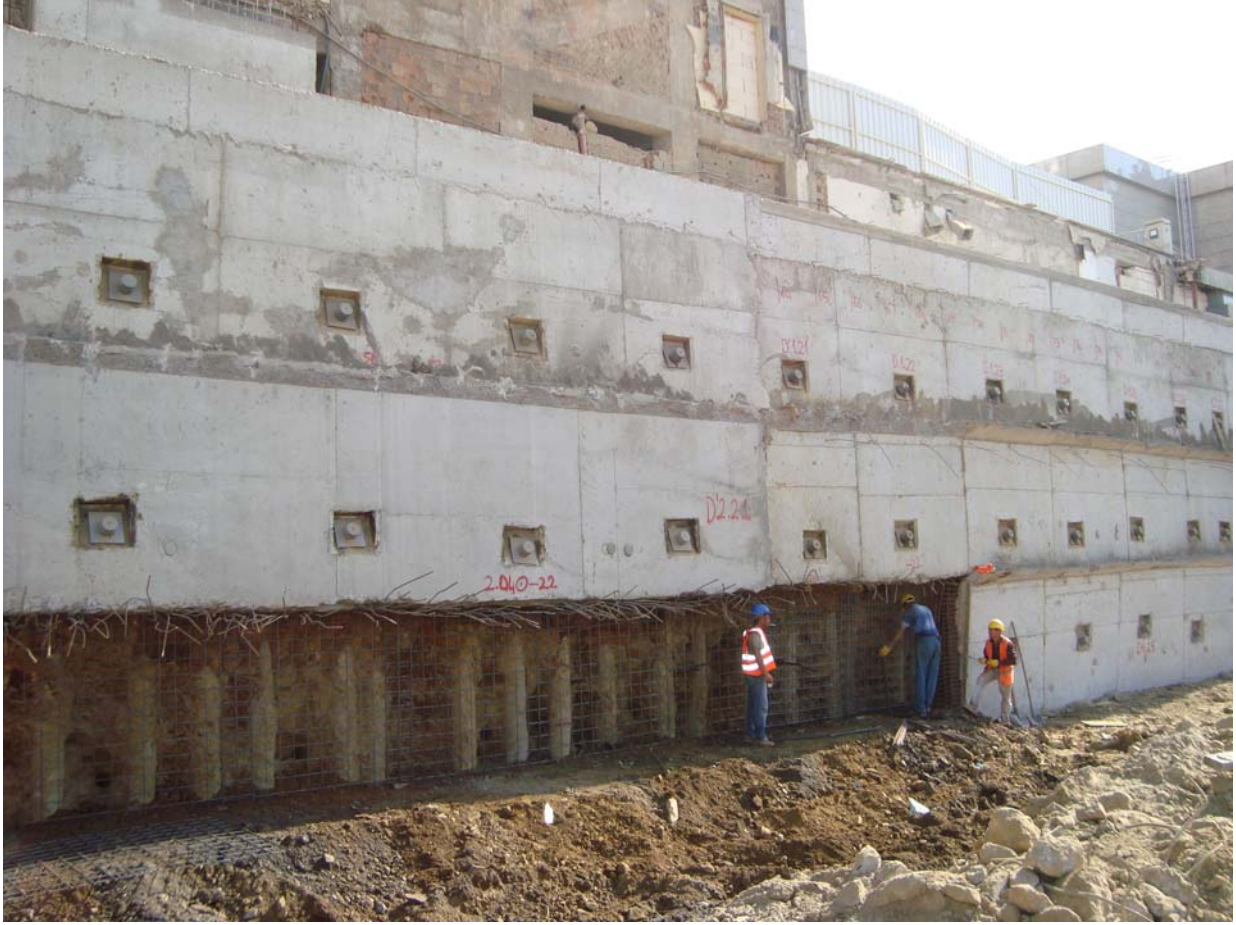
Şekil 5.12 : Mini kazıklı aç-kapa betonarme perde
