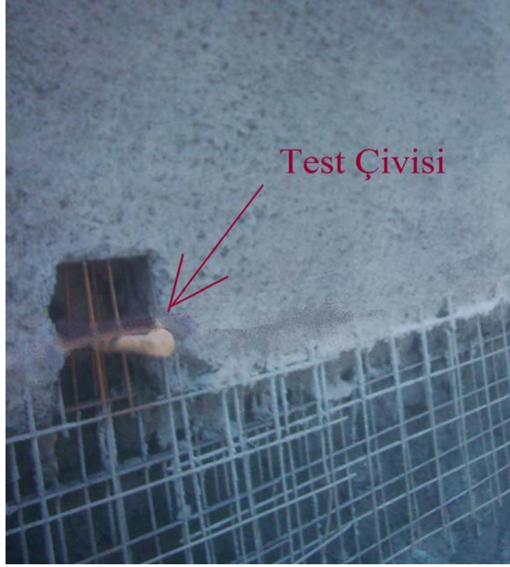
Şekil 5.34 : Test çivisi
