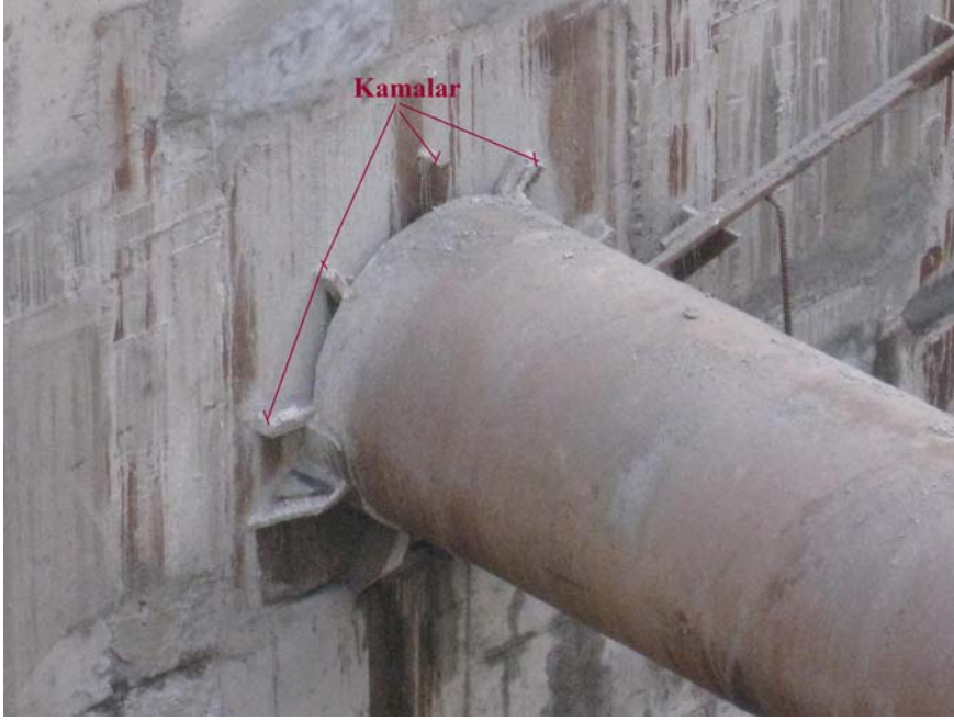
Şekil 5.43 : Boşluğu kama ile alınmış boru destek
