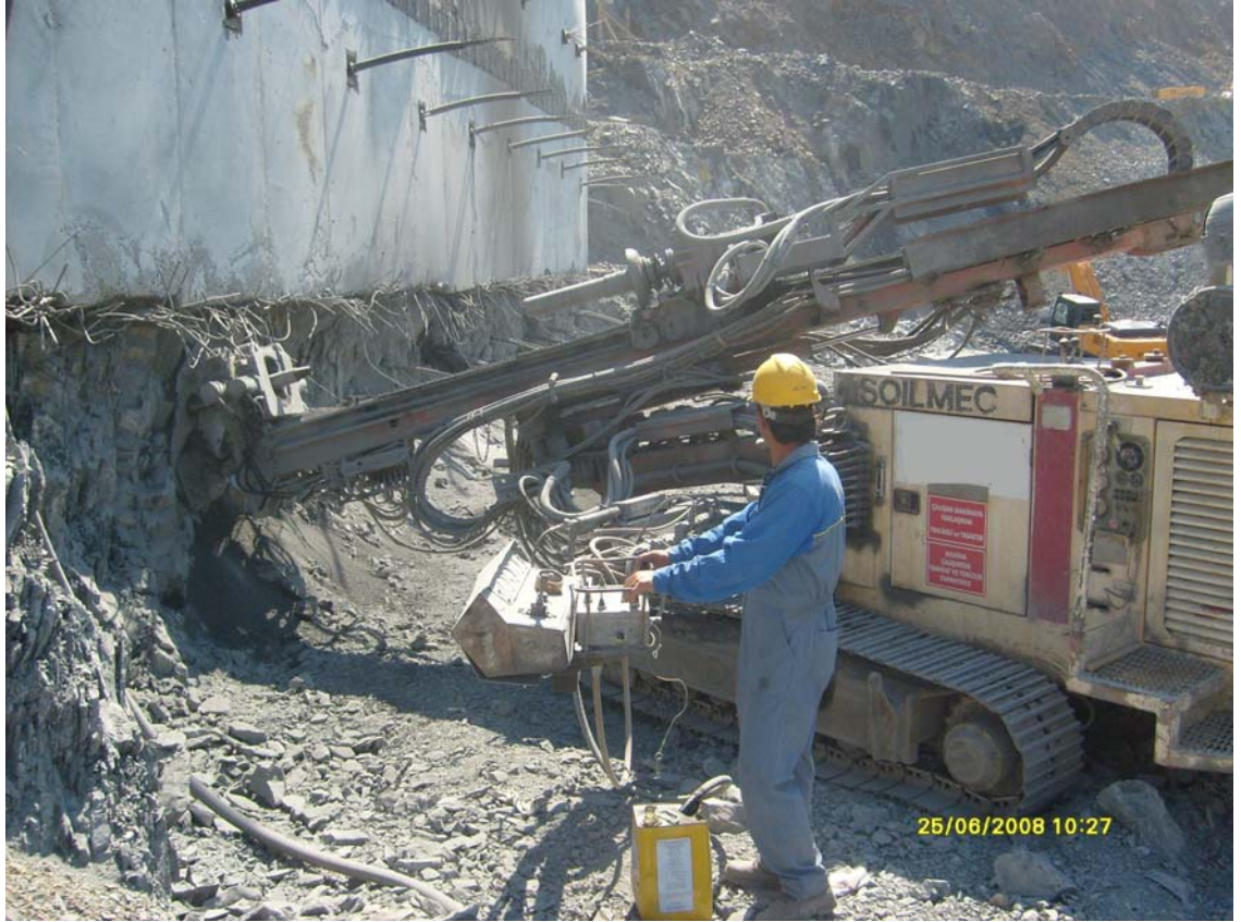
Şekil 5.19 : Ankraj delgi işlemi
