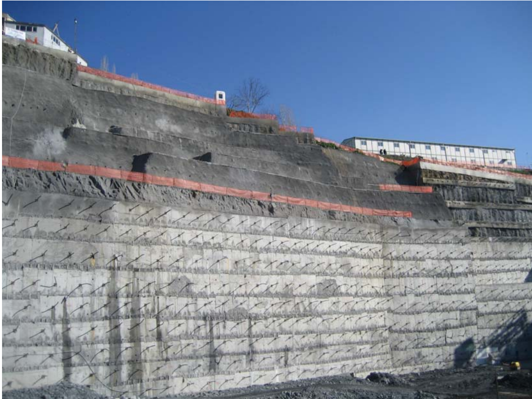
Şekil 2.1 : Anthill Rezidans derin temel kazısı
