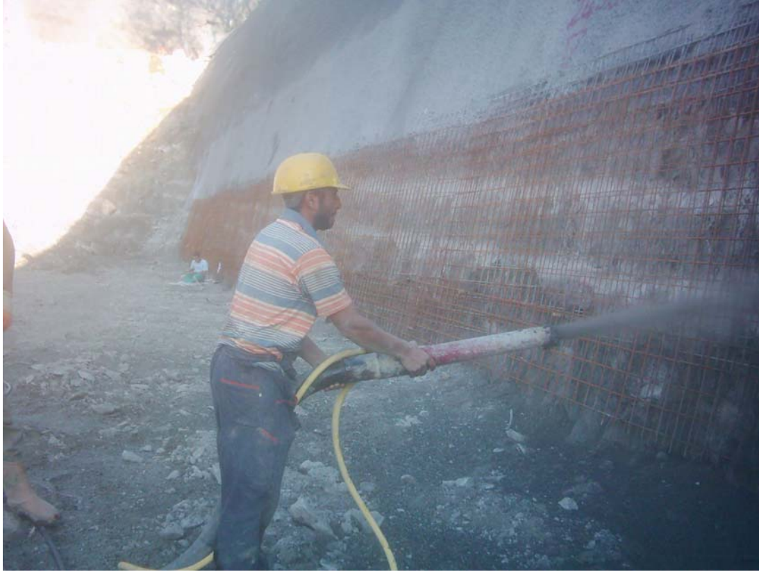
Şekil 5.13 : Püskürtme betonlu kaplama
