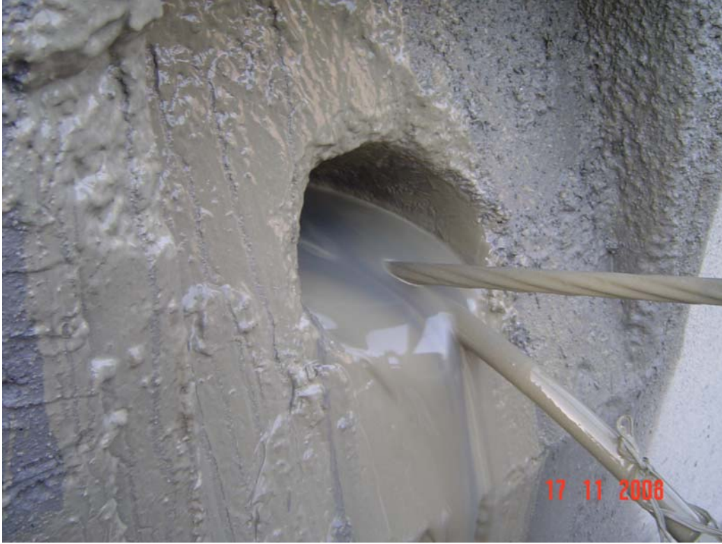
Şekil 5.22 : Kılavuz enjeksiyon yapılması
