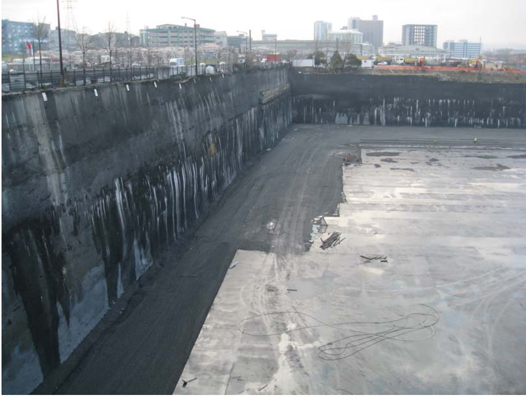
Şekil 5.29 : Zemin çivili püskürtme beton kaplamalı duvar
