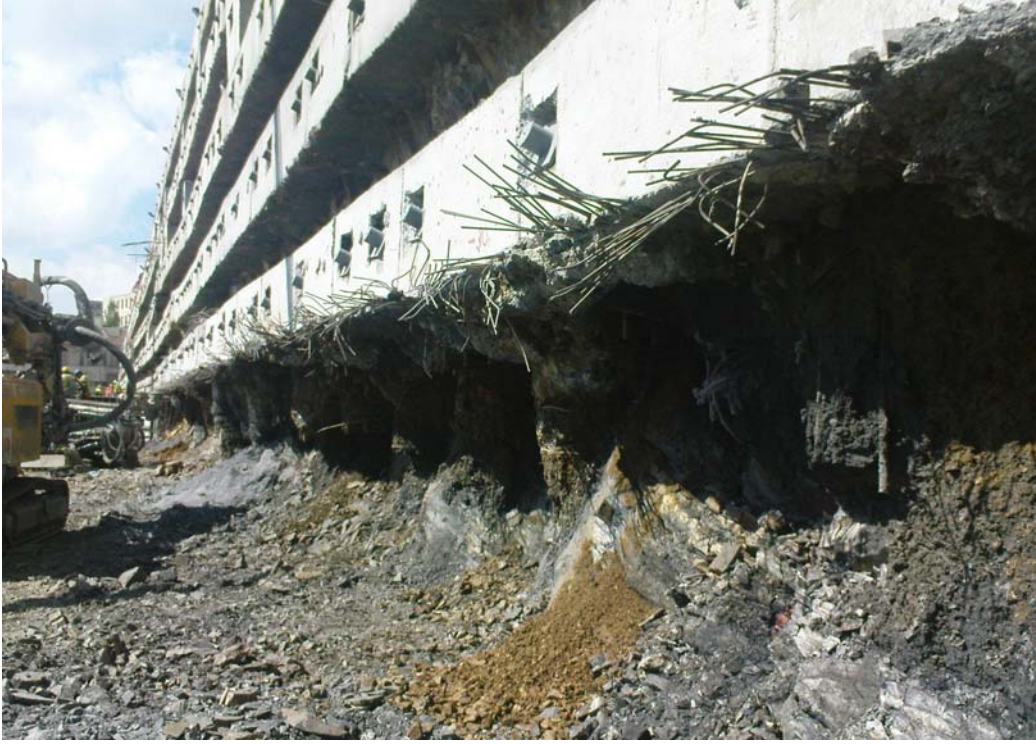
Şekil 5.26 : Fore kazıkların altının boşaltılması
