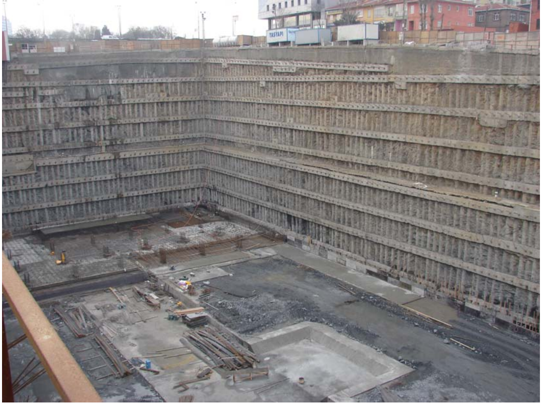
Şekil 2.2 : Trump Towers derin temel kazısı
