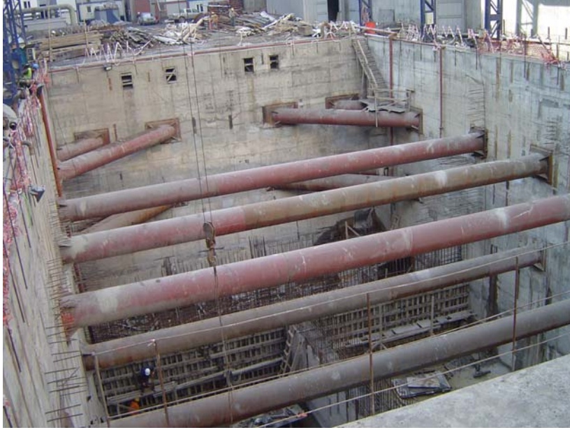
Şekil 2.4 : Çolakoğlu Metalurji A.Ş. Dilovası Demir ve Çelik Tesisleri Tufal Havuzu
