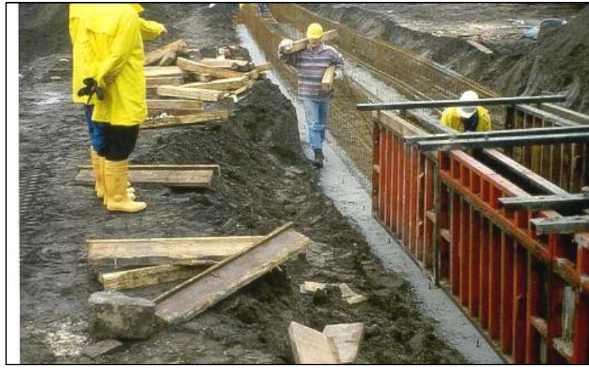
Şekil 5.3 : Kılavuz duvar
