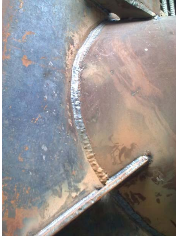
Şekil 5.44 : Boşluğu tamamen kaynakla doldurulmuş boru destek
