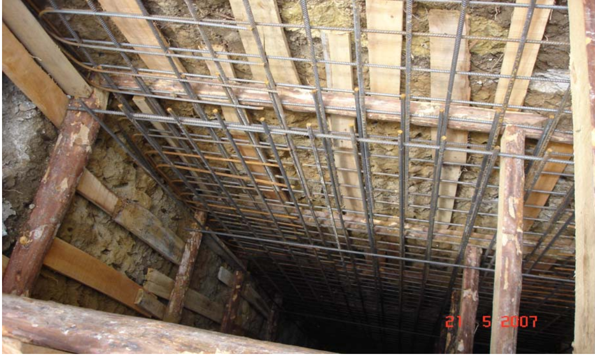
Şekil 5.1 : Kuyu perde çukuru ve ahşap destekleri
