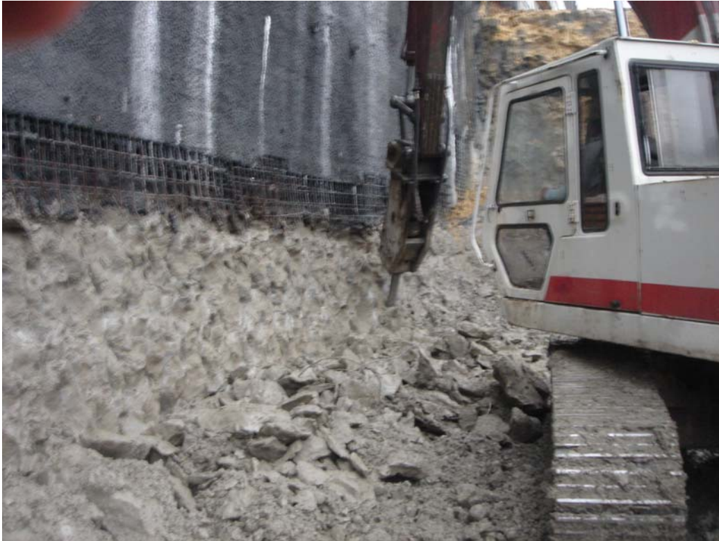
Şekil 5.30 : Kademe kazısı ve yüzey tesviyesi
