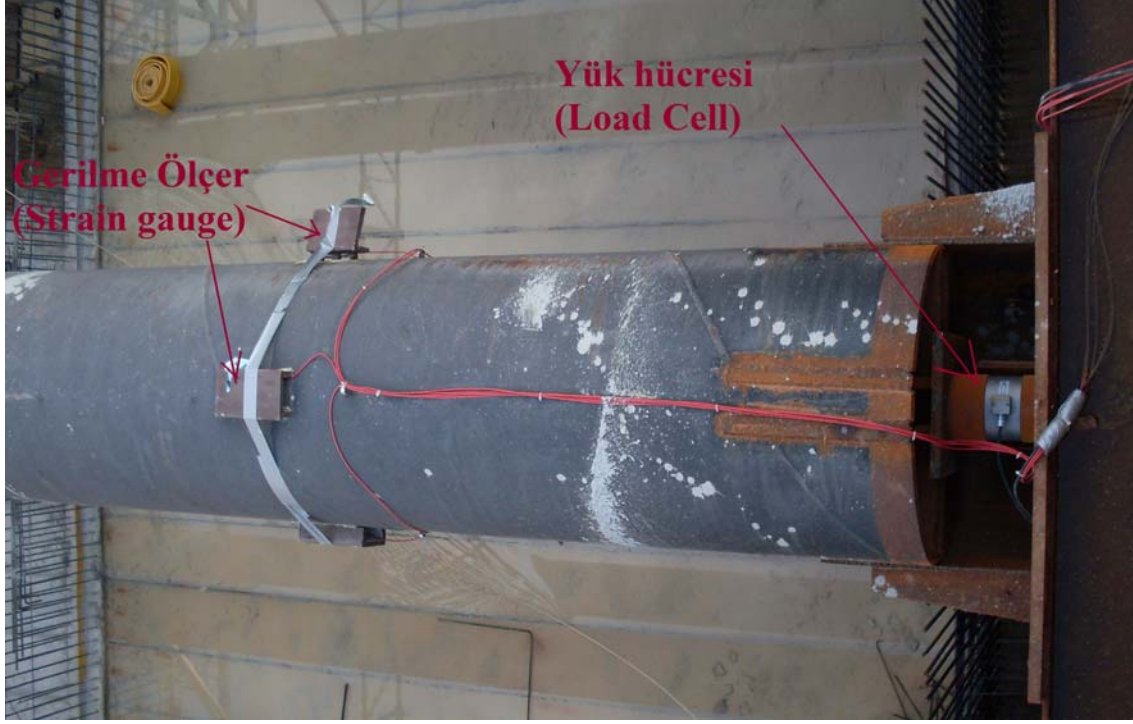
Şekil 5.46 : Yük hücresi ve gerilme ölçer yerleştirilmiş boru destek
