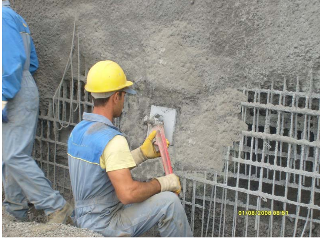
Şekil 5.32 : Somun sıkıştırılması
