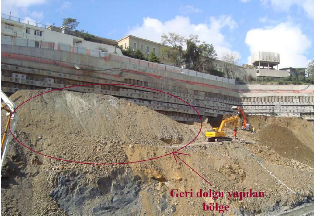
Şekil 6.15 : Üst sıralarda ilave ankraj imalatı yapacak platformun teşkili için geri dolgu yapılması
