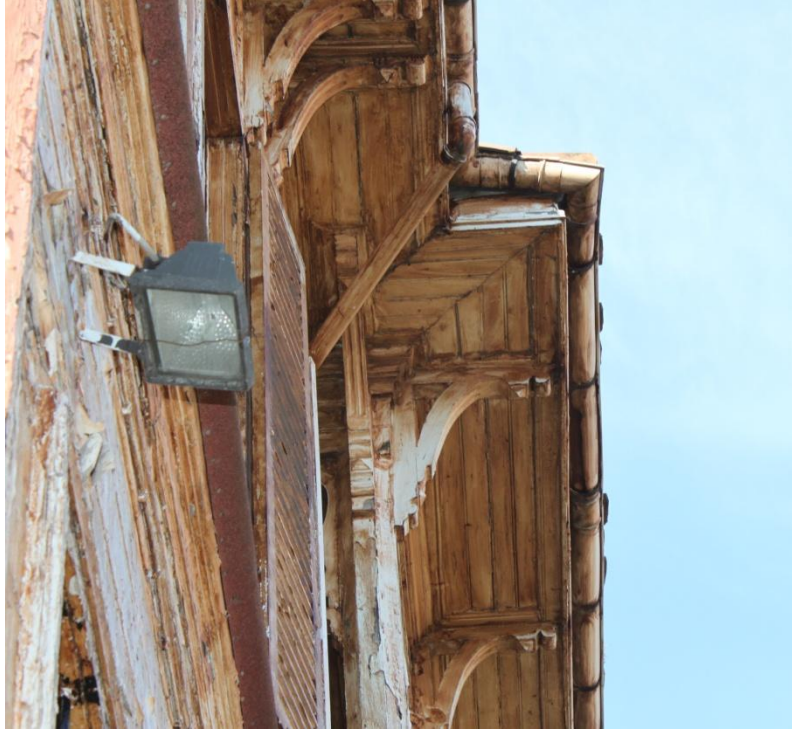
Şekil C89- Çıkma destekleri, konsollar.
