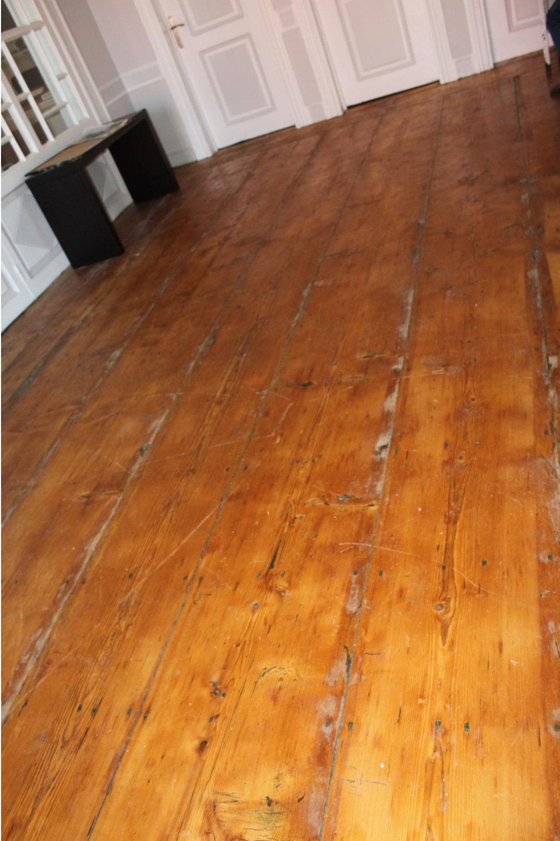
Şekil C75- Ahşap rabıta döşeme.
