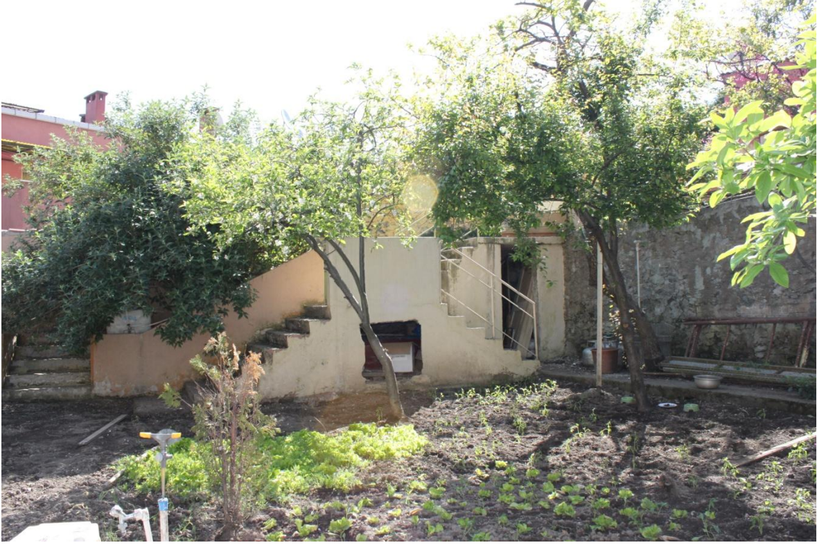
Şekil C7- Bahçe merdiven altı depo girişi.
