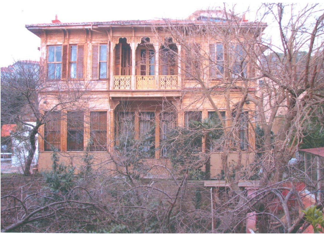
Şekil C67- Kuzey yan cephe.
