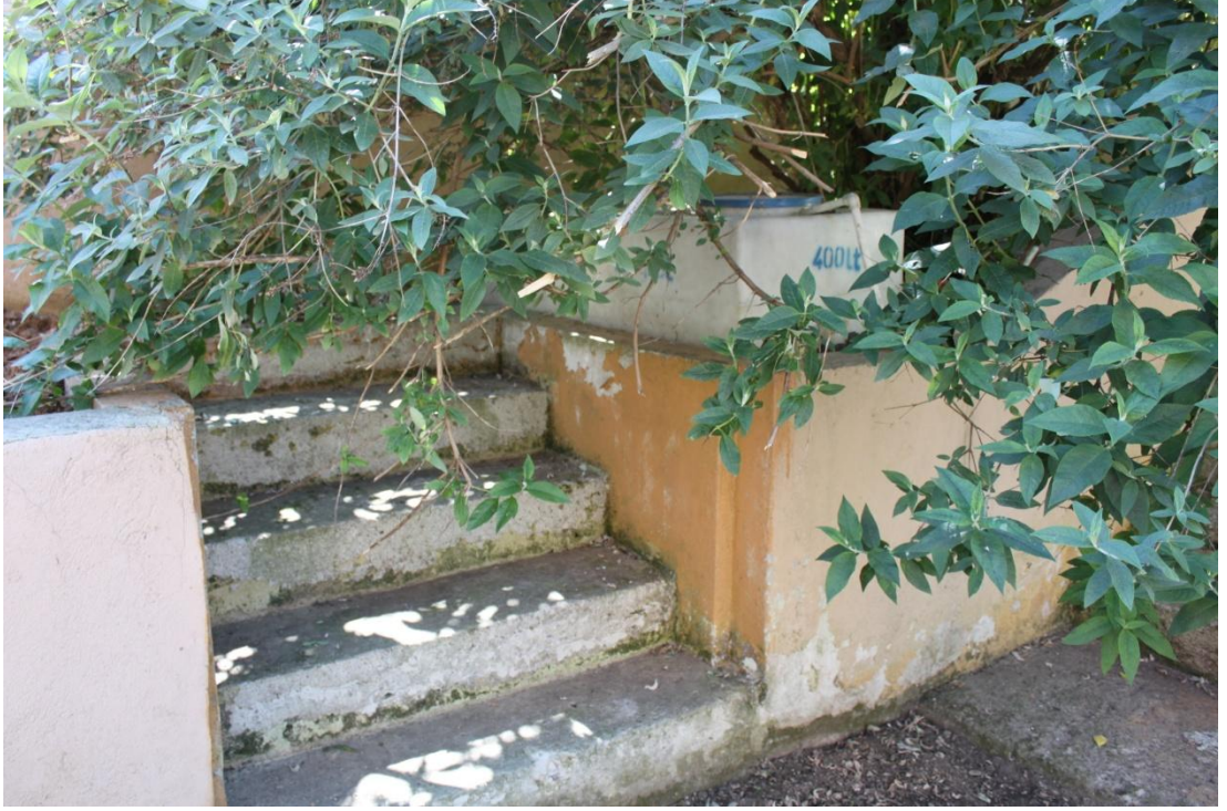
Şekil C123-Bahçede bulunan su deposuna varılan merdiven.
