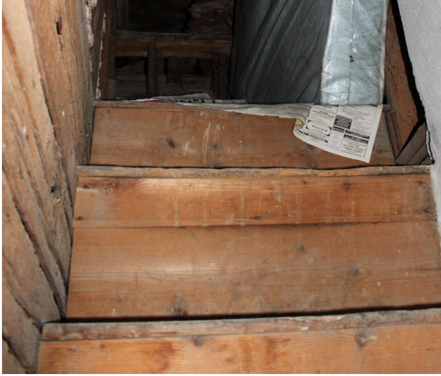
Şekil C127-Çatıya çıkan merdiven.
