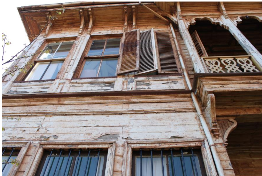
Şekil C95- Kuzey cephe kat kornişi
