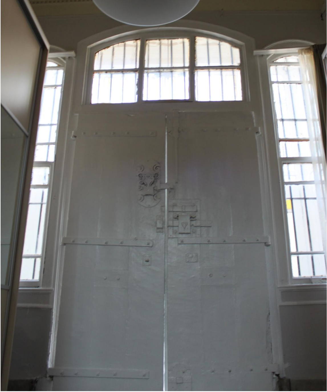
Şekil C106- Yapı giriş kapısı iç görünüşü
