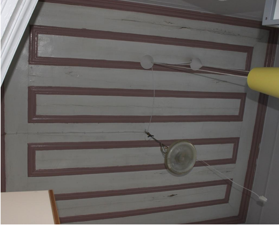
Şekil C129-Zemin Z16 mutfak tavanı.
