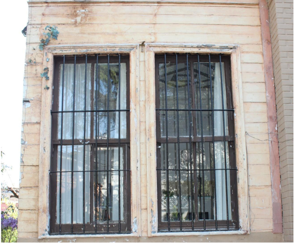
Şekil C115- Zemin kat giriş cephesi Z03 oda mekanı pencereleri.
