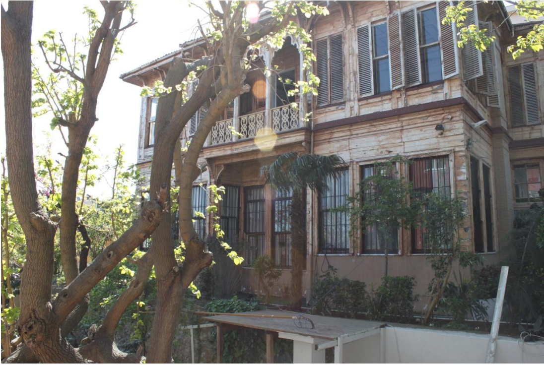
Şekil C68- Kuzey yan cephe.
