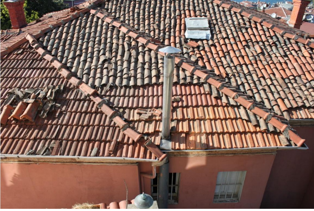
Şekil C145- Çatıda kullanılan farklı malzemeler.
