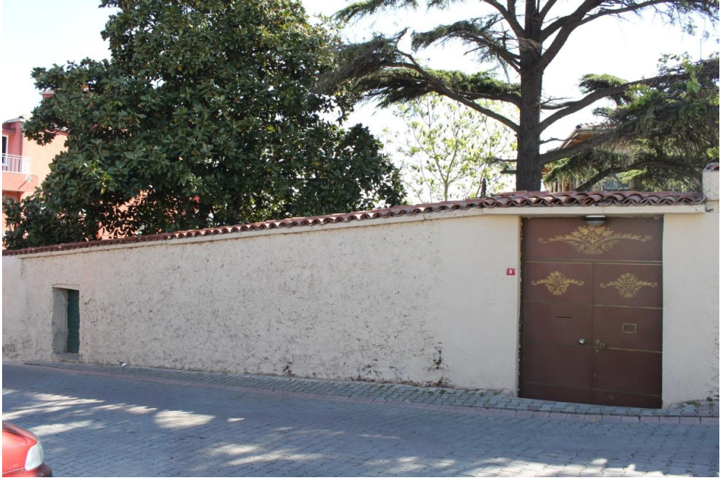
Şekil C1- Şemsibey sokaktan yapıya bakış.
