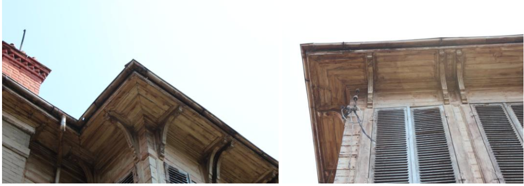
Şekil C92- C93- Saçak altı konsolları
