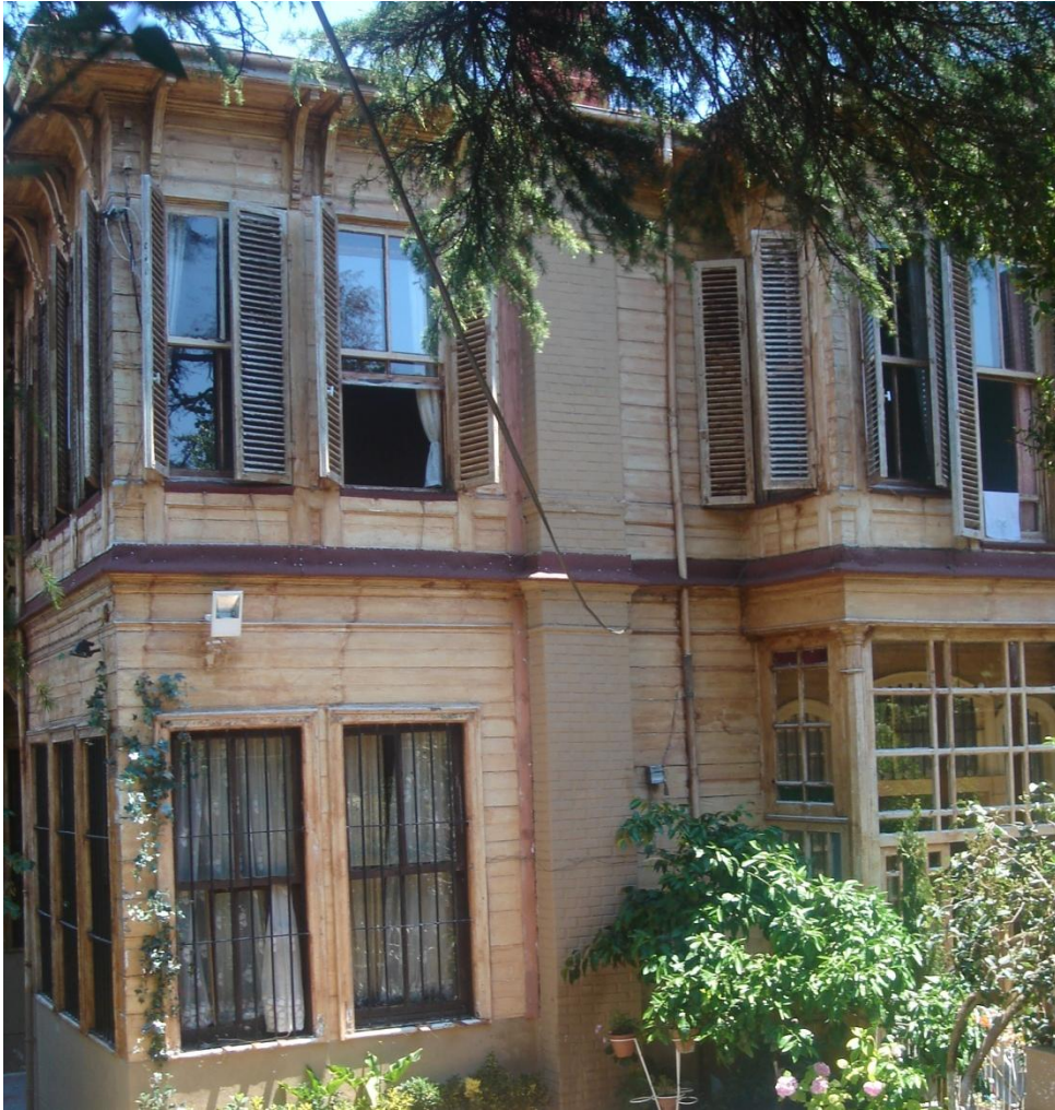
Şekil C87- Kat silmeleri
