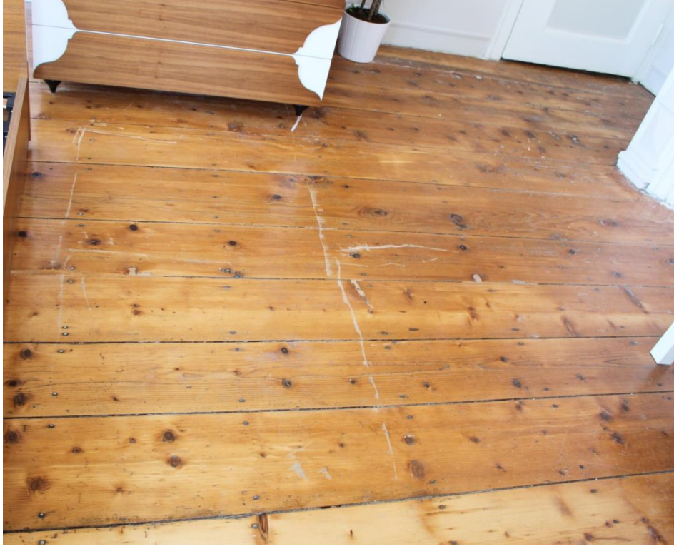
Şekil C76- Ahşap rabıta döşeme.
