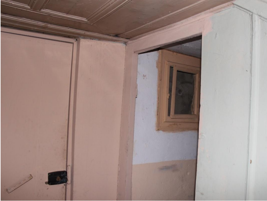
Şekil C40- Bahçe kapısı ve Z07 Merdiven altı depo.
