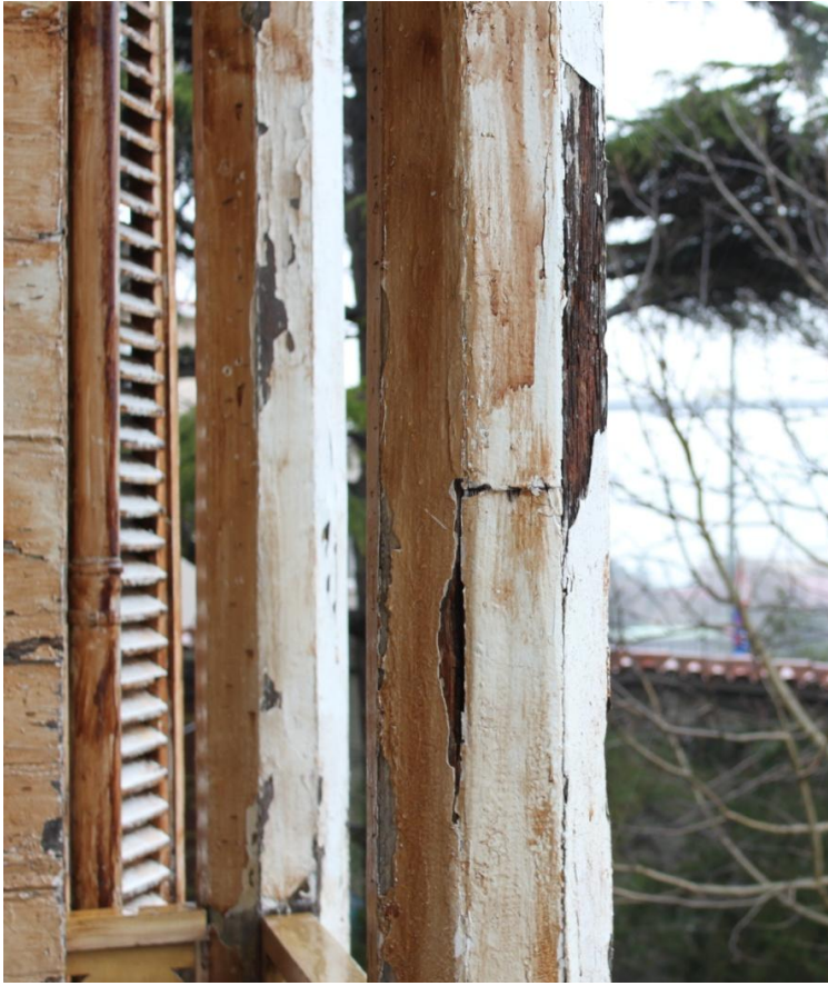
Şekil C138- Ahşap cephede kopmalar.
