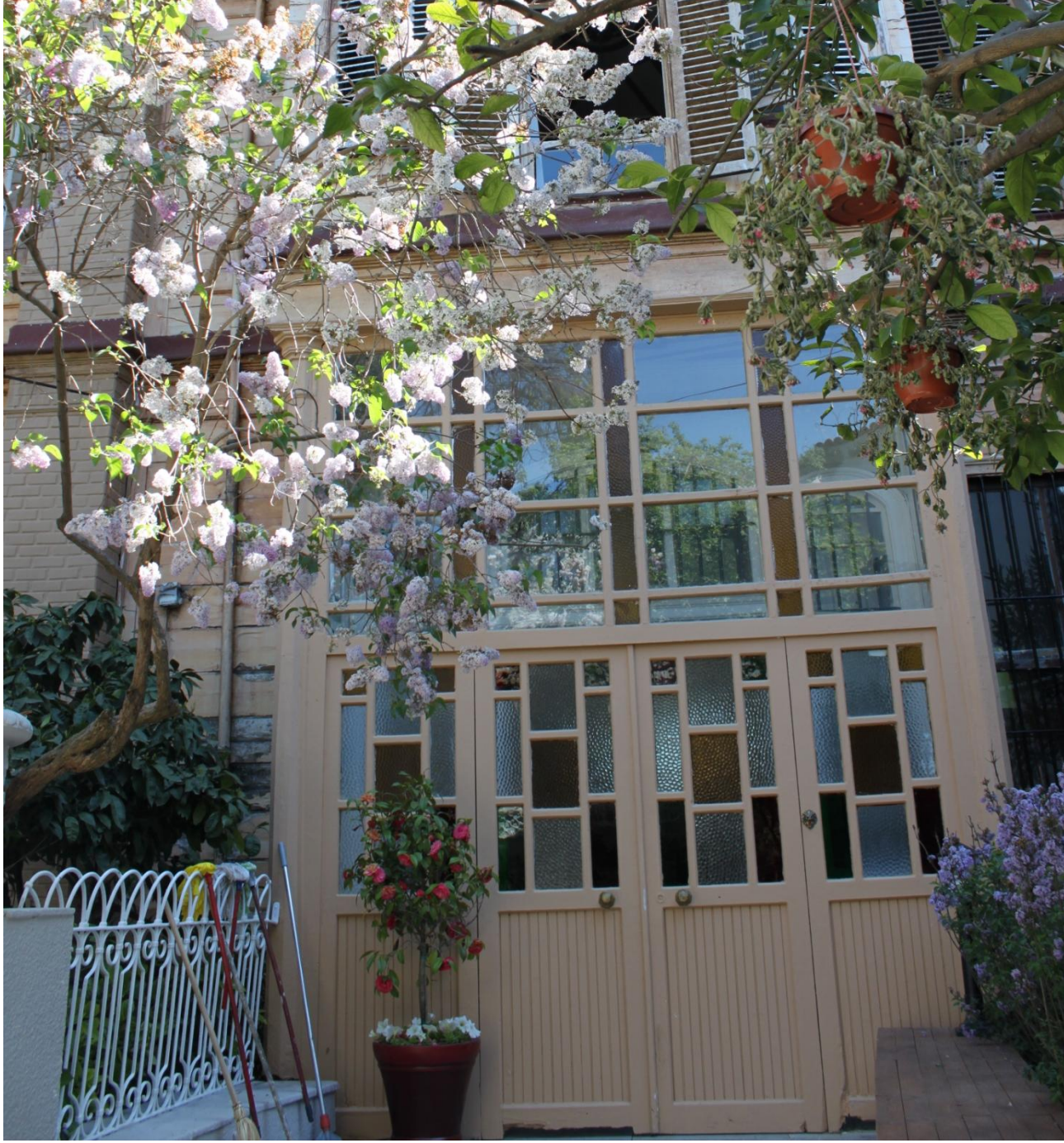
Şekil C107- Yapı giriş kapısı önü camlı kapı
