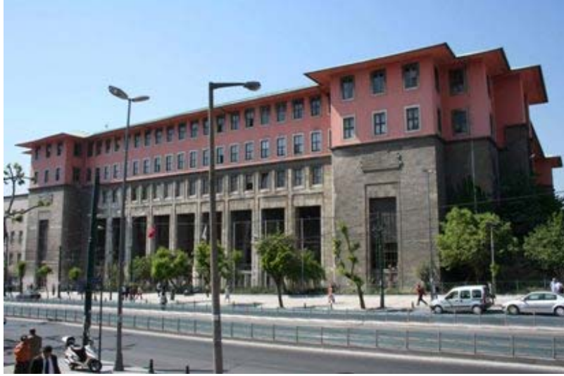
Şekil 39: İçerisinde Coğrafya Bölümünü de Barındıran İstanbul Üniversitesi Edebiyat Fakültesi Binası
