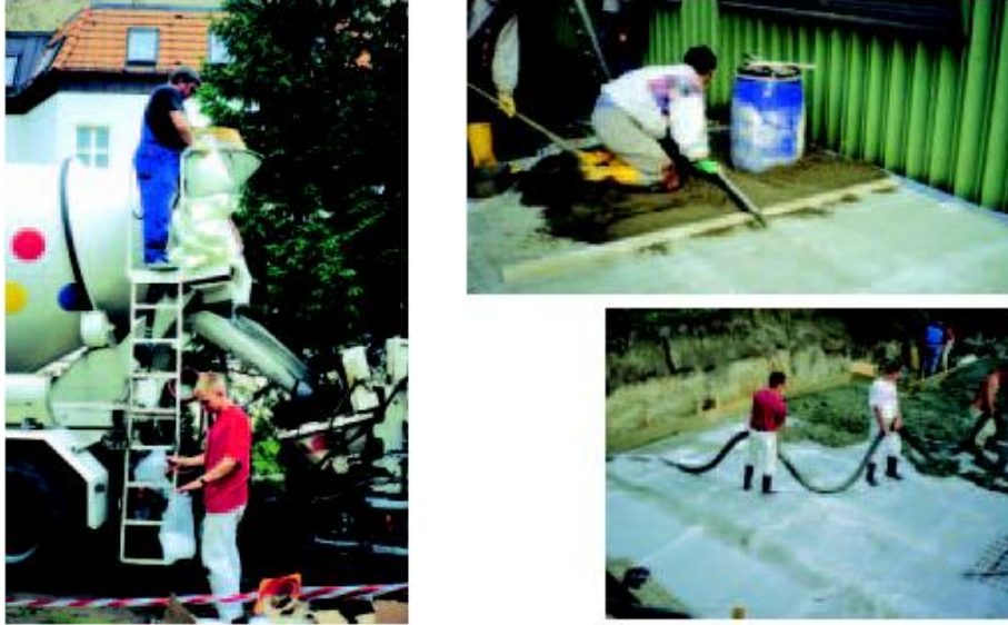
Şekil 2.20 : CTÇ (GRC)'nin temel ve döşemelerde kullanım örnekleri [4].
