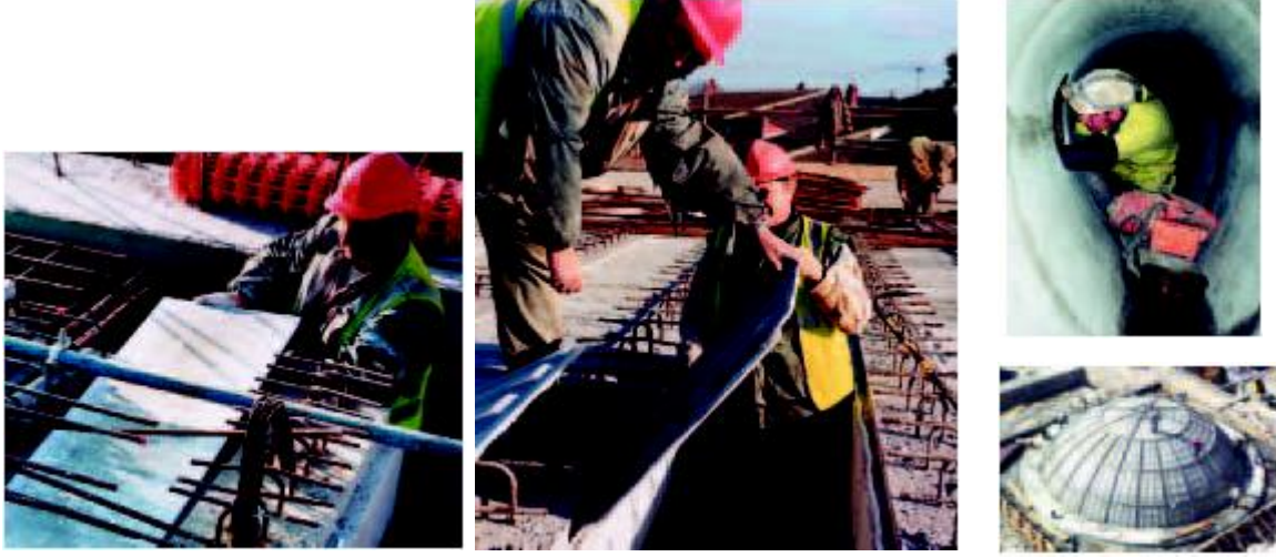
Şekil 2.22 : CTÇ (GRC)'nin kalıcı kalıp olarak kullanım örnekleri [4].
