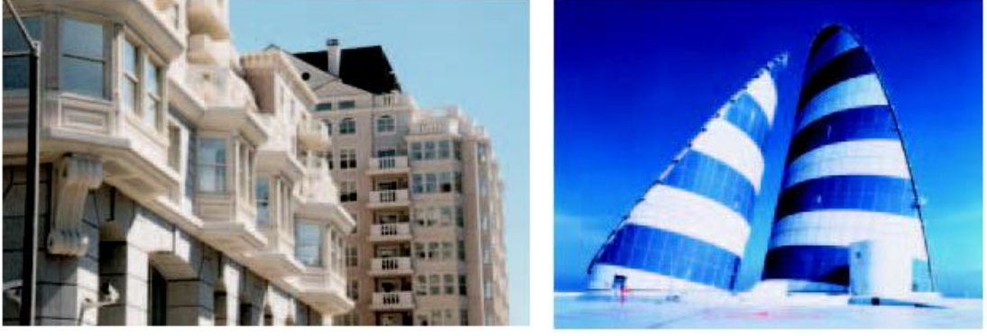
Şekil 2.13 : CTÇ (GRC)'nin cephe kaplaması olarak kullanım örnekleri [4].
