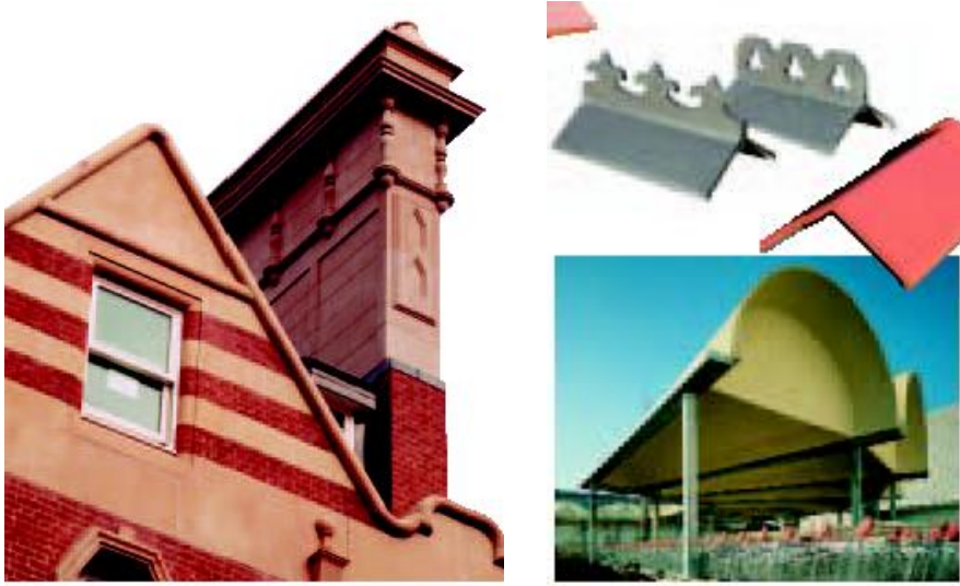
Şekil 2.17 : CTÇ (GRC)'nin çatı kaplama malzemesi olarak kullanım örnekleri [4].
