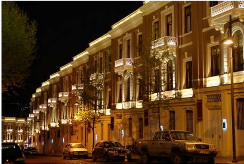
Şekil 2.9 : Akaretler Sıraevleri - Bağımsız Ofis Binası
