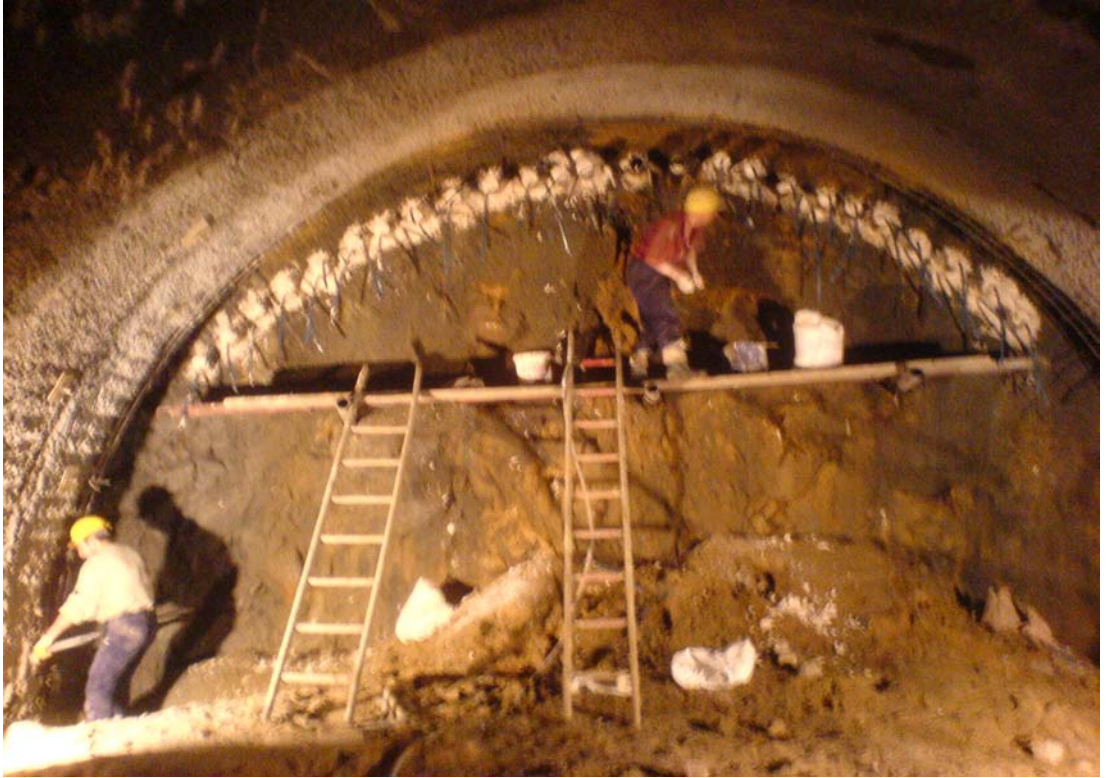
Şekil 6.21 : Boruya enjeksiyon yapılmadan önce ağız kısmının alçı ile kapatılması
