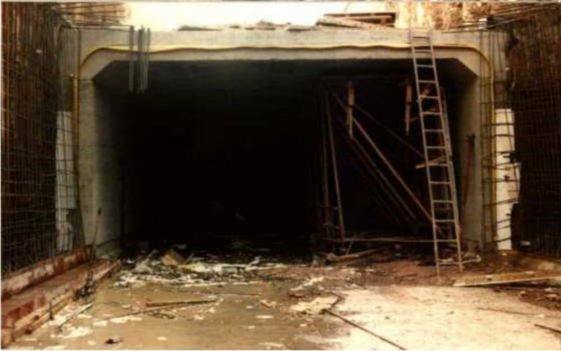
Şekil 4.2 : Tavan ve yan duvar kaplaması tamamlanmış bir tünel
