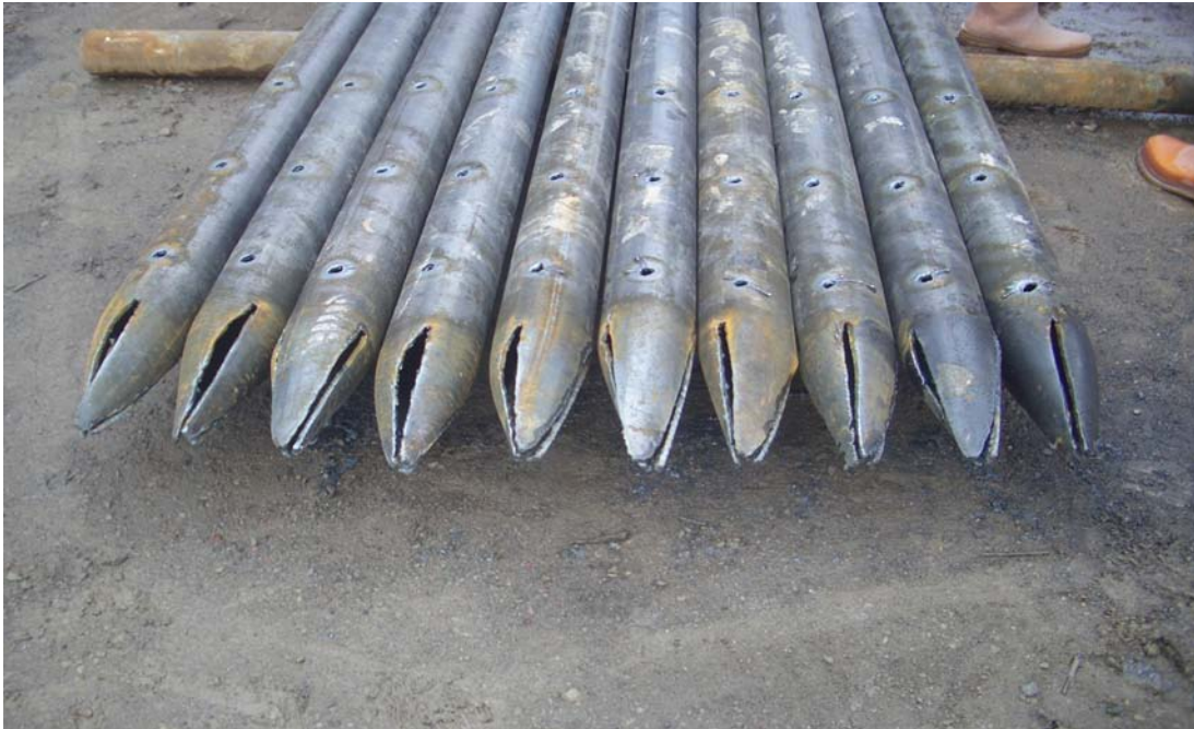
Şekil 6.19 : Şemsiye boruları uç kısımlarının ve enjeksiyon deliklerinin hazırlanması
