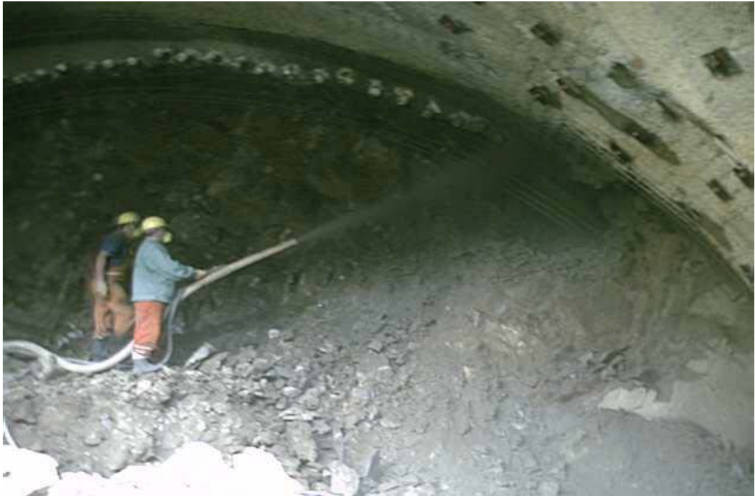
Şekil 6.12 : Üstyarı kazısına püskürtme beton uygulaması
