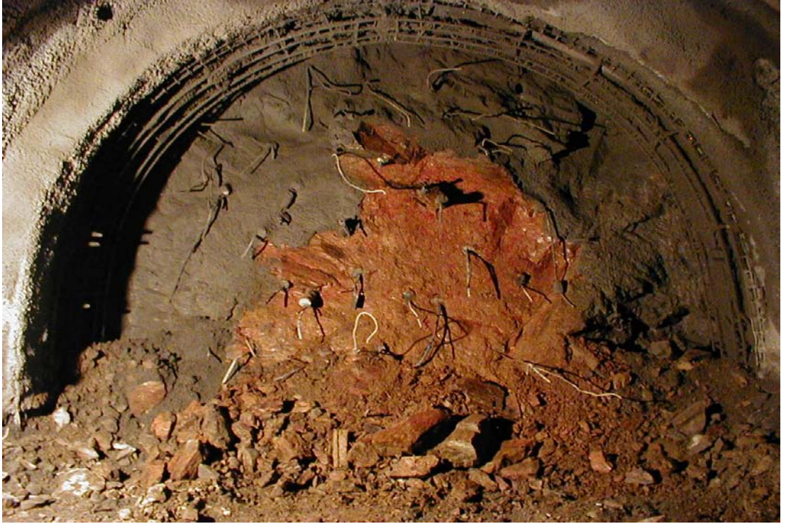
Şekil 6.24 : Zemin çivisinin aynada uygulaması
