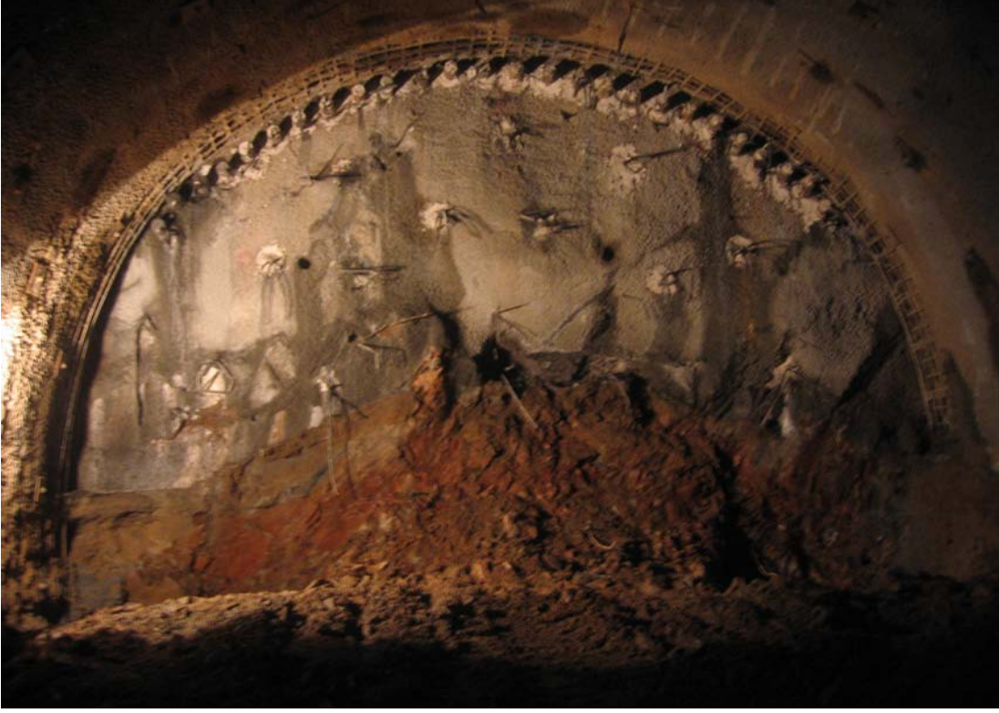
Şekil 6.25 : Zemin çivilerinin ve şemsiye borularının delik bölgelerine yerleştirilmesi ve enjeksiyonları
