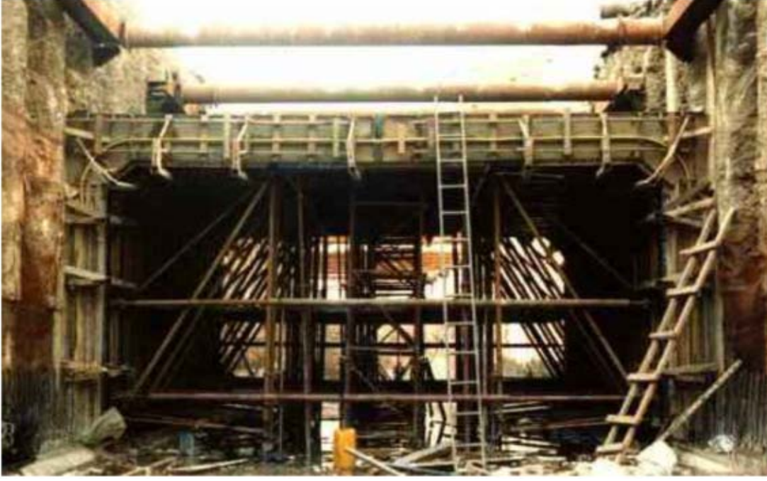
Şekil 4.1 : Aç-kapa tünel çalışmasında tavanın ve yan duvarın kaplanması
