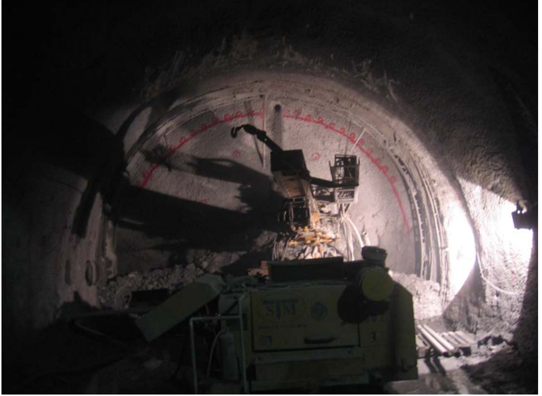
Şekil 6.20 : Şemsiye borularının aynada işaretlenmesi ve boruları yerlerinin delgisi
