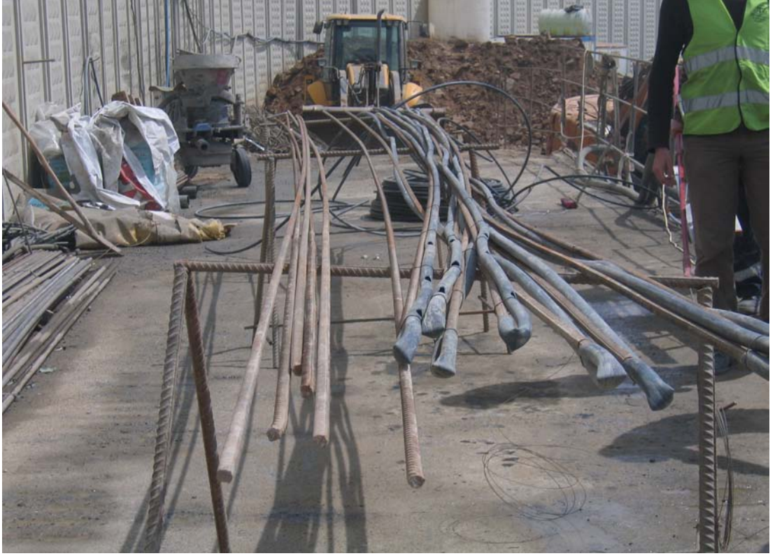
Şekil 6.23 : Zemin çivisi enjeksiyon borularının hazırlanışı
