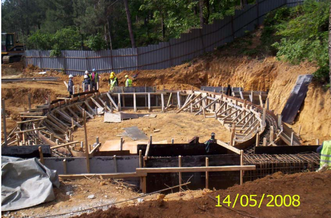
Şekil 6.4 : Şaft bilezik betonu kalıbı
