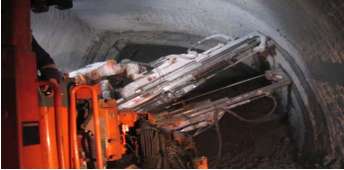
Şekil 6.16 : Bulon delgisi yapan jumbo makinesi
