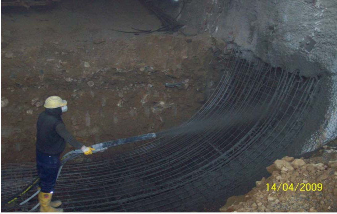
Şekil 6.13 : Altyarı kazısına püskürtme beton uygulaması
