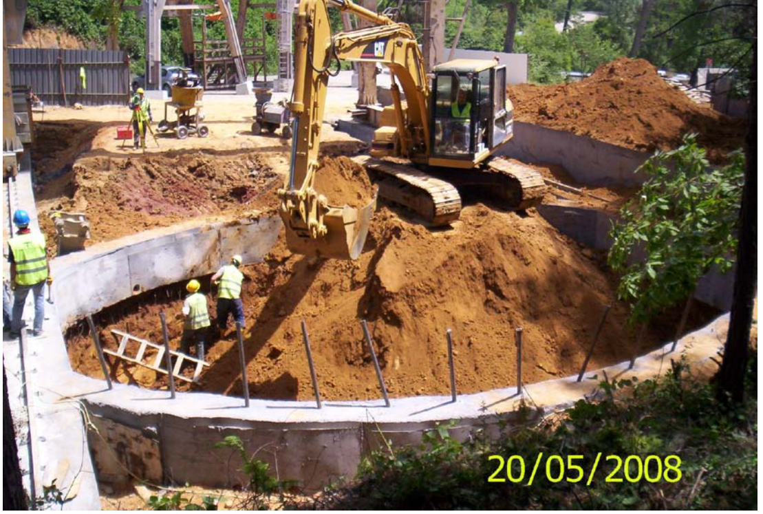
Şekil 6.5 : Şaft kazısı
