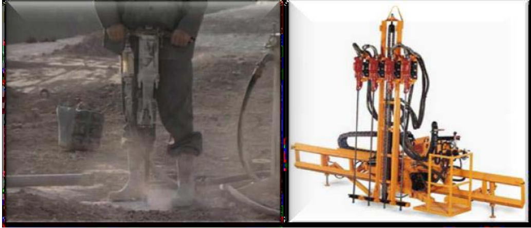
Şekil 3. 3. Delme çatlatma yönteminde deliklerin açılması (Onargan, 2005)
