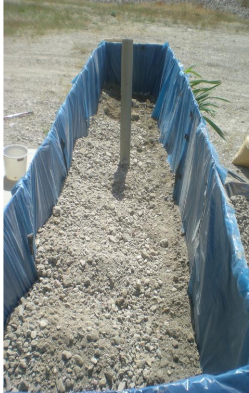
Şekil 2.4. Bitkiler için hazırlanan yatak, dolgu malzemeleri, giriş ve çıkış yapıları
