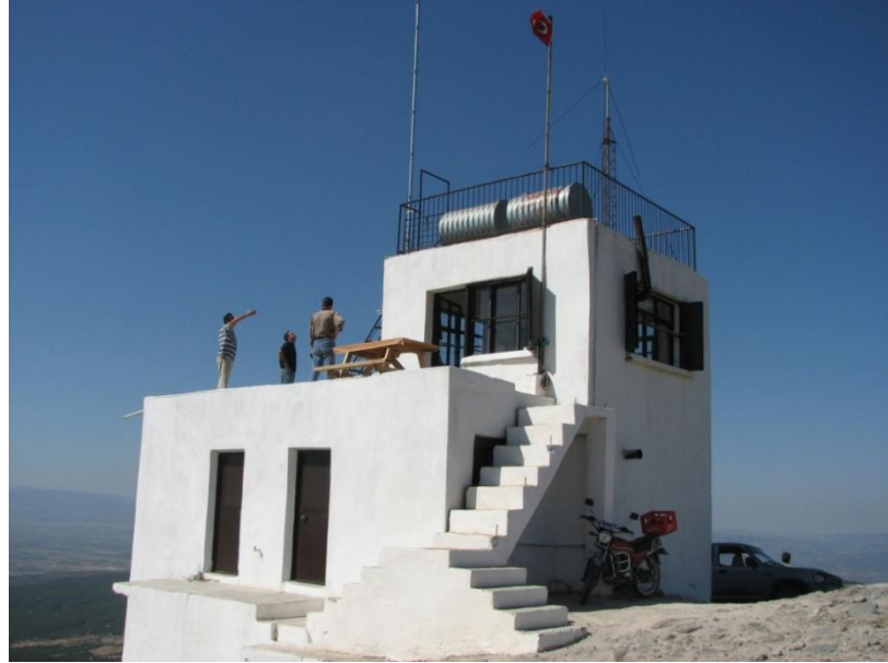
Şekil 2.7: Yangın Gözetleme Kulesi (Foto: Anonim, 2010)
