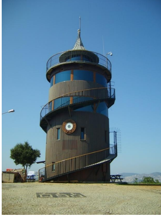
Şekil 4.2: Yangın Gözetleme Kulesi, Büyükada (Foto: A. Küçükosmanoğlu, 2010)
