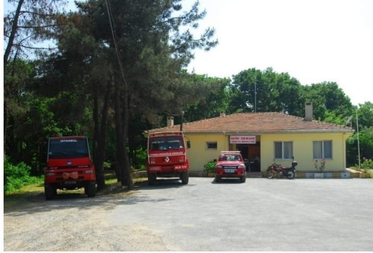
Şekil 4.8: Fatih Ormanı İlk Müdahale ve Hazır Kuvvet Ekip Binası (Foto: A. Küçükosmanoğlu, 2010)
