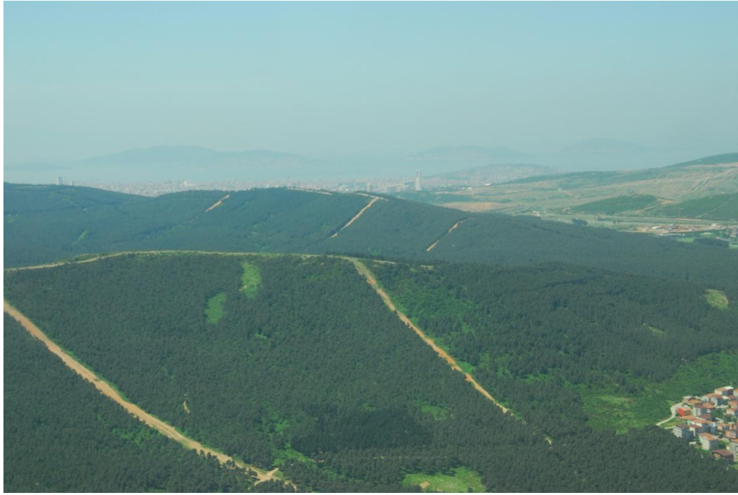
Şekil 2.5: Yangın Emniyet Yolu (Foto: A. Küçükosmanoğlu, 2010)
