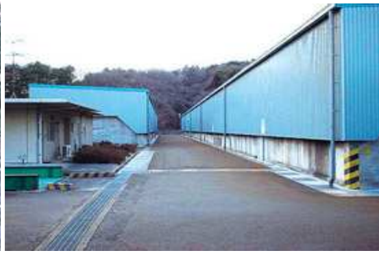
Yönetim Binası ve Depo
