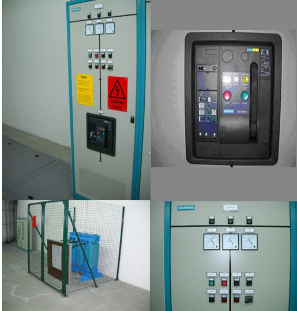
Şekil A.1 : Bursaray-1 fiderine tesis edilen tek kademe şönt reaktörlü RGK.
