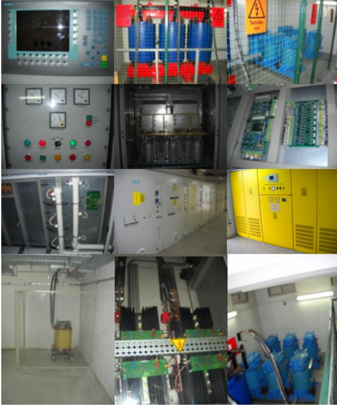
Şekil A.2 : Bursaray-2 fiderine tesis edilen TAŞR+AKAGF sistemi.
