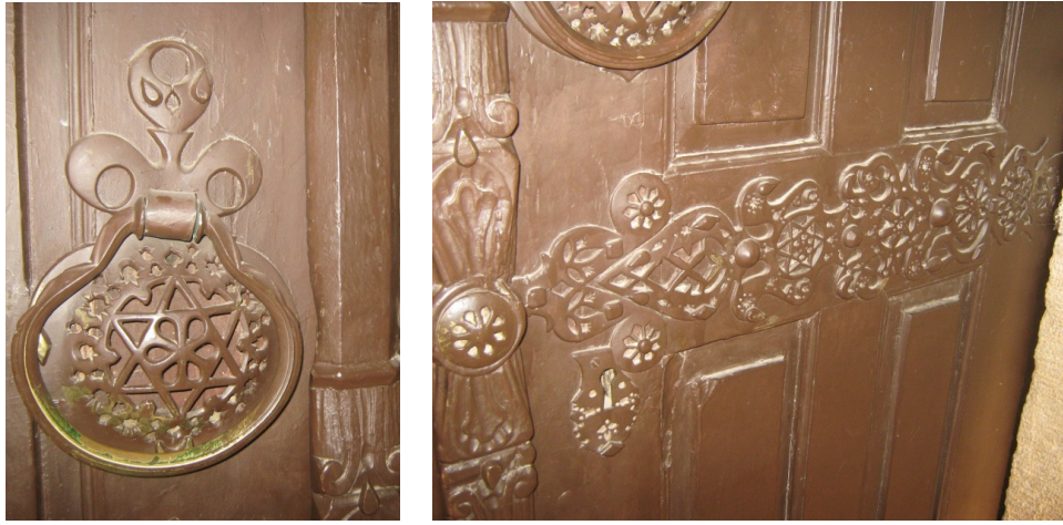
Resim 77. Kapı menteşesi ve tokmağında bulunan işlemler
