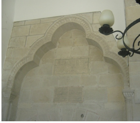
Resim 46. Giriş kapısı ve zekat penceresi
