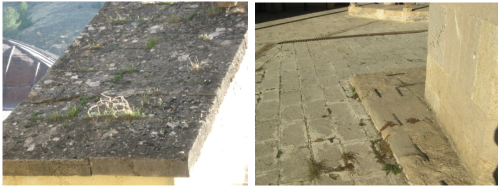
Resim 71. Taş karolarda kullanılan metal bağlantı ve çevrede bulunan oluklar.
