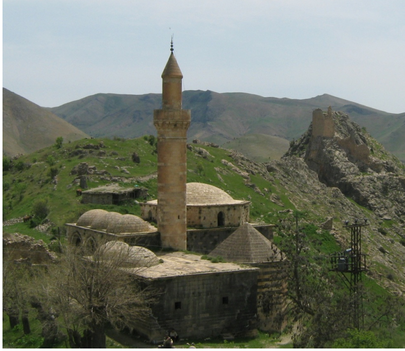
Resim 34. Pertek Sağman (Salih Bey) Camii cephe resmi
