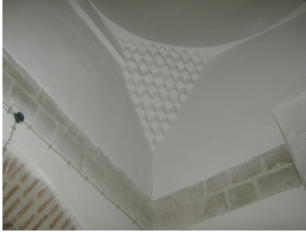
Resim 10. Harput Ulu Camii kubbesinde uygulanan mukarnas geçiş.
