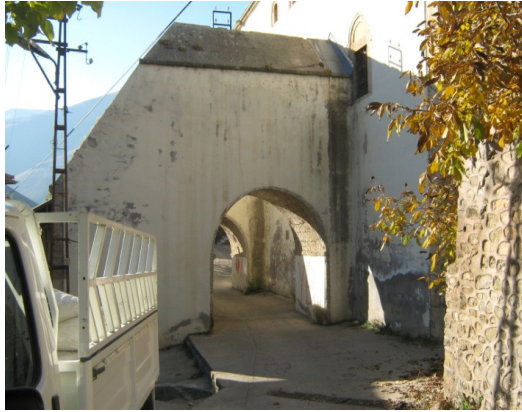
Resim 82. Güney duvarında bulunan payandalar
