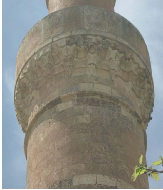
Resim 33. Caminin minaresi ve şerefede bulunan mukarnas işlemleri
