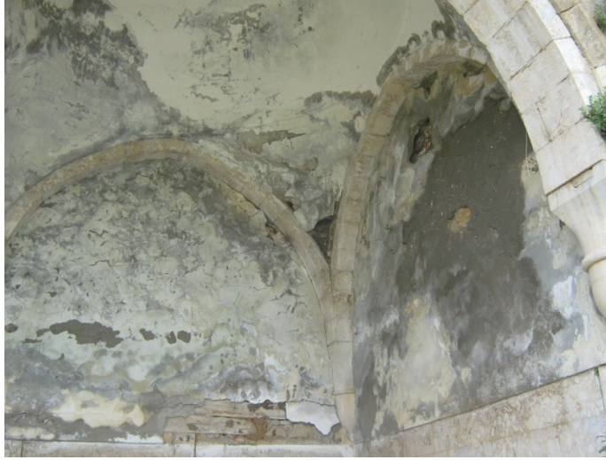
Resim 26. Son cemaat mahfilinde yer alan kör kemerler ve kubbe ye geçiş elemanları.
