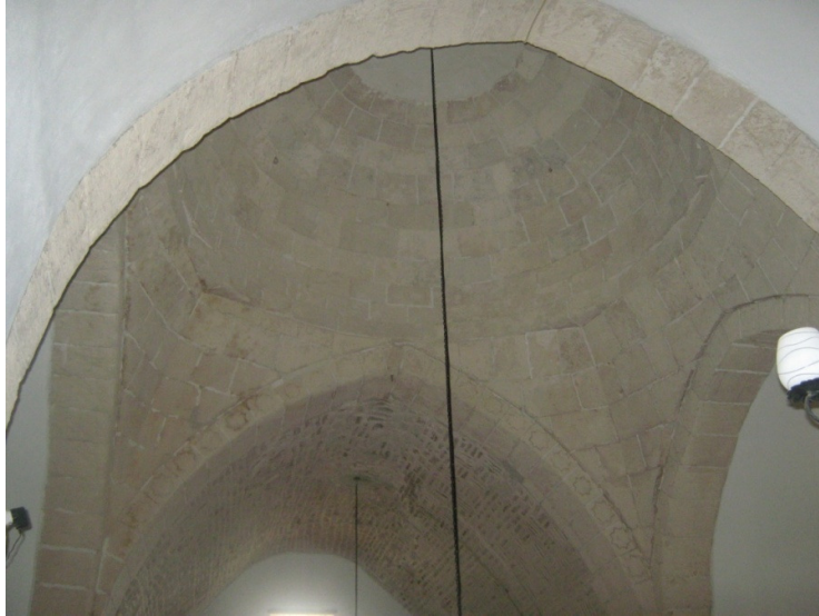
Resim 23. Orta kubbe ve tonozların kesişmesi.
