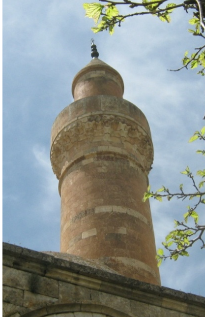
Resim 33. Caminin minaresi ve şerefede bulunan mukarnas işlemleri
