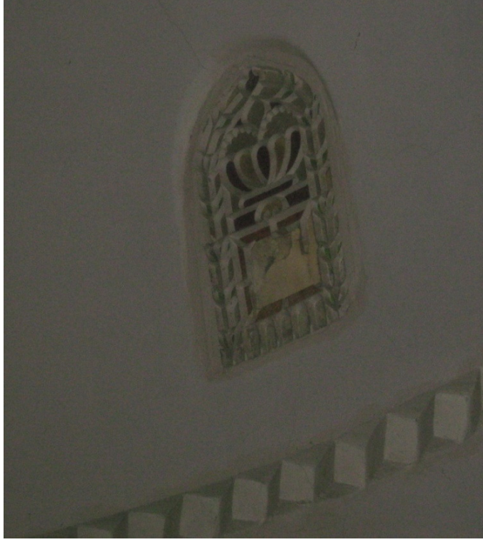
Resim 66. Kubbe kasnağında yer alan taş kafesli vitray camlı pencere
