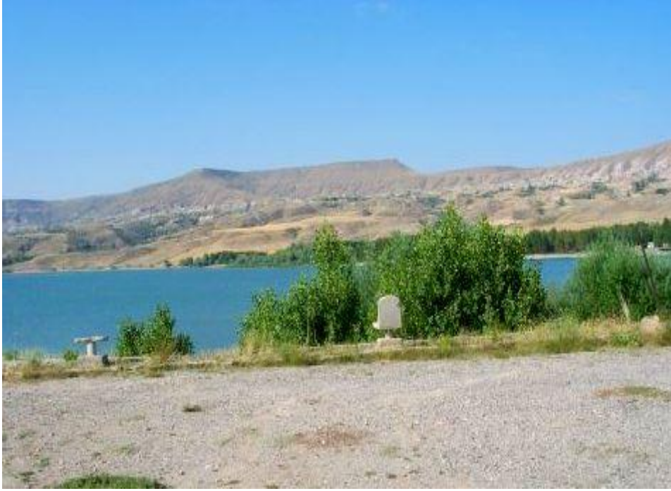
 ekil 82. Damsa Barajı G r n m  ( www.tayproject.org )
