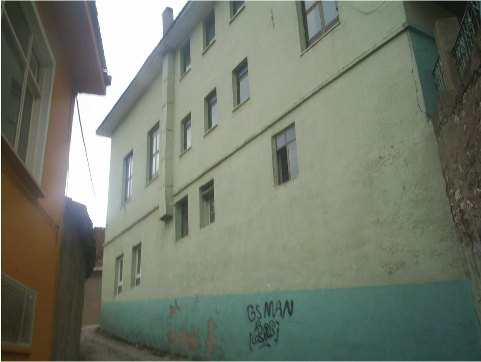
Fotoğraf 13 Yapının Doęu cephesi genel görünüşü
