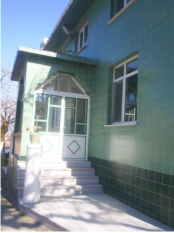
Fotoğraf 86 Kuzey cephede yer alan saçaklı giriş mekânından görünüm
