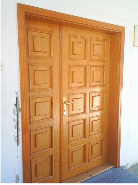
Fotoğraf 286 Caminin Harime Giriş Sağlayan Kapısı
