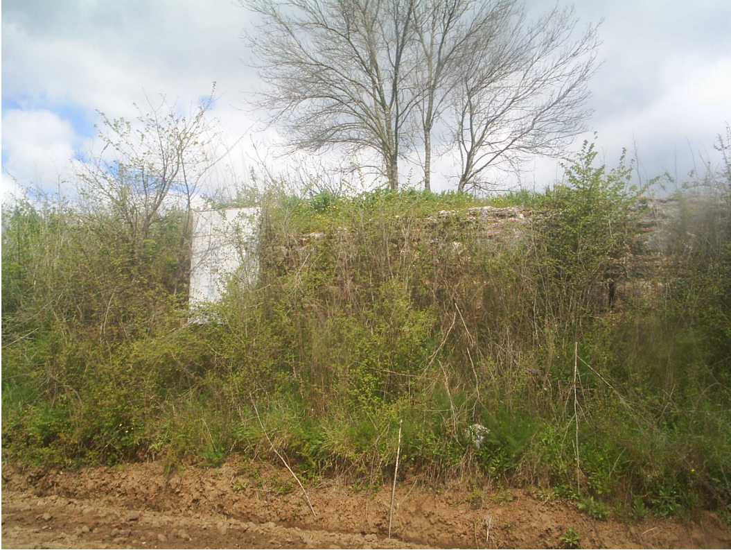
Fotoğraf 297 Akköprü Genel Görünüş
