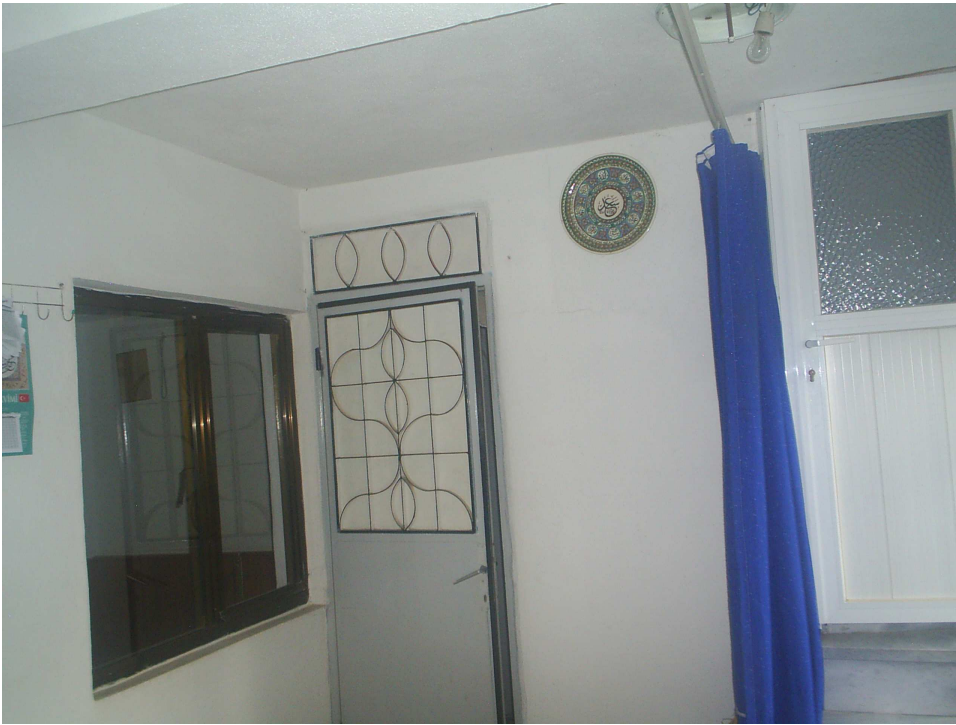
Fotoğraf 174 Caminin Kuzeybatısında Yer Alan Minare ve Kadınlar Mahfiline Çıkışı Sağlayan Kapılar
