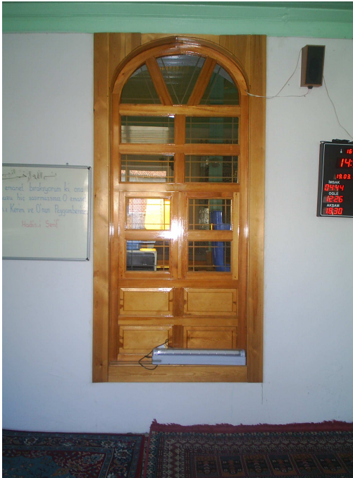
Fotoğraf 95 Giriş kapısının iki yanındaki kemerli pencerelerden ayrıntı
