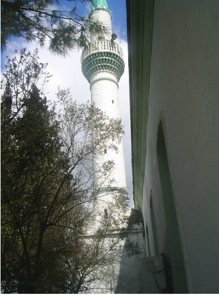
Fotoğraf 272 Yapının Kuzeybatısında Bulunan Minare Görünüő.
