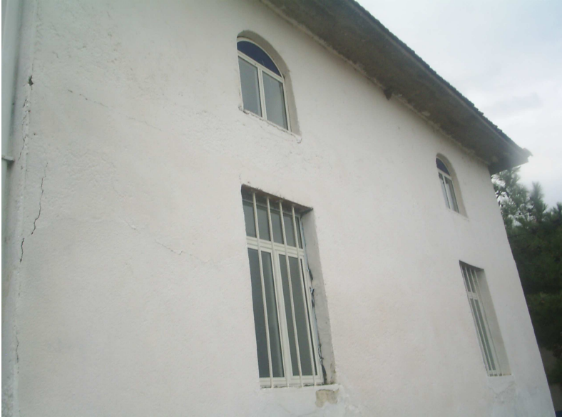
Fotoğraf 220 Güney cephe genel görünüş
