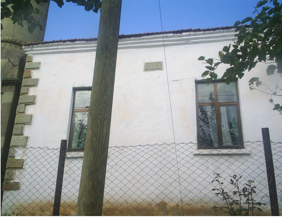
Fotoğraf 186 Güney cephe genel görünüş
