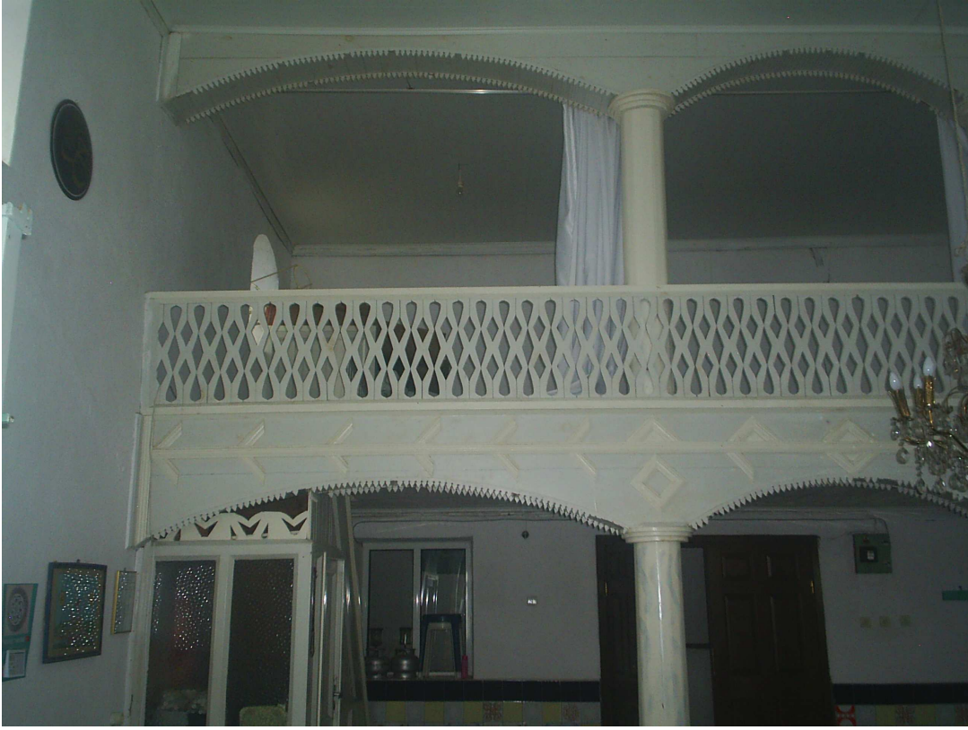
Fotoğraf 226 Giriş mekânının batısında yer alan kadınlar mahfiline çıkışı sağlayan merdiven kısmı
