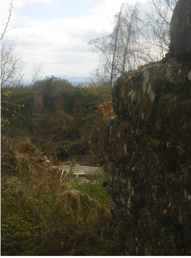
Fotoğraf 291 Kesme Taş Örgülü Köprü Ayağının Görünümü.
