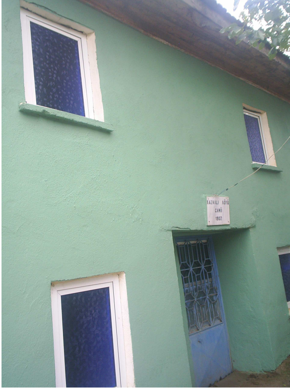
Fotoğraf 239 Yapının kuzey cephesinin genel görünüşü
