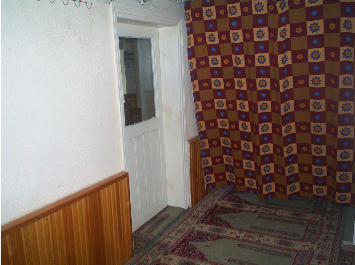
Fotoğraf 243 Kuzeydoğudaki giriş kapısından ulaşılan giriş mekânı
