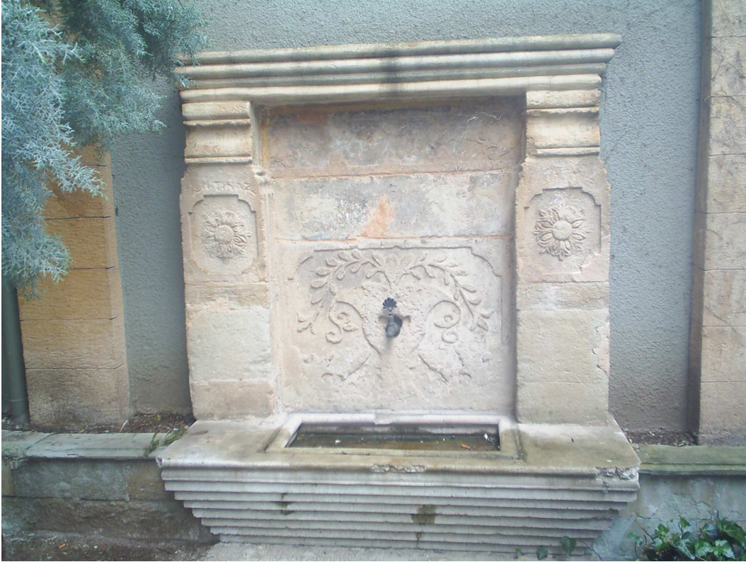
Fotoğraf 314 Yalak Kısımını Taşıyan Sonradan Yapılmış Kısımın Genel Görünüş
