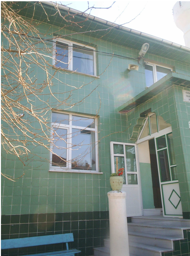
Fotoğraf 89 Kuzey cephedeki pencerelerin görünümü
