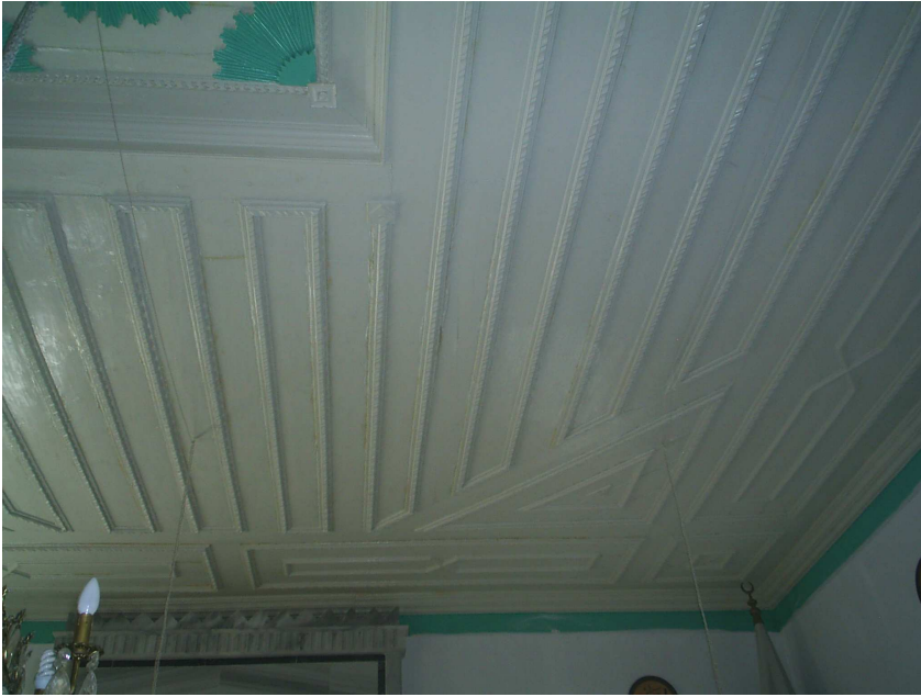
Fotoğraf 279 Tavanı Kaplayan Ahşap Malzeme
