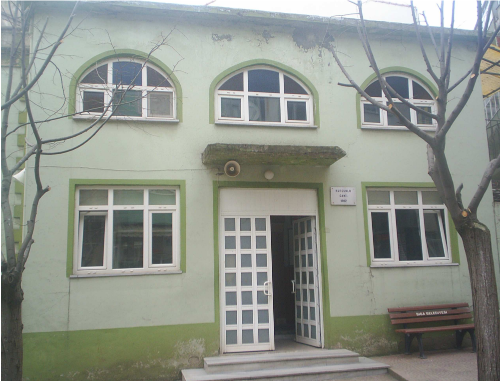
Fotoğraf 69 Caminin Kuzey Cephesi
