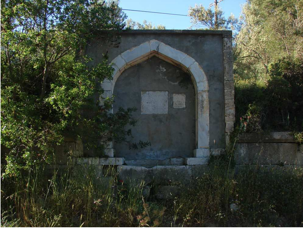
Fotoğraf 323 Kilitbahir Havuzlar Mevkiindeki Çeşme
