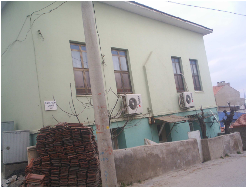
Fotoğraf 16 Yapının güney cephesi genel görünüşü
