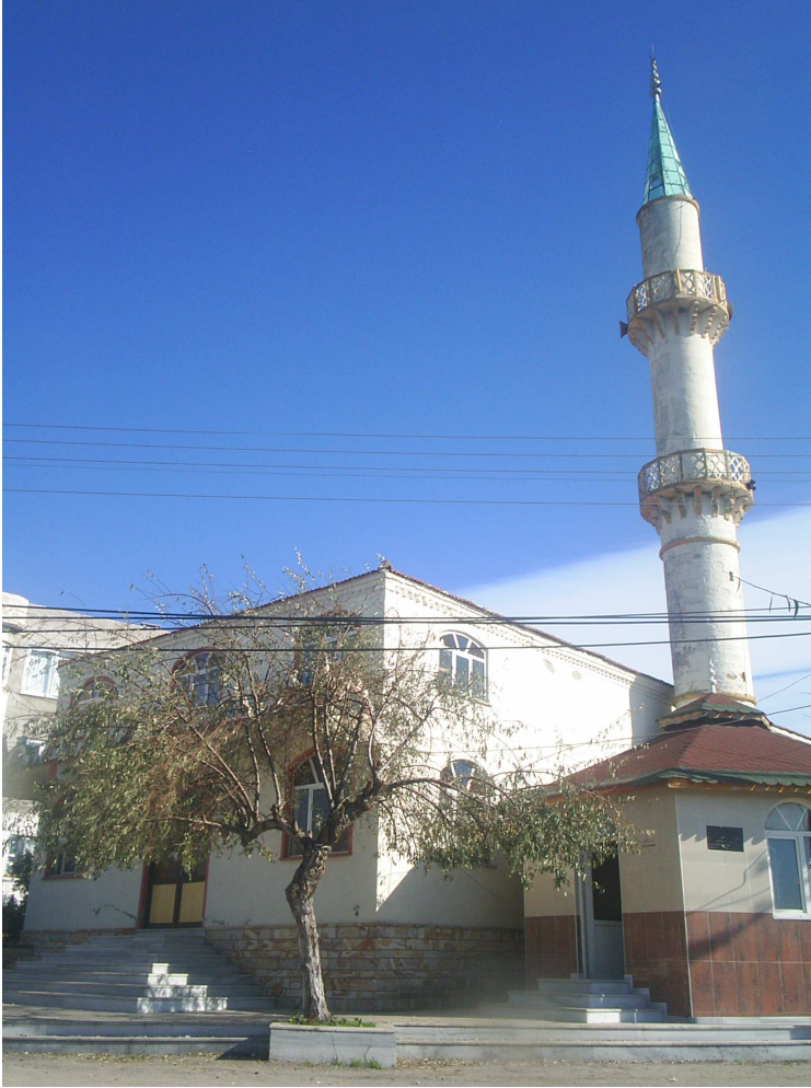
Fotoğraf 255 Kemer Köyü Cami Genel Görünüş
