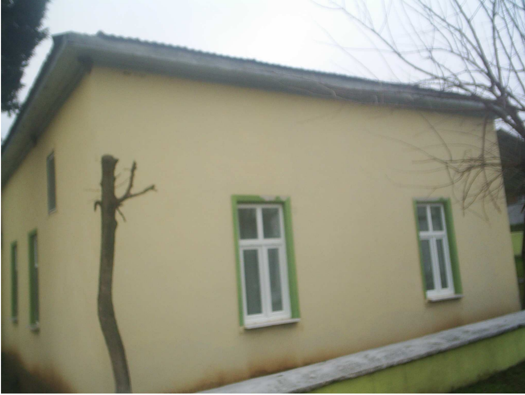
Fotoğraf 204 Güney cephesi genel görünüş
