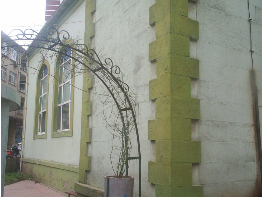
Fotoğraf 66 Kurşunlu Cami Doğu Cephesi
