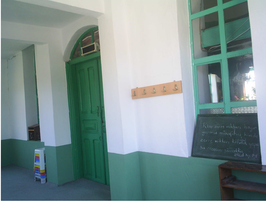
Fotoğraf 137 Yapının asıl giriş kapısının bulunduğu kuzey cephe
