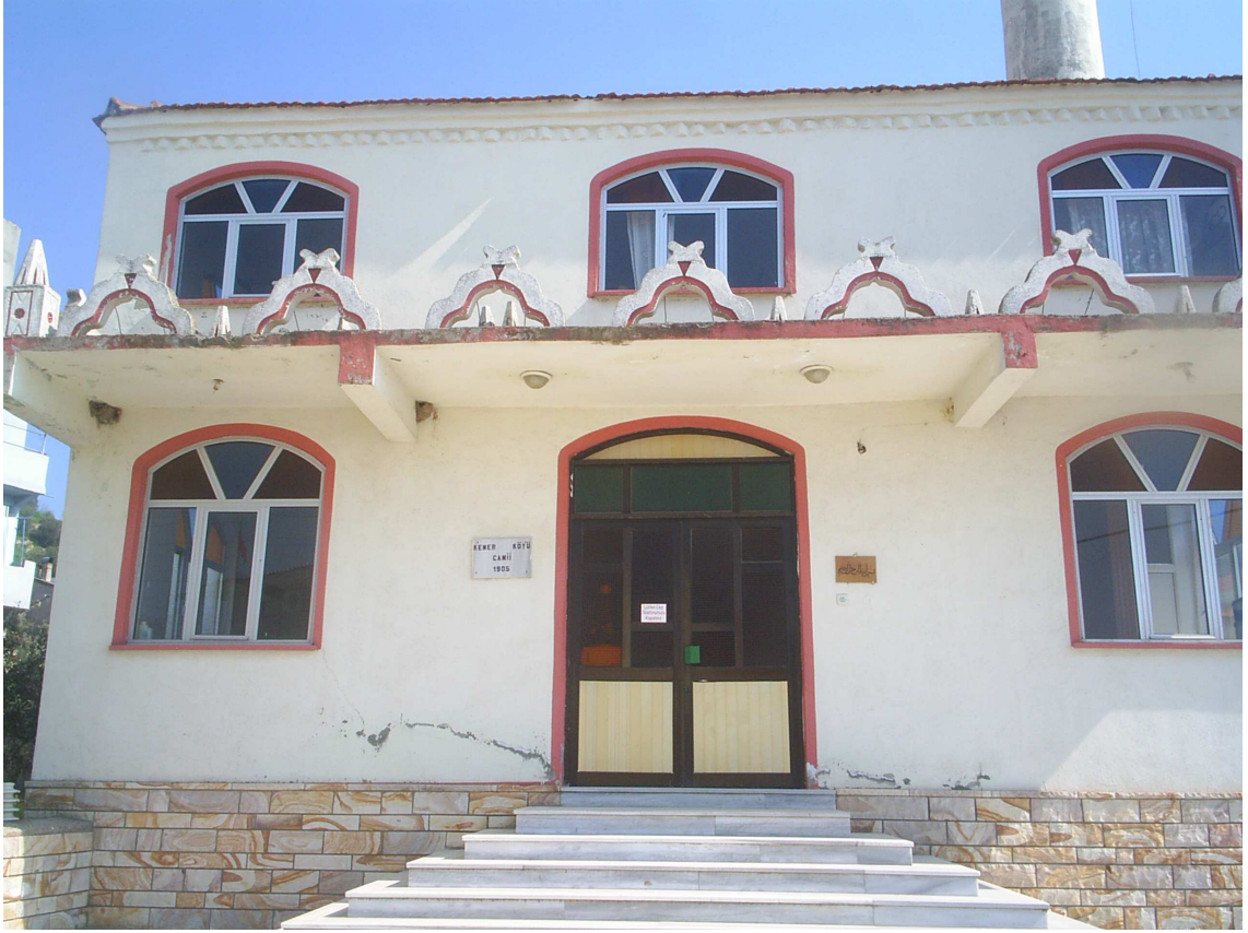
Fotoğraf 256Yapının Kuzey Cephesi
