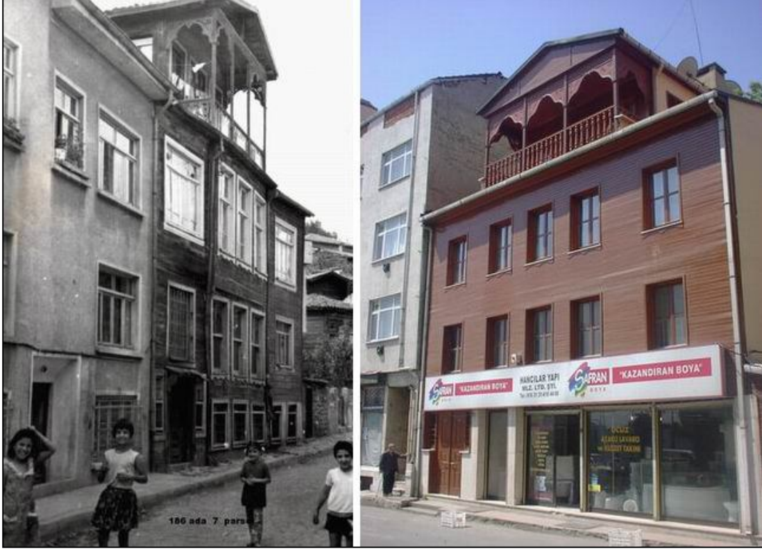
Şekil G. 11 : 186 ada 7 parseldeki eserin eski yeni durumu.
