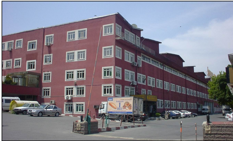
Şekil H. 13 : 98 ada 1 parseldeki İBB Halk Ekmek Fabrikası- İBB PLMD.
