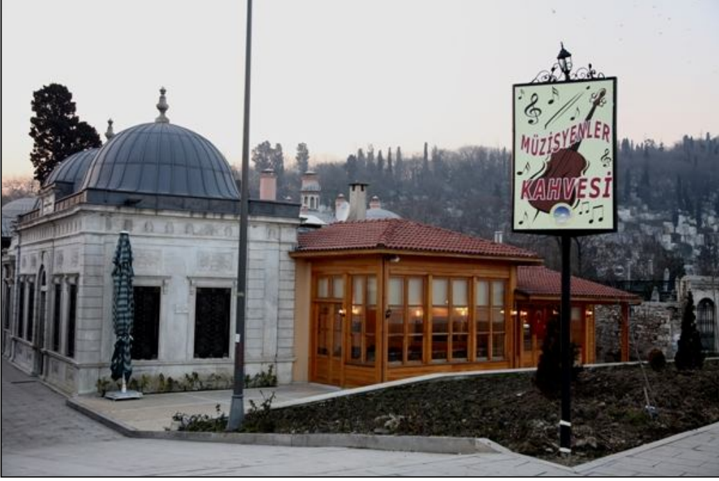
Şekil 4. 18 : Müziyenler Kahvehanesi'nin yeniden yapımı sonrası görünümü- EİB.
