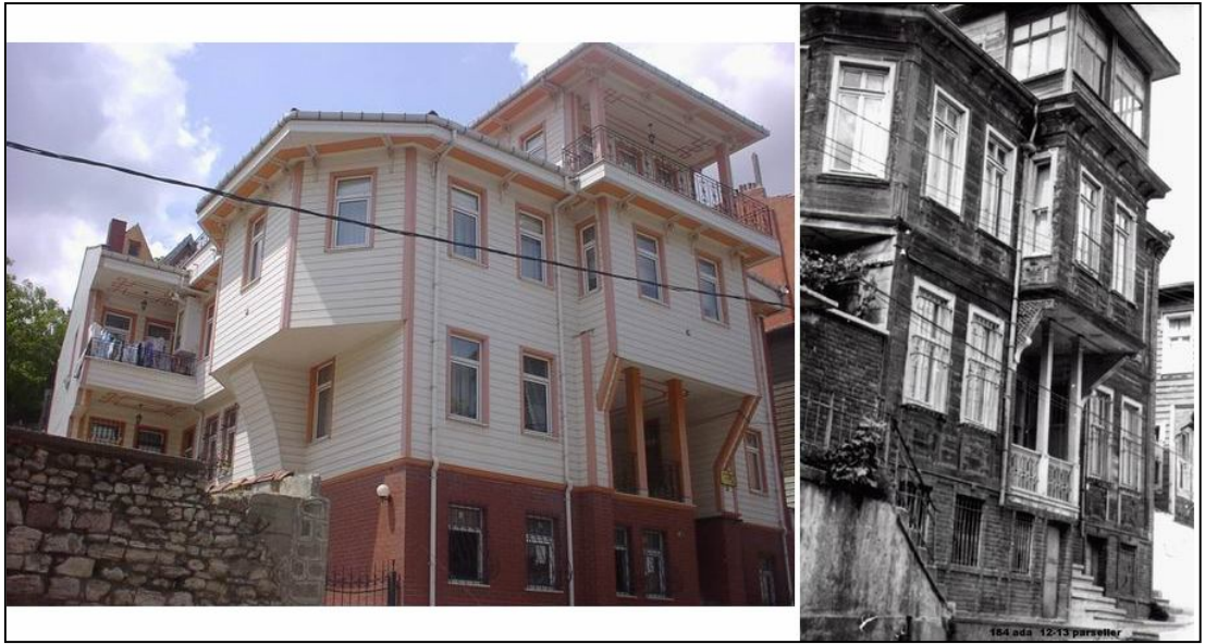
Şekil G. 6 : 184 ada 13 parseldeki eserin eski yeni durumu.
