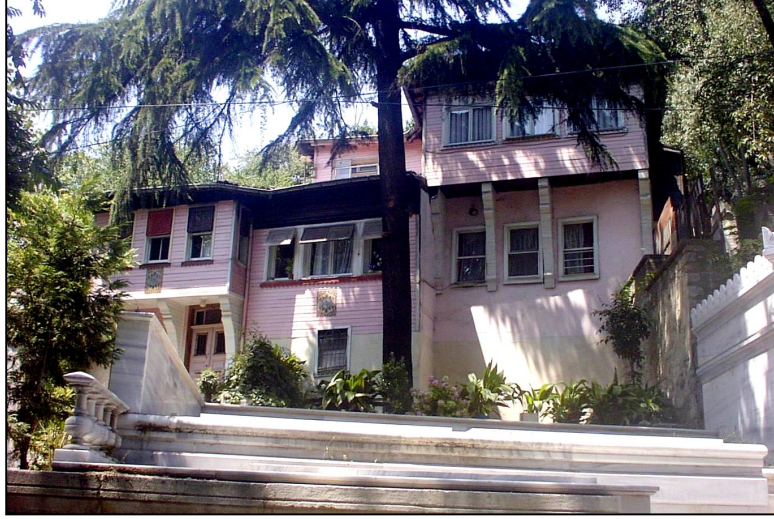
Şekil H. 11 : 54 ada 19 parseldeki SMÖ- İBB PLMD.
