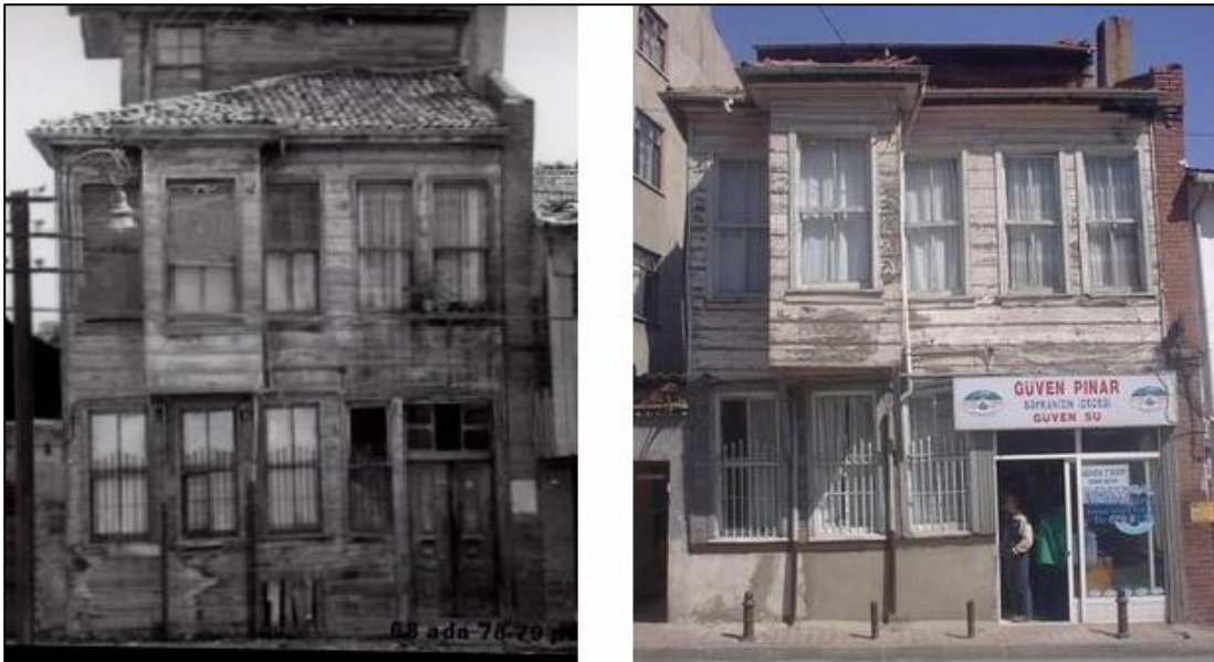
Şekil G. 4 : 68 ada 79 parseldeki eserin eski-yeni durumu.
