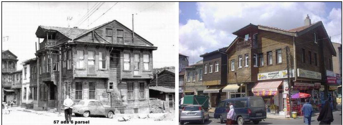
Şekil G. 10 : 57 ada 6 parseldeki eserin eski yeni durumu.
