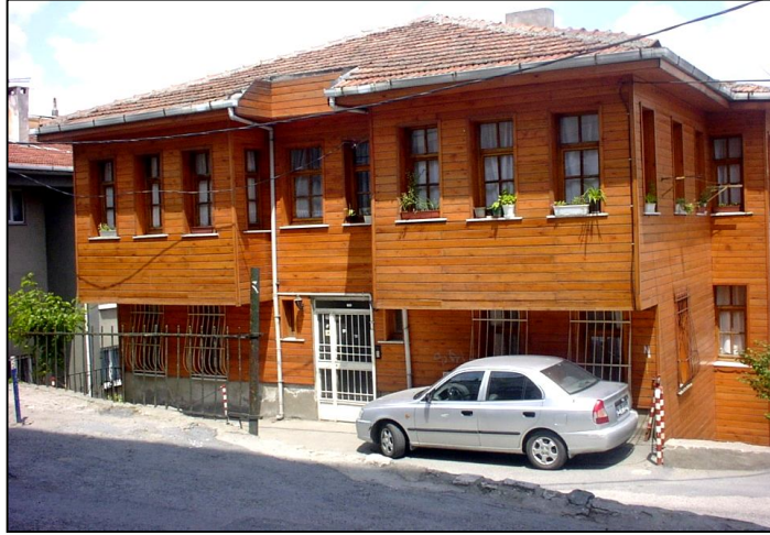
Şekil H. 9 : 56 ada 18 parseldeki SMÖ- İBB PLMD.
