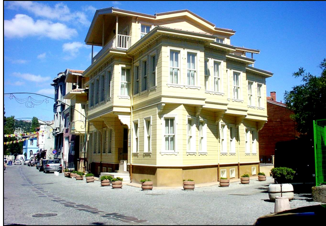
Şekil H. 10 : 51 ada 22 parseldeki SMÖ- İBB PLMD.
