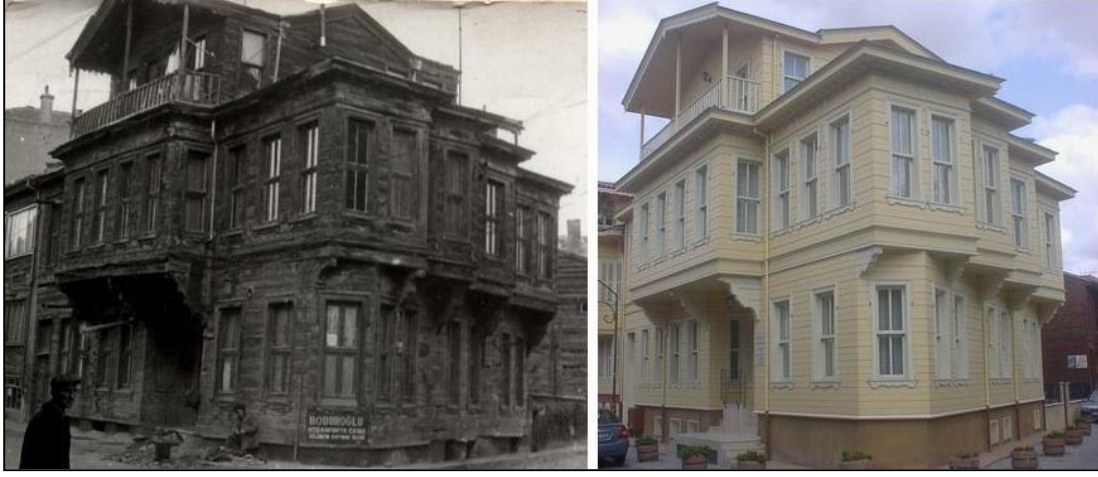
Şekil G. 2 : 51 ada 22 parseldeki eserin eski-yeni durumu.
