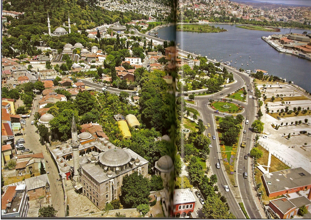
Şekil H. 4 : Eyüp Sultan Camii ile Zal Mahmut Paşa Camii arasındaki doku- EİB Eyüp Rehberi.
