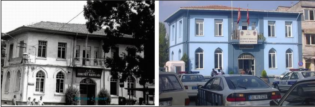
Şekil G. 7 : 203 ada 1 parseldeki eserin eski yeni durumu.
