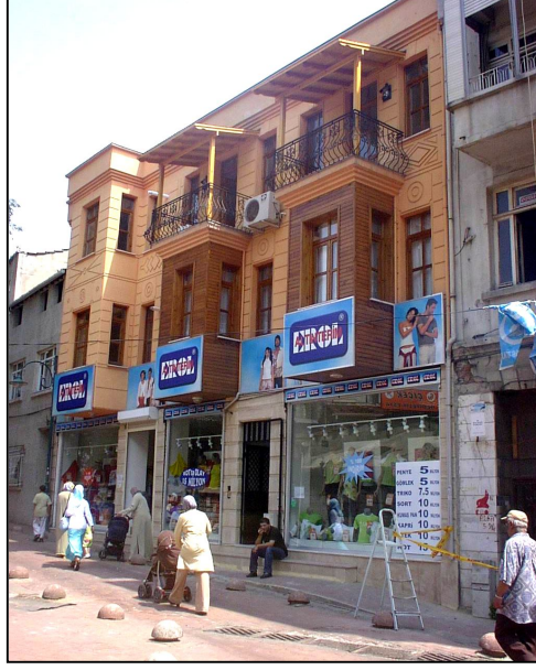
Şekil H. 8 : 28 ada 79 parselde farklı bir uygulama- İBB PLMD.
