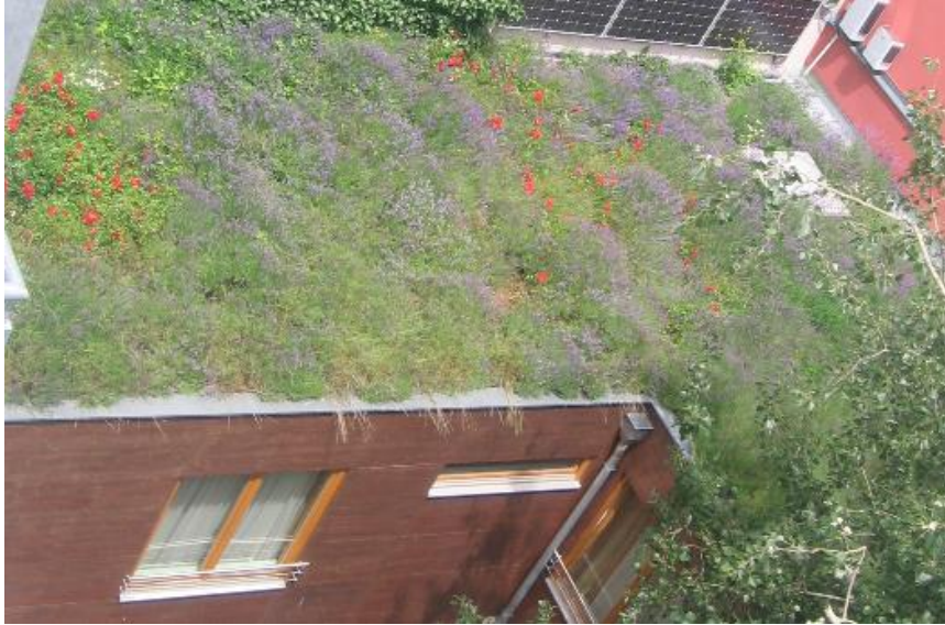
Şekil 3.31 : Lavanta çatı bahçesi.
