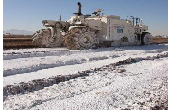
d) Keçi ayaklı silindir ile kirecin zemin ile karıştırılması
