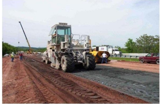
b) Zemin ile uçucu külün karıştırılması
