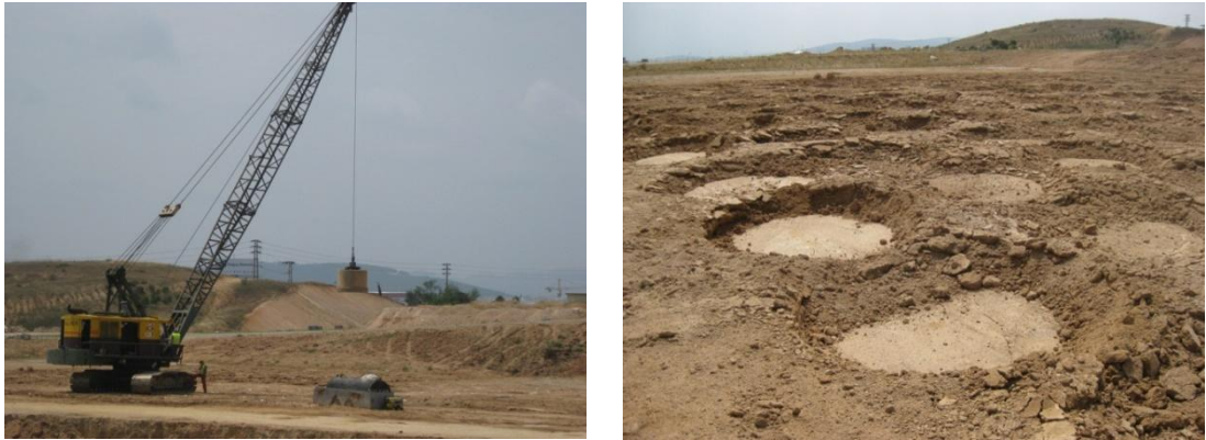
Şekil 2.1 Dinamik Kompaksiyon Uygulaması ve Oluşan Kraterler (Şengezer, 2010)
