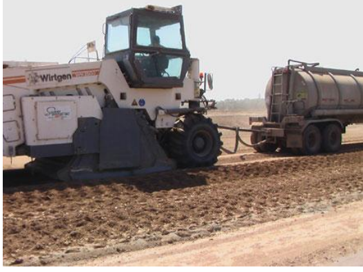
a) Zemin ile çimentonu su yardımı ile b) İş makinaları ile CTB (Cement karıştırılması (Çimento oranı %6) Treated Base) oluşturulması
