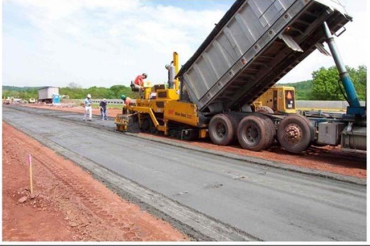
a) Uçucu külün dağıtıcıya aktarılması
