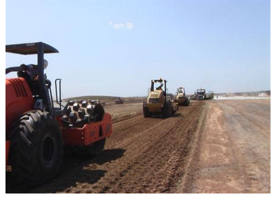
a) Zemin ile çimentonu su yardımı ile b) İş makinaları ile CTB (Cement karıştırılması (Çimento oranı %6) Treated Base) oluşturulması
