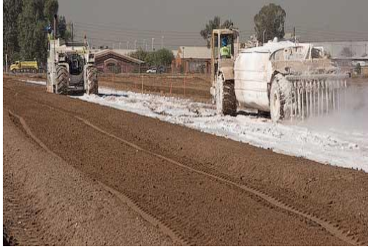
c) Bilgisayar kontrollü dağıtıcının kireci zemin yüzeyine dağıtması
