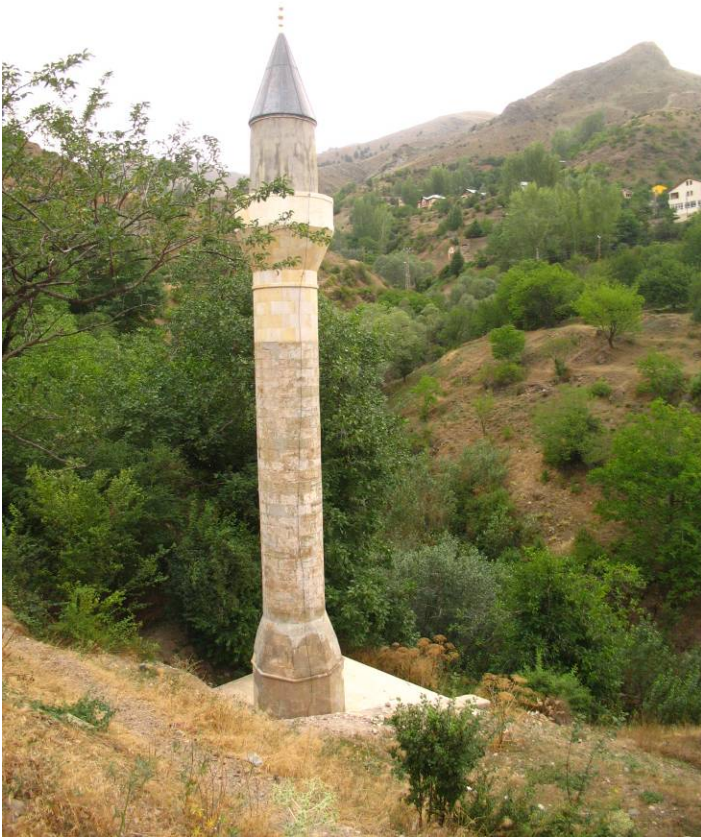
Şekil B.43 : Dere Camii Minaresi
