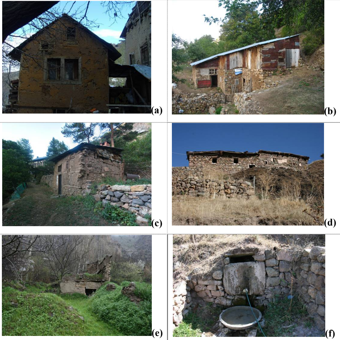
Şekil 3.24 : Tescili önerilen ek yapı örnekleri: (a) Ruhiye Özdamar Küçük Evi (Env.No:9d), (b) üst kat yıkılmış ve ahıra dönüştürülmüş yapı (Env.No:107e), (c) Fahri Gümüşeli Evi Fırını (Env.No:112d), (d) üst kat yıkılmış ve ahıra dönüştürülmüş yapılar (Env.No:129d-e), (e) Kadirbeyzade Zeki Bey Konağı bahçesinde konut harabesi (Env.No:28), (f) Çeşme (Env.No:130)
