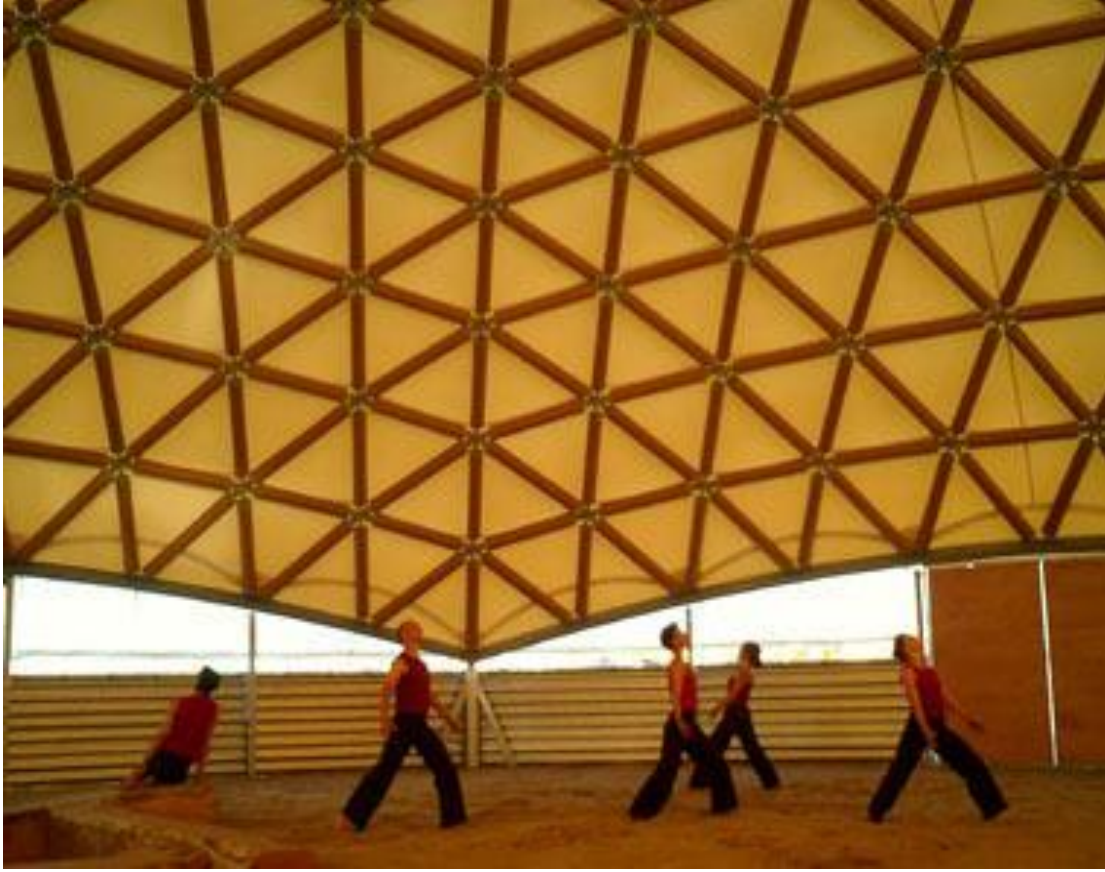
Şekil 3.12: Bir mim grubu tarafından Hollanda Amsterdam’da kullanılan atık kağıt ve geri dönüştürülmüş malzemeden yapılmış Ban tasarımı “Göçebe Tiyatro Kubbesi”. kaynak: shigerbanarchitects.com
