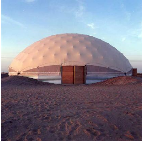
Şekil 3.11: Bir mim grubu tarafından Hollanda Amsterdam'da kullanılan atık kağıt ve geri dönüştürülmüş malzemeden yapılmış Ban tasarımı “Göçebe Tiyatro Kubbesi”. kaynak: shigerbanarchitects.com
