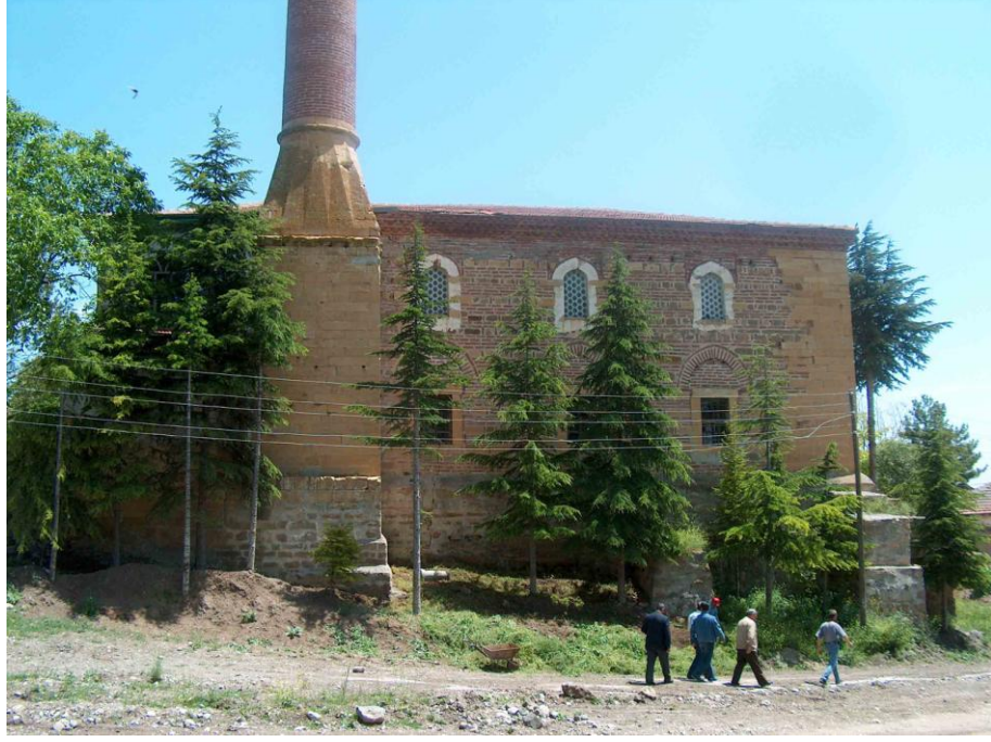
Şekil 3.2 Taş tuğla karışımı taşıyıcı kargir duvar (Bayraktar, 2006)
