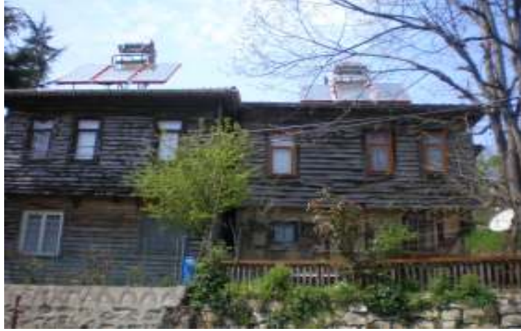
Şekil 3. 1: İmrenli Köyünde ORKÖY Kredisi İle Alınmış Güneş Enerjisi Sistemleri
