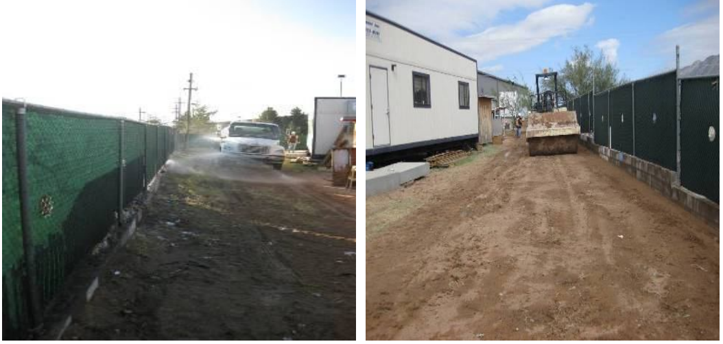
Şekil 3.9. Seçilen arazinin temizlenip, uygun su muhtevasına getirilip sıkıştırılması
