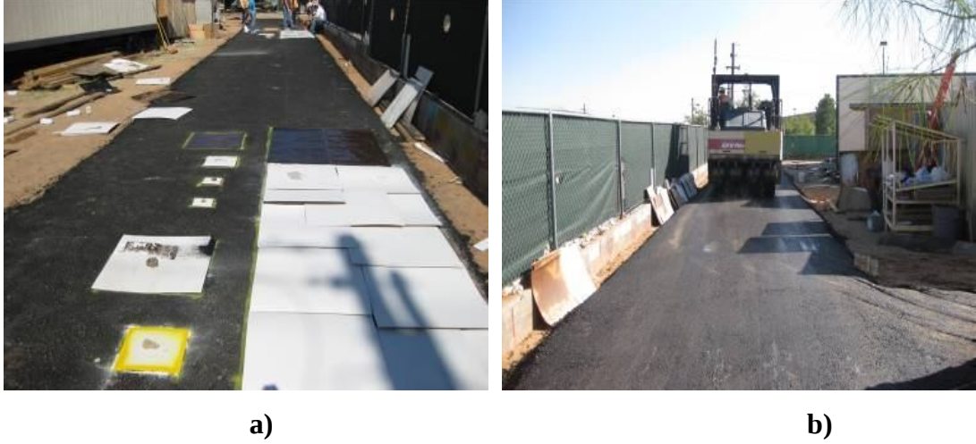
Şekil 3.15. Sıcak karışım üst yüzey tabakanın inşa edilmesi
