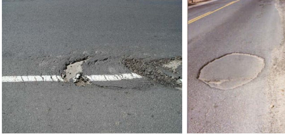
Şekil 2.18. Tabakalar arasında ayırışmanın sebep olduğu tipik bir bozulma örneği
