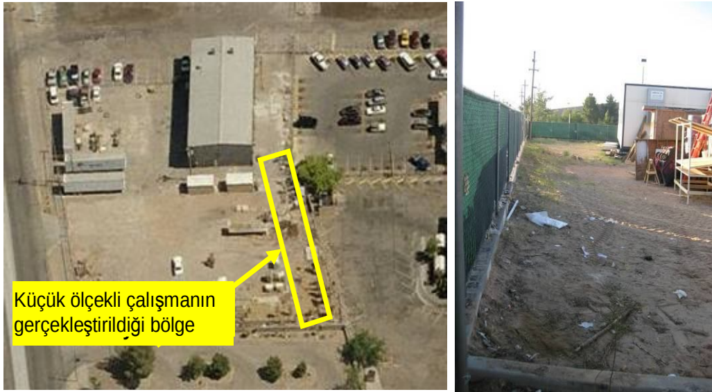
Şekil 3.6. UTEP’ te asfalt kesitlerin inşa edileceği bölge
