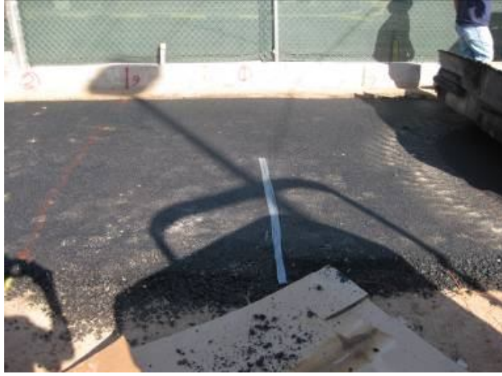
Şekil 3.12. Asfalt temel üzerine ısı ileten tellerin yerleştirilmesi
