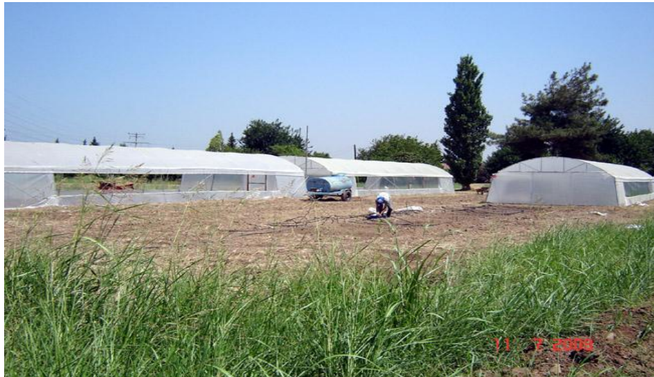
Şekil 3.7. Sera yapımı ve parsel hazırlığı
