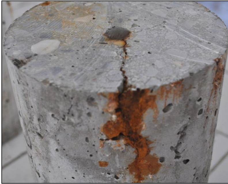
Resim 4.1 Betonarme numunede korozyon akımı oluşan çatlak görüntüsü
