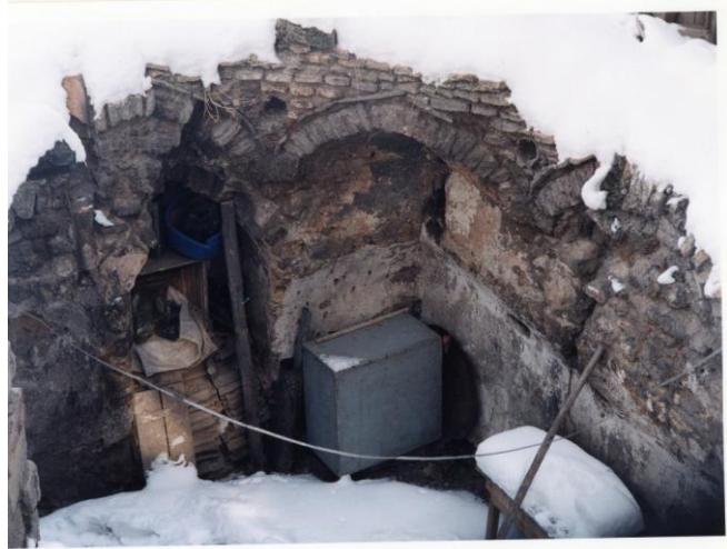
Hamamın iç'ten görünüşü
