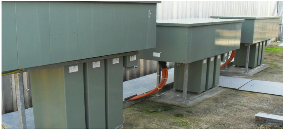
Şekil 3.2. 1600 kVAR, 800 kVAR ve 800 kVAR kondansatör bankları
