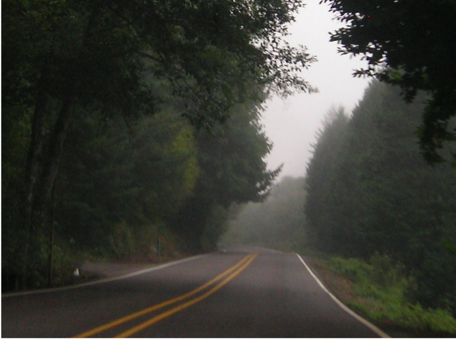
Şekil 1.21. Asfalt kaplama yol görüntüsü
