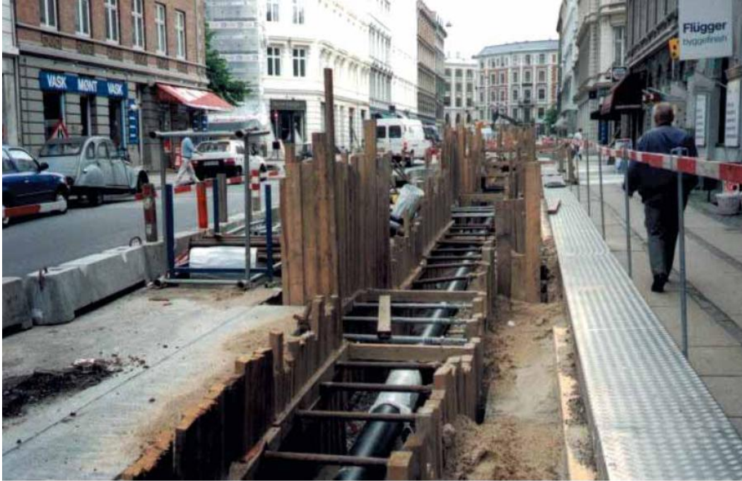
Şekil 2.12 400 adet bölge enerji sistemi
