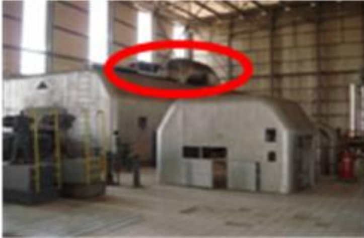
Şekil 4.1 Yatağan Termik Santrali atık ısının alınacağı deve boynu
