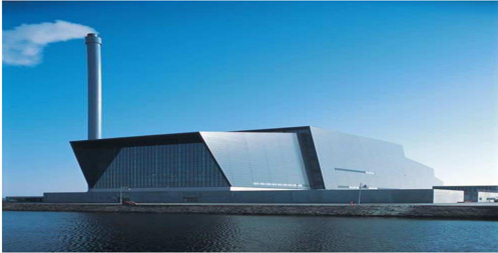
Sekil 2.10 Danimarka’da, 2003’de bölgesel ısıtma yapmak üzere kurulan bir çöp yakma santrali (Anonim d, 2009)
