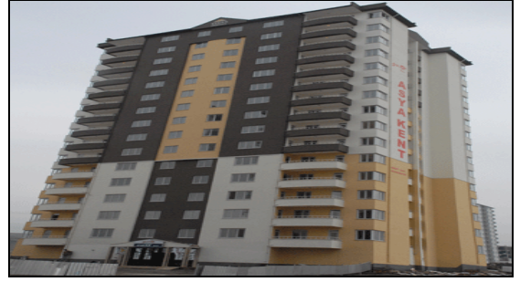
Şekil 5.12. Asya kent konut yapı kooperatifi yapı durumu 2 [66].
