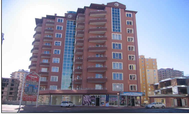
Şekil 5.8. Doğantay kent-Talas toplu konut yapı kooperatifi genel görünüm [65].
