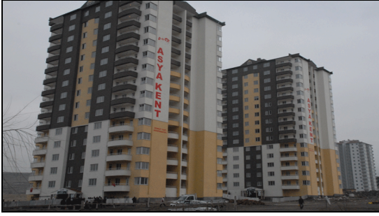
Şekil 5.11. Asya kent konut yapı kooperatifi yapı durumu [66].
