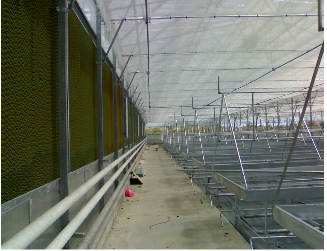
Şekil 2.7. Ped ünitesinin sera kenarı boyunca yerleşimi
