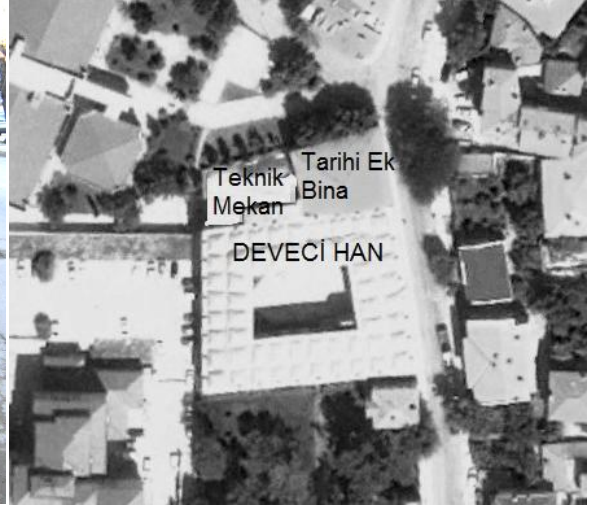
Şekil 4.108. Tarihi ek bina ve teknik mekân (google earth)
