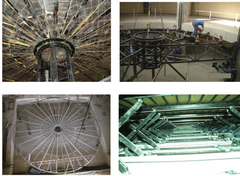
( Resim 98: Döner Sahne Konstrüksiyonu )
