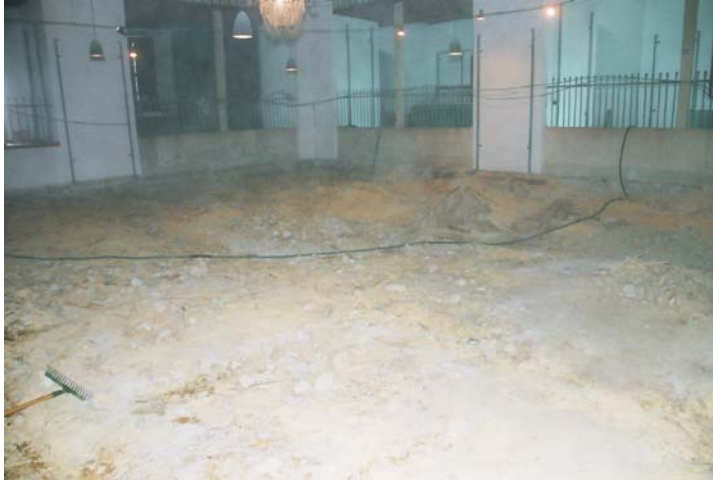
Şekil 2.9 Semahane zemininin kazı sonrası durumu
