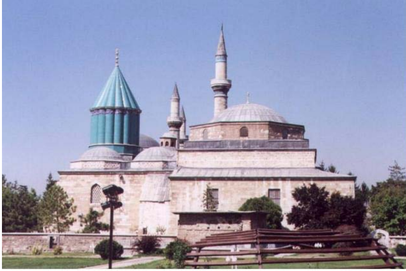
Şekil 1.1 Mevlana müzesi arka cephe görünüş
