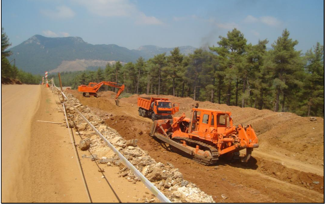
Foto 4.8. Fındıkpınarı yolu çalışmalarından bir görünüm
