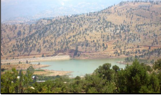
Foto 1.16. Arslanköy Sulama Göleti
