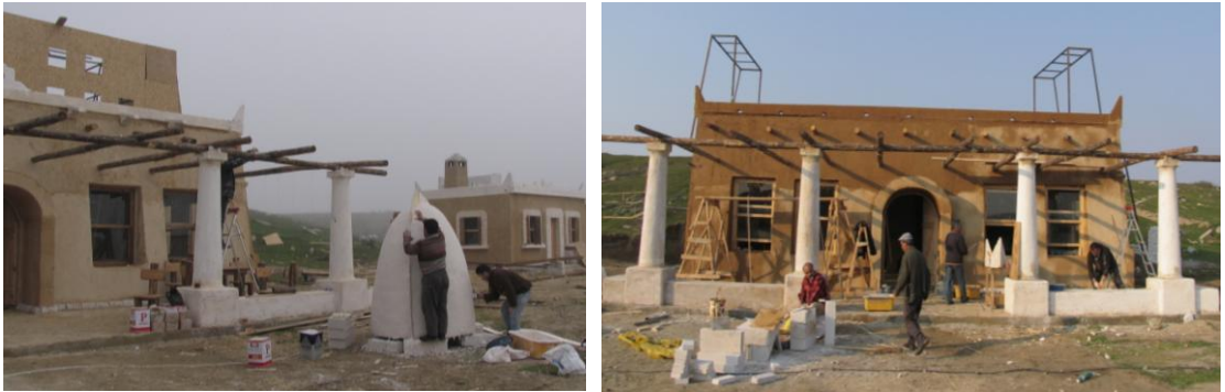
Şekil 4.16: Kahvehanenin yapım aşaması (MZÜ'nün arşivinden)
