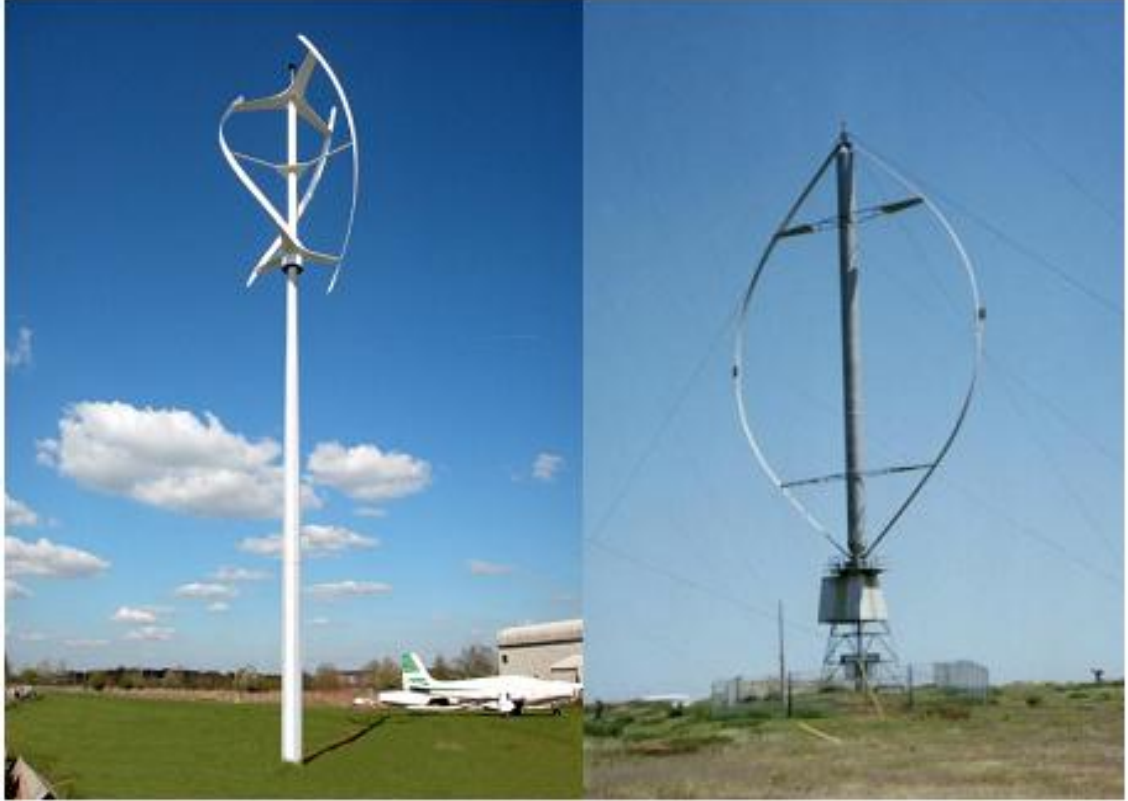
Şekil 3.8. Darrieus Tipi Rüzgar Türbini
