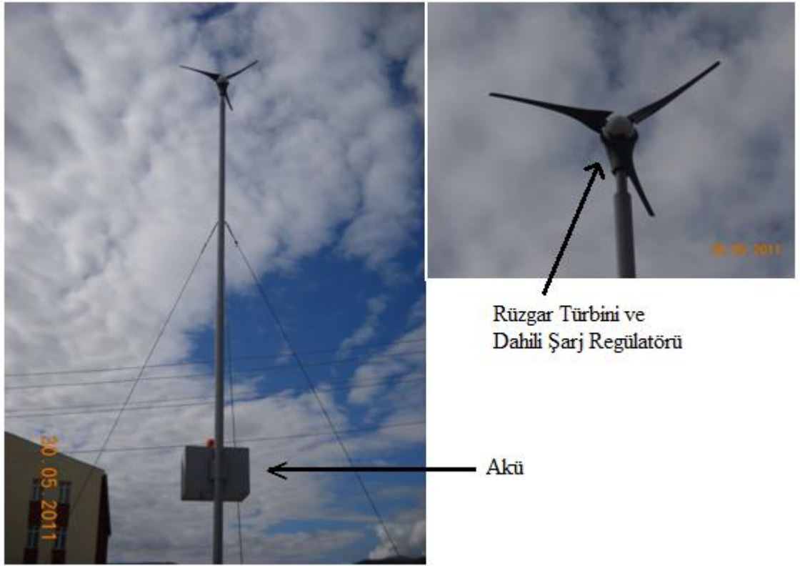
Şekil 5.3. Şarj Regülatörü ve Akü Birimini de İçeren Rüzgar Türbininin Montajı Yapılmış Hali
