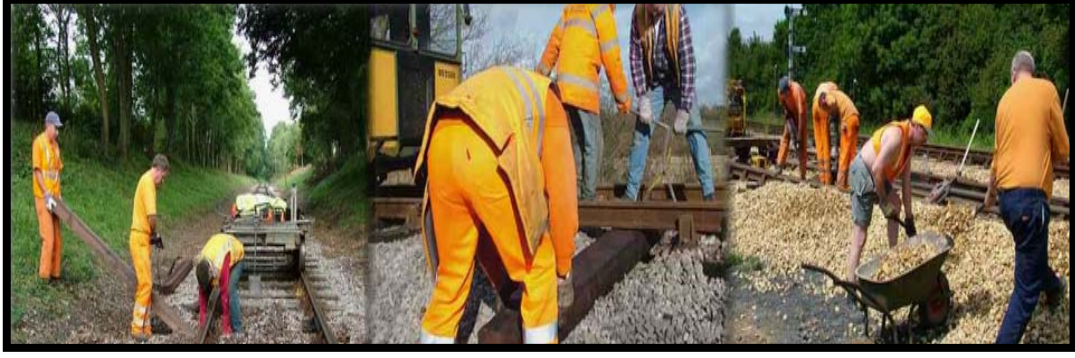
Şekil 1.42. Balastlı Hatlarda Travers Değiştirme
