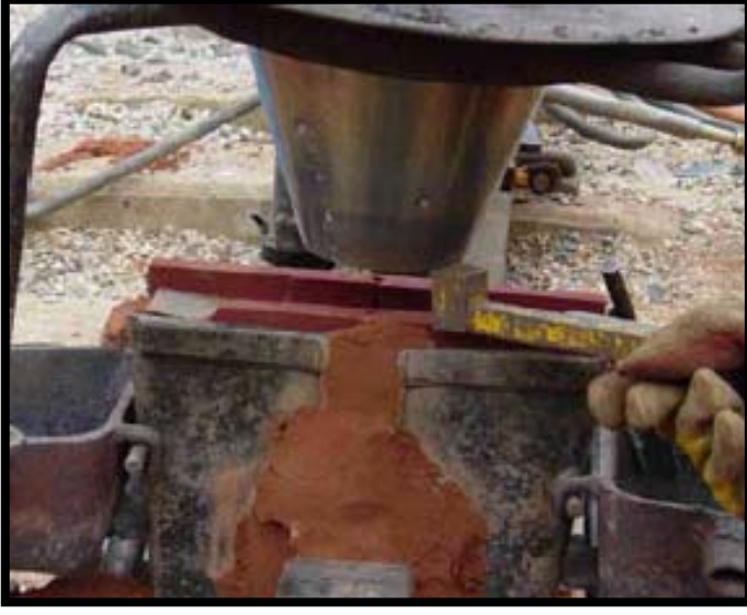
Şekil 1.39: Termit Potasının Yerleştirilmesi
