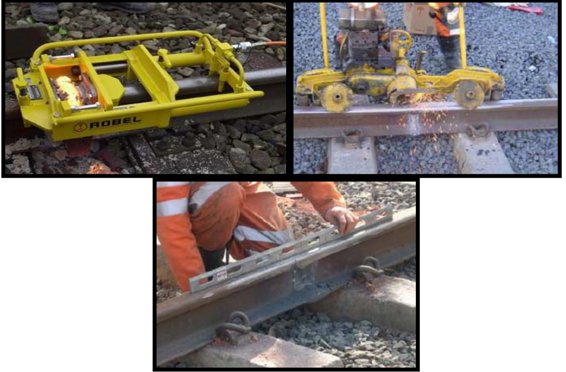
Şekil 1.41: Kaynağın Sıyırma Makinesi ile Tıraşlanması ve Rayın Taşlanması
