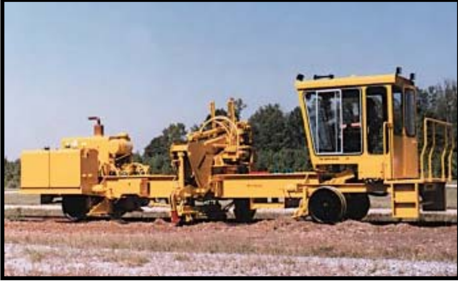
Şekil 1.43. Travers Değiştirme Makinesi ile Travers Değiştirme
