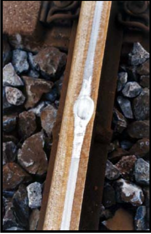
Şekil 1.63. Kaynak Noktalarındaki Problemler
