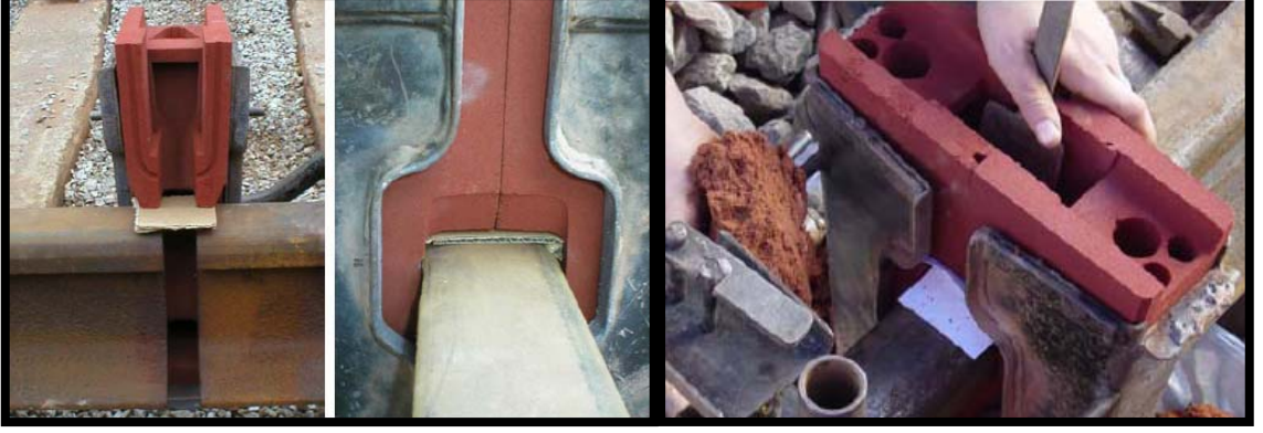
Şekil 1.37. Kaynak Kalıplarının Montajı ve Kumlama
