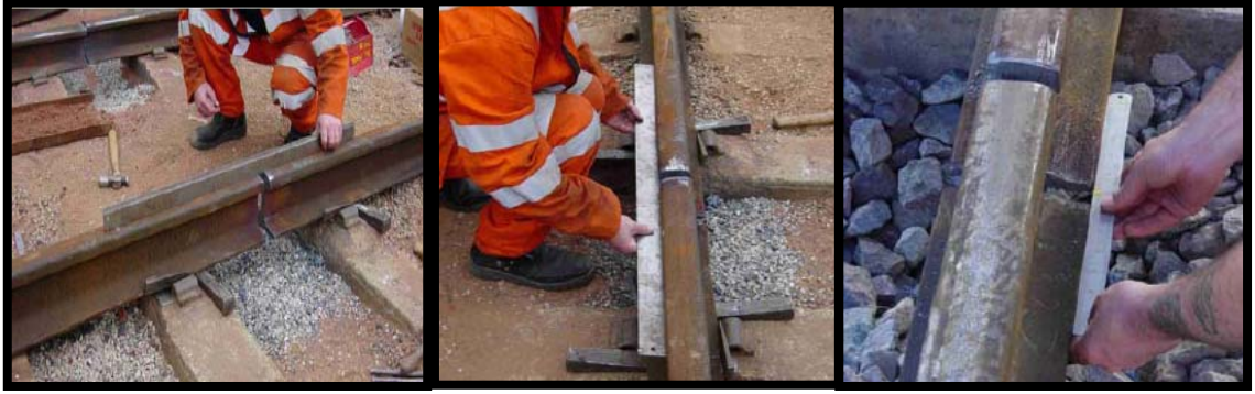
Şekil 1.35. Ray Yan Yüzeyinin ve Tabanının Mastara Getirilmesi
