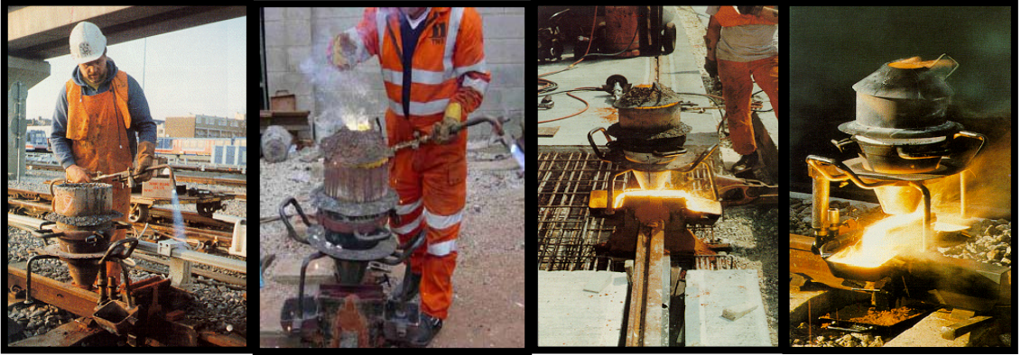
Şekil 1.40. Rayların Isıtılması ve Termit Porsiyonun Erimesi
