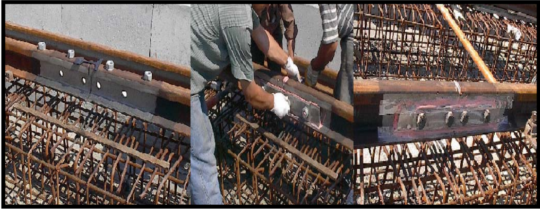
Şekil 1.57. Yeni İzolecebre Raylarının Yapılması
